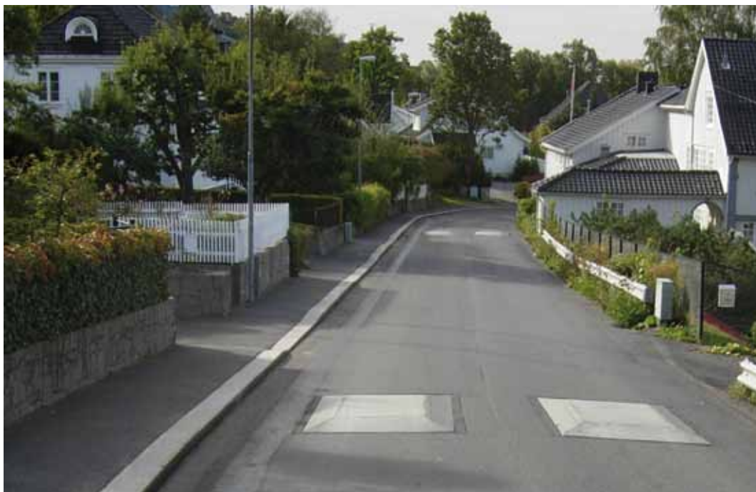
Bussputer i betong i Drøbak.
