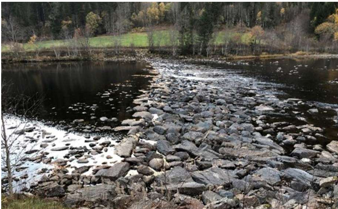
Figur 3. Terskel i Nea som på veldig høye vannføringer vil være dykket og derfor er en delvis virksam barriere (foto: Berit Köhler/NINA).
