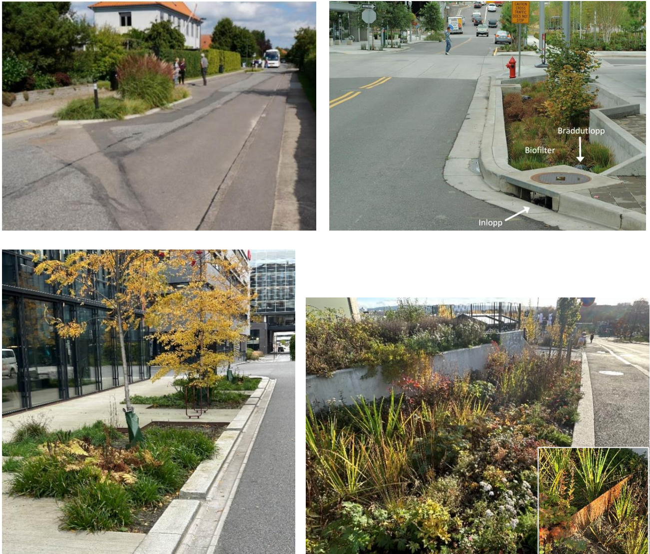
Figur 37. Eksempel på lokal filterløsning (regnbed/biofilter) etablert i dansk og svensk gate (venstre/høyre øverst). Nederst eksempler på filterløsninger i Oslo etablert i nye utbyggingsprosjekter i byen. I venstre bilde burde jorddekket vært mer nedsenket for å oppnå mer magasinering og lette innstrømningen fra veibanen. Høyre bilde viser innfelt terskel i cortensstål som bidrar til magasinering av vann i et anlegg med lengdefall. Lokale filterløsningen har fått stor utbredelse i de nordiske tettsteder og byer. (Foto: Oslo kommune Vann- og avløpsetaten, Stockholm kommune og COWI).
