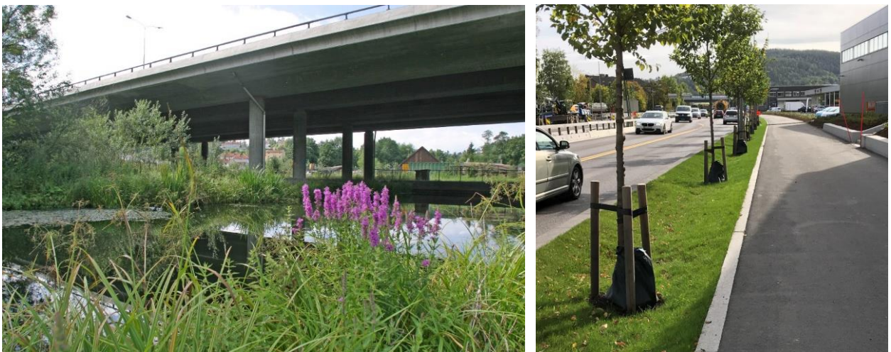
Figur 3. Eksempler på naturbaserte løsninger (overvannsdam og regnbed/filtergrøft) for rensing av overvann fra motorvei og hovedgate (Foto: COWI).
