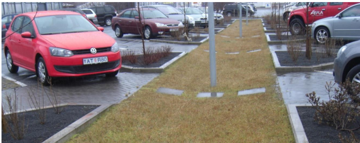
Figur 41. Eksempel på nedsenket vegetasjonsdekket filterløsning for rensing av overvann på parkeringsplass i Reykjavik (Foto; Tore Leland).
