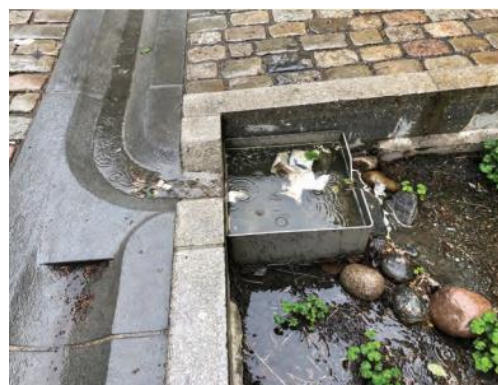
Figur 36. Regnbed i gatetun i byområde (venstre). Bildet til høyre viser innløpsløsning til regnbed med slamkasse (størrelsen tilpasses tilrenningsarealet og forurensningsbelastningen). Overvannet samles i renner som leder til regnbedene (foto: Oslo kommune, Vann- og avløpsetaten).
