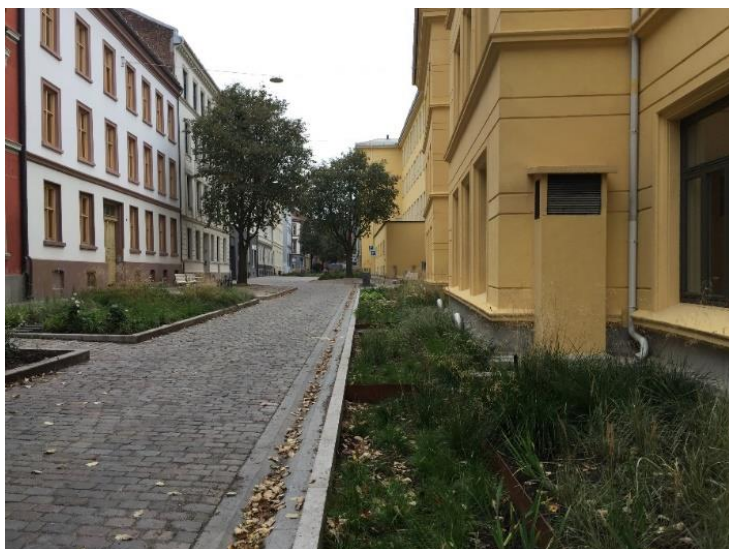
Figur 36. Regnbed i gatetun i byområde (venstre). Bildet til høyre viser innløpsløsning til regnbed med slamkasse (størrelsen tilpasses tilrenningsarealet og forurensningsbelastningen). Overvannet samles i renner som leder til regnbedene (foto: Oslo kommune, Vann- og avløpsetaten).
