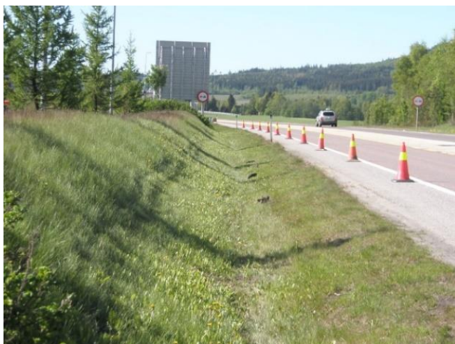
Figur 43. Hovedvei med infiltrasjon og rensing av overvann i filtergrøft, avrenning fra 3 kjørebane til avbildet grøft (kegler satt opp i forbindelse med pågående infiltrasjonsundersøkelse i grøfta). Terskler er ikke synlige på bildet. Forurensninger, slitasjeprodukter og støv fra veien akkumuleres i toppsjiktet i grøfta og vises som mørkfarget toppsjikt i høyre foto. Veien har vært i drift i 15 år, E6 Minnesund. (Foto: COWI).
