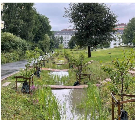
Figur 38. Langstrakt vegetasjonsdekket filterløsning/regnbødd for rensing av overvann i bygate. Løsningen både magasinerer og renser overvannet og er i tillegg flomvei ved ekstremnedbør. Filterflaten (vekstjorda) ligger nedsenket i forhold til gatenivået (fortau/kjørebane).
