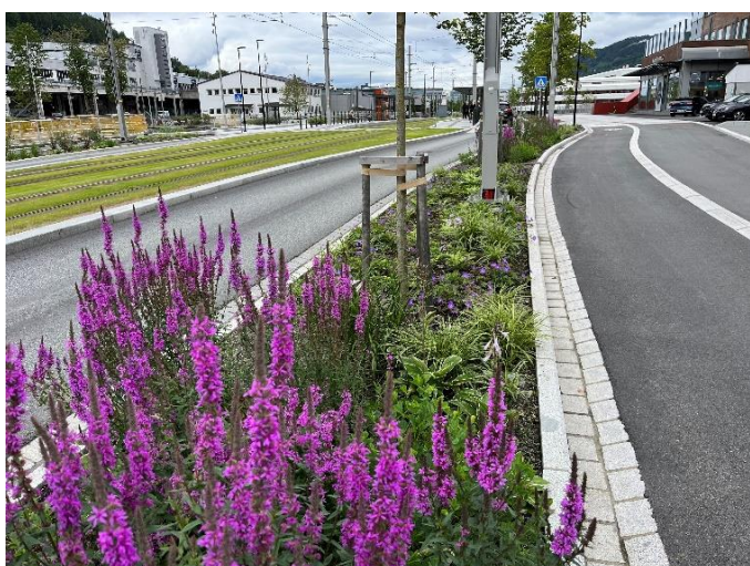
Figur 38. Langstrakt vegetasjonsdekket filterløsning/regnbødd for rensing av overvann i bygate. Løsningen både magasinerer og renser overvannet og er i tillegg flomvei ved ekstremnedbør. Filterflaten (vekstjorda) ligger nedsenket i forhold til gatenivået (fortau/kjørebane).
