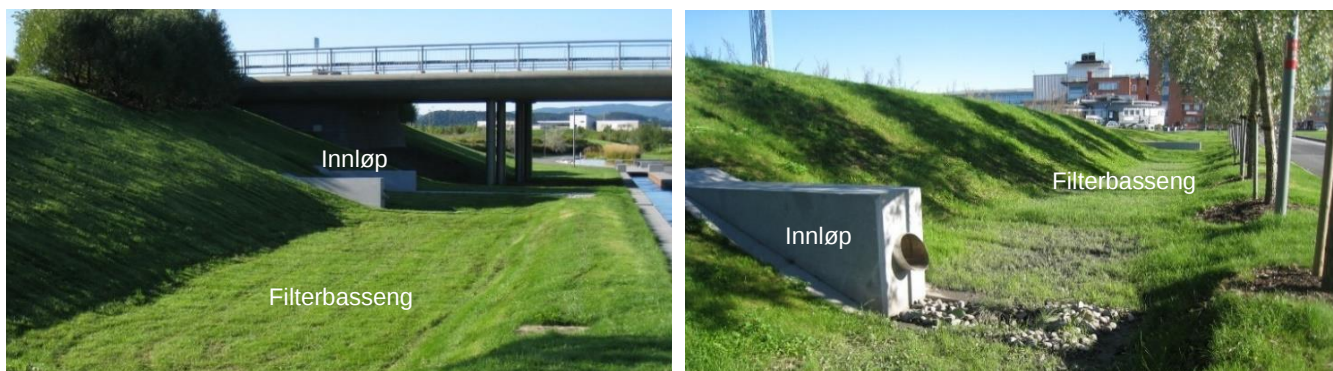
Figur 31. Eksempler på filterbassenger som mottar overvann fra trafikkarealer i byområde. Bassengene er innpasset i en grøntstruktur. Forsedimentering skjer i sandfang langs veiene (Foto: COWI).
