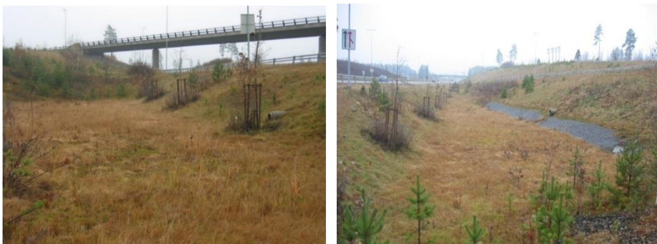
Figur 27. Eksempel på infiltrasjonsbasseng langs hovedvei, innløp i høyre bildekant. Bassenget er utgravid i stedlige naturlige løsmasser. Overvannet forsedimenteres i sandfang langs veien (foto: COWI).
