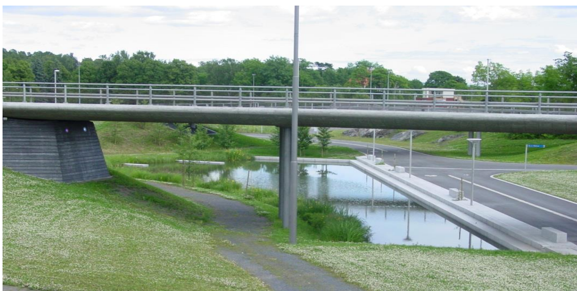
Figur 22. Eksempel på velfungerende overvannsdam for rensing av overvann fra 4-felts vei og g/s-arealer som kombinerer rensing, fordrøyning og god landskapstilpasning i et nytt byområde. Innløpet og forsedimenteringen ligger nærmest i fotoet (Fornebu, Bærum kommune) (foto: COWI).
