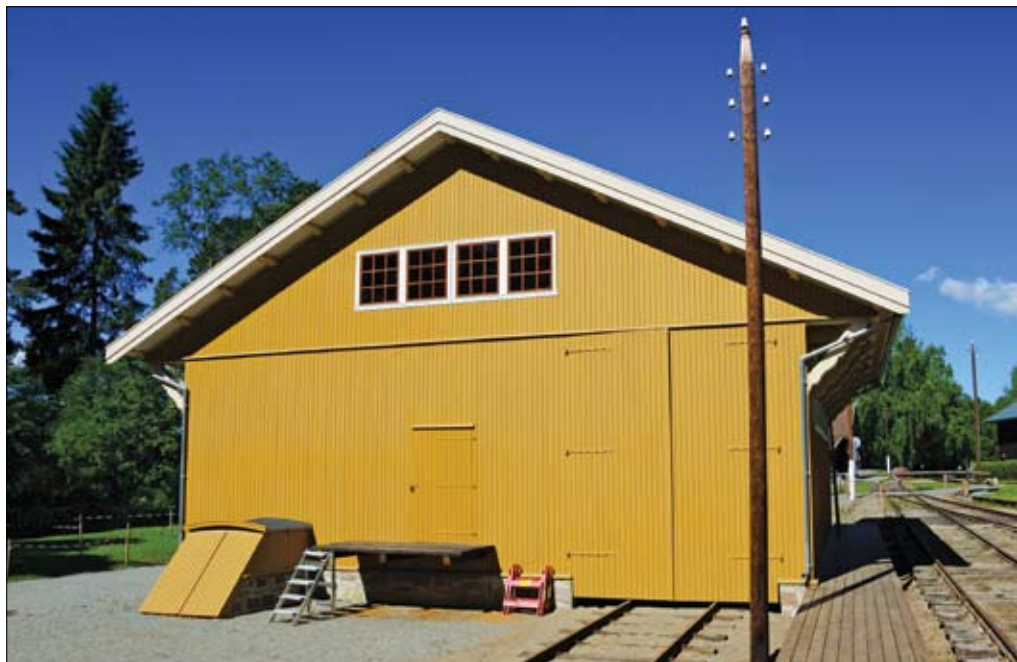
Jobben med å ferdigstille Kløften godshus fortsatte ut 2018. Bygget huser nå en egen utstilling. Foto: Kjetil Næss.
