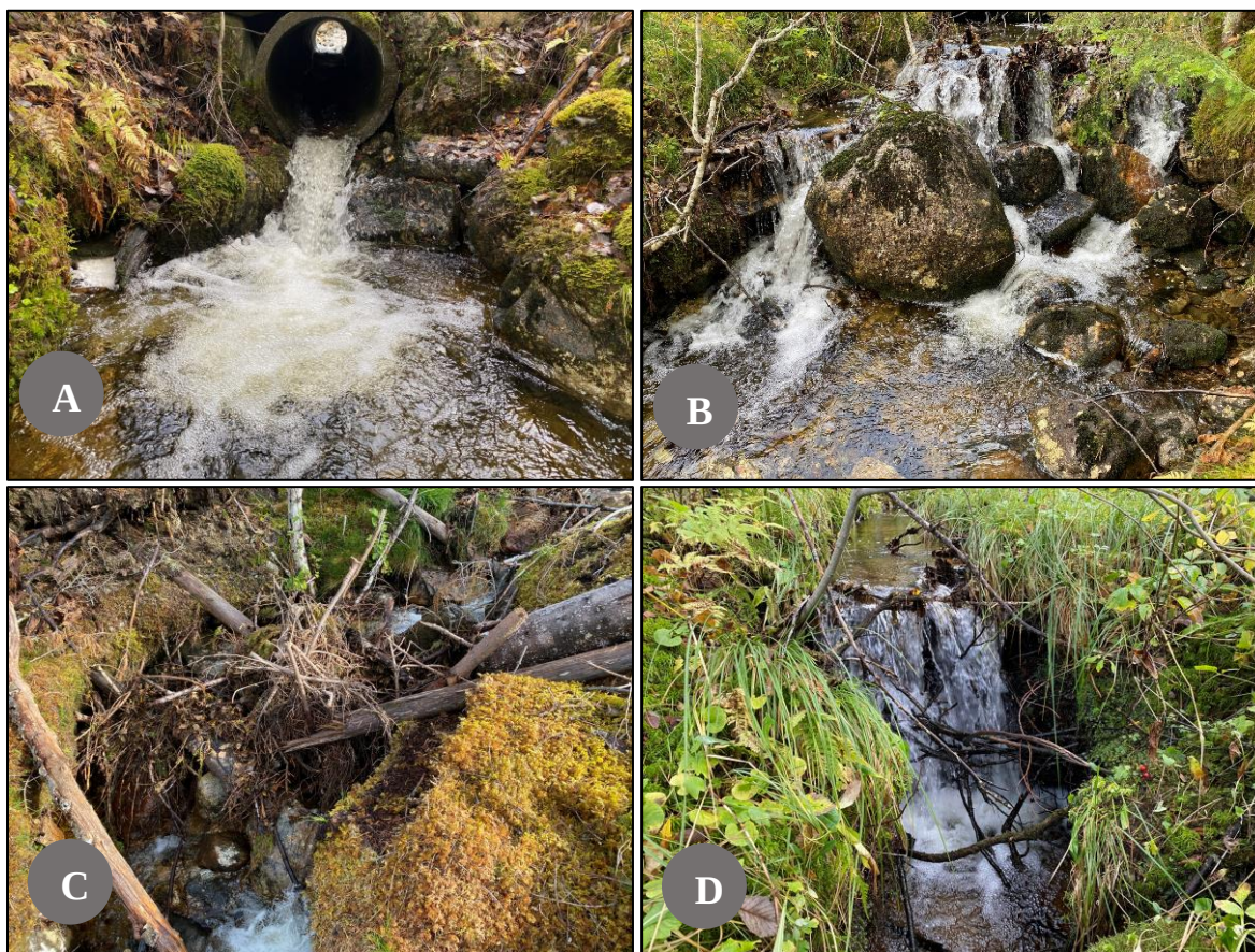
Figur 49. Vandringshindere i Nyløbekken. A) Rør under veien i segment A1 utgjør kunstig, absolutt vandringshinder grunnet helning og at røret er forhøyet. B) Naturlig absolutt vandringshinder øverst i Nyløbekken. C) Hogstrester har blokkert løpet i segment B6, og utgjør et kunstig temporært hinder. D) Naturlig temporært hinder i segment C1, like ovenfor der bekken renner under bakken.
