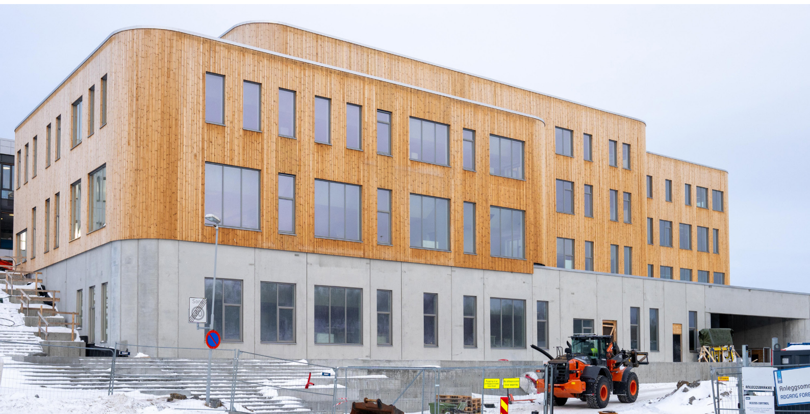
Byggearbeidene på det som er kalt "blått bygg" har fulgt planen i 2023. Bygget er nå døpt "Noatun" og vil bli tatt i bruk til studiestart i 2024. (Foto Adrian Svendsen Bensvik)
