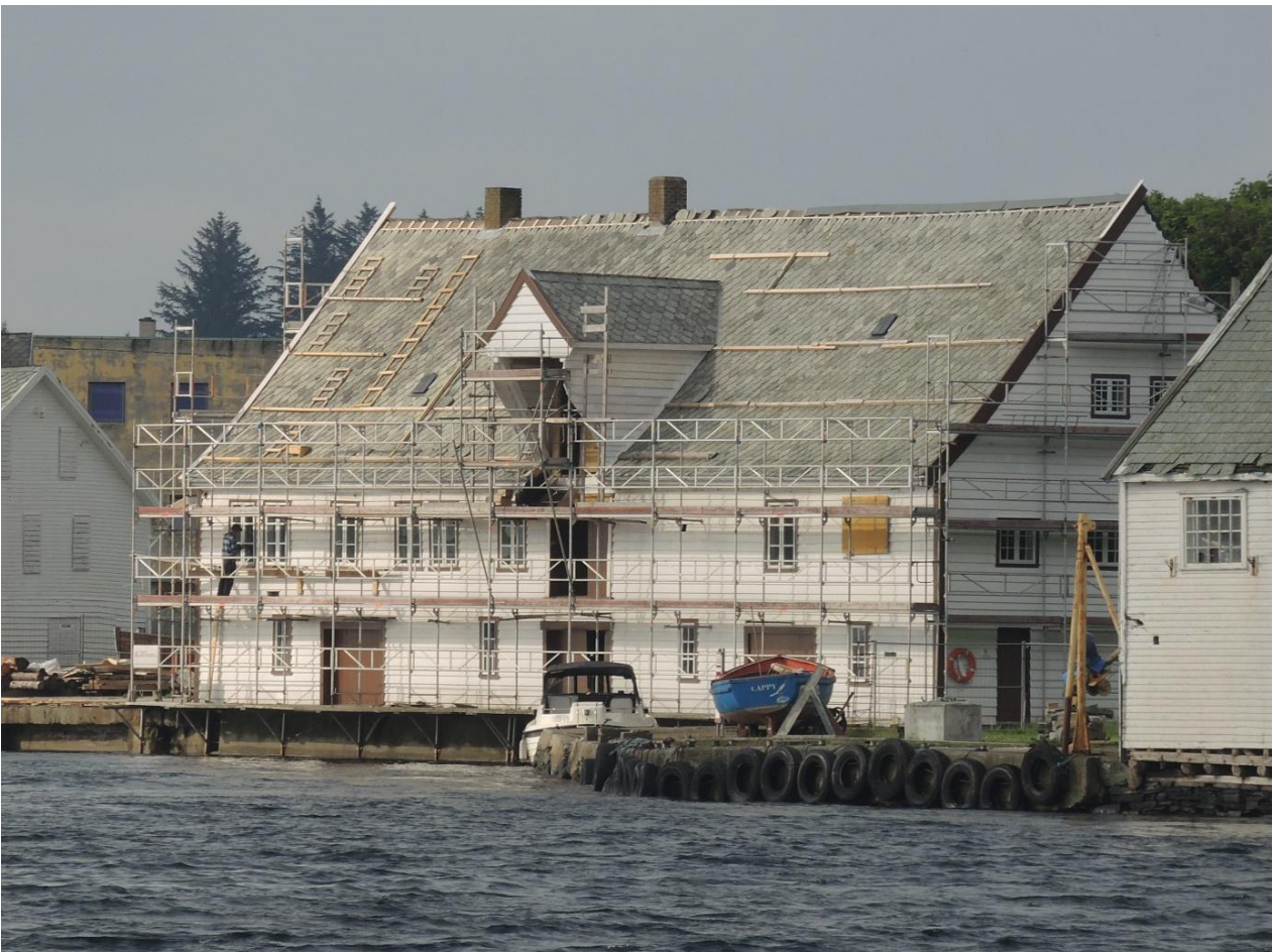
Bergesenhuset på Vibrandsøy. Under restaurering. Foto: Rogaland fylkeskommune
