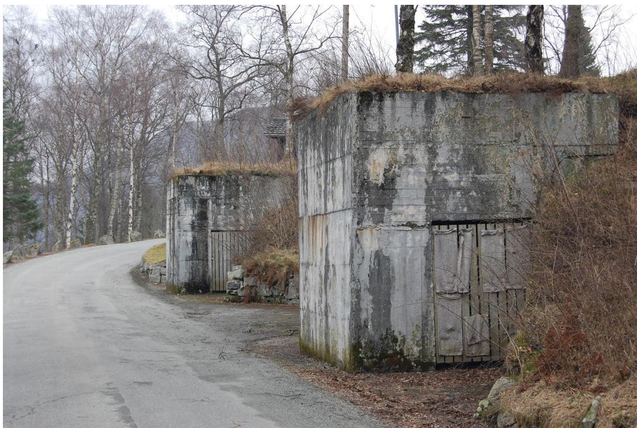
Vatneleiren. Dekningsrom i betong i kort avstand fra befalsforlegningene. Foto: Rogaland fylkeskommune
