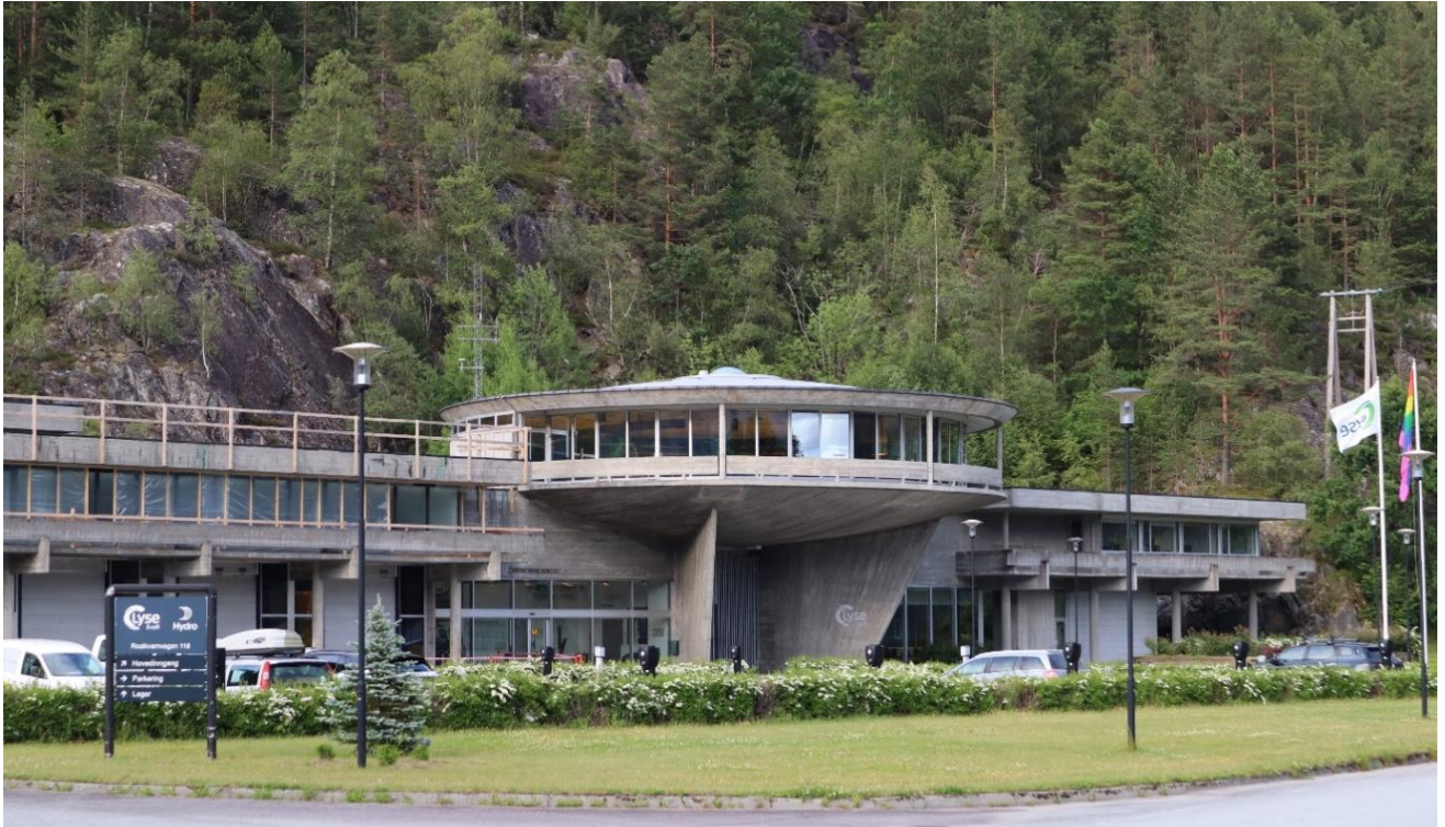
Kilen. Kontrollbygg for kraftverket. Foto: Rogaland fylkeskommune
