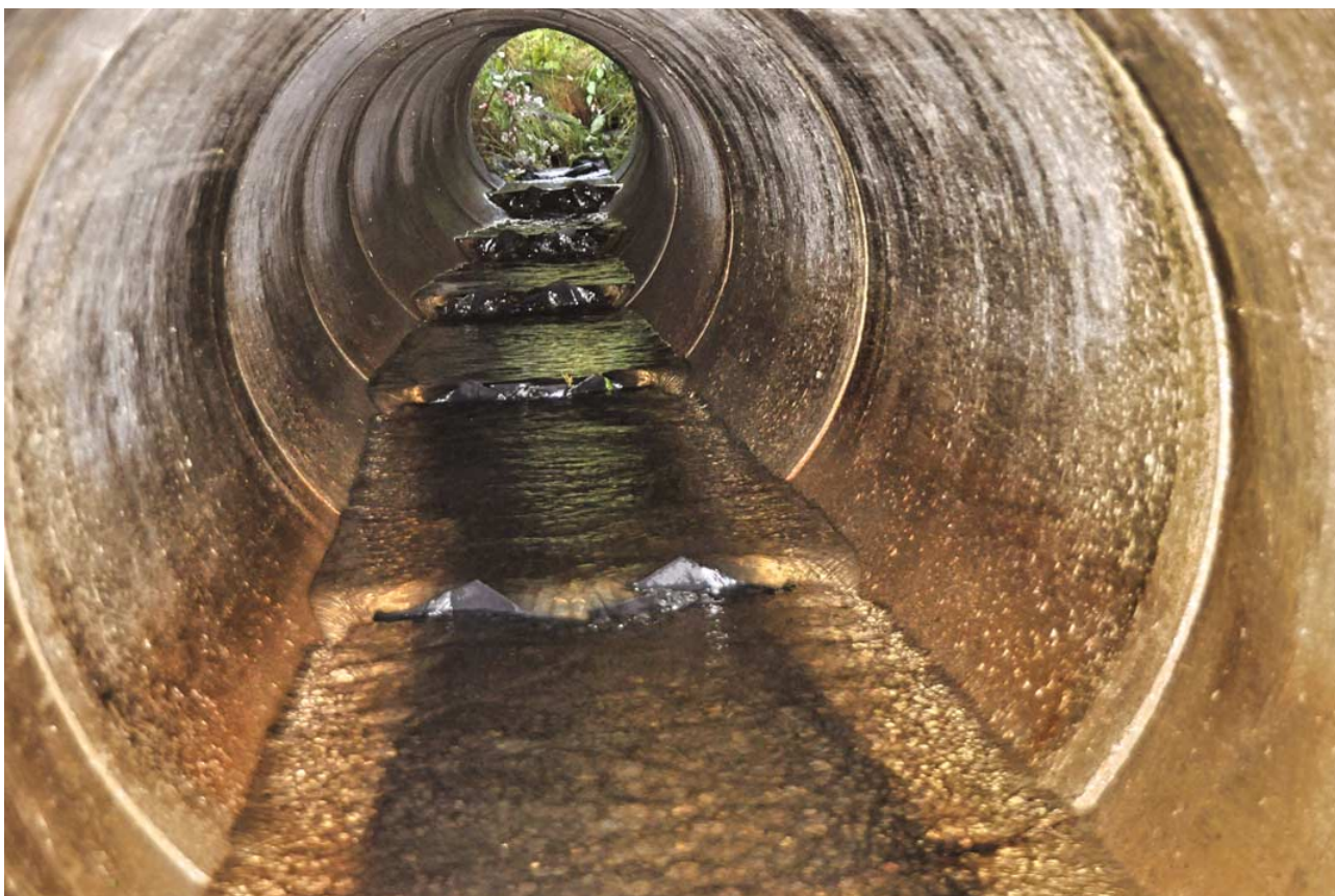
Fig. 155. Over: Ti løsterskler i et 30 m langt rør senker vannhastigheten og skaper kulper slik at fisken kan passere og få 2 nye km med bekk. Materialkostnader 13,000 kr. Tersklene distribueres av SWECO i Norge.
