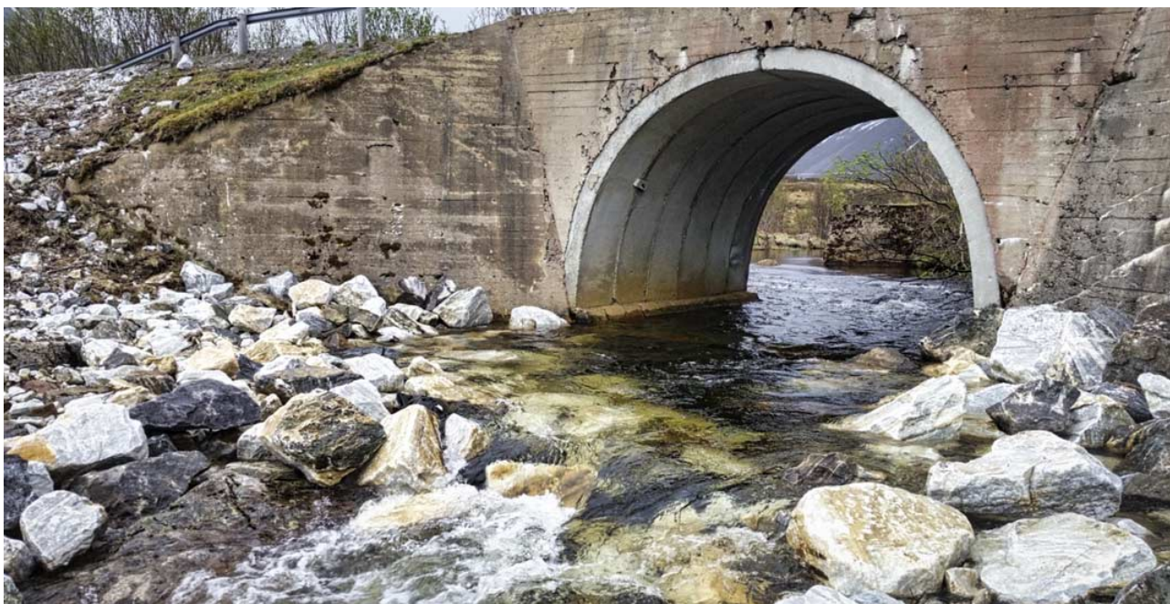
Fig. 32 Eksempel på passerbar terskel nedenfor veibro i Storelva ved Tromvik (med tillatelse fra Statens Veivesen, SVV rapport 459 «Frie fiskeveger»)
