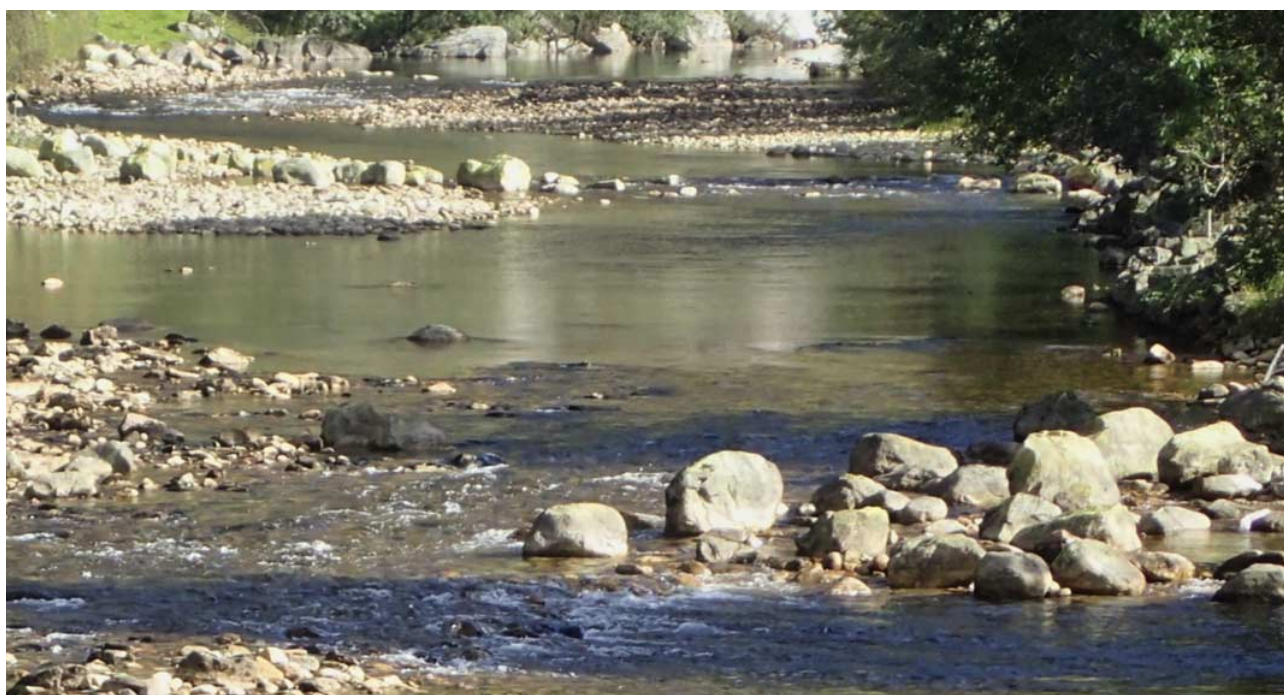
Fig. 35 Buneformete steinutlegg i Frafjordelva, som bidrar til dypål og variasjon i en tidligere homogen del av vassdraget (Stavanger jeger og fiskerforening med NORCE LFI).
