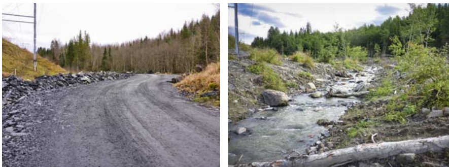
Fig. 126 Bildene er tatt på samme sted. Til venstre under anleggsarbeidet og til høyre like etter at arbeidet er ferdig. Trær og gress-tuer ble plantet opp på vekst-massene.
