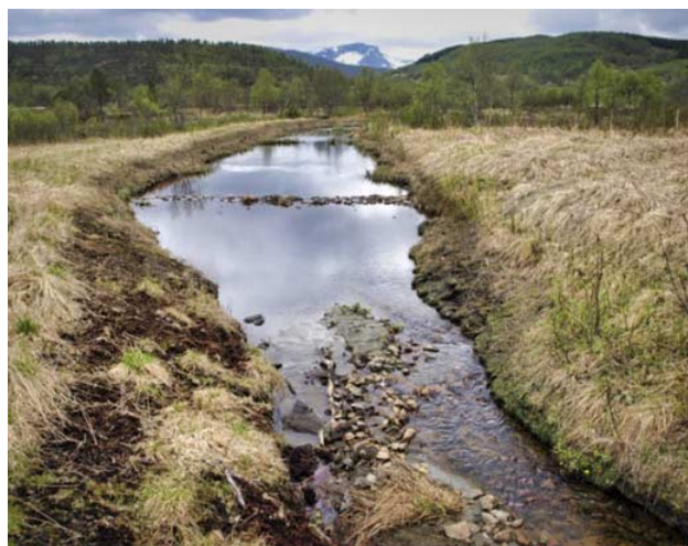
Fig. 121 Venstre bilde: Øvre dukområde med stasjon 2. Her er elvestrengen åpnet gjennom gjengrodde områder ved legging av fiberduk. Oppå duken er det lagt ut grus og stein for å bedre gyte- og oppvekstforholdene for ørret og skape nye leveområder for et mer variert bunndyrssamfunn (Foto Ballangen Energi AS). Høyre bilde: Nytt sedimenteringsbasseng (fangdam- og våtmarksfilter) nederst i Bruksåskanalen (Foto Fylkesmannen i Nordland).
