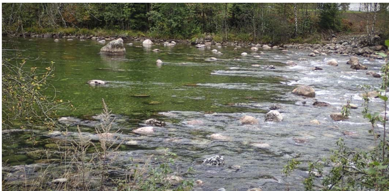
Fig. 29 Tidligere geometrisk terskelkant som ble fjernet. Nå finnes det et naturtypisk brekk med gyteplass på oversiden og stryk med dypål på nedsiden. Stabile steiner (egenvekt) er gravd ned i grunnen og lagt ut med høy variasjon og ruhet, samt med en lavvansrenne i midten. (2016, Tokkeåni, Statkraft med Uni Miljø LFI).
