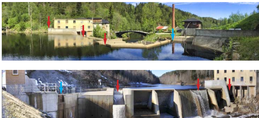
Fig. 110 Fosstveit kraftverk sett oppstrøms (over) og nedstrøms (ned) damkronen. Fluktåpningene som ikke fungerte er markert med rød pil, mens det velfungerende er markert med blå pil. Det brukes vannavskiller og rør for å lede fisken frem til elva igjen etter at den har vandret gjennom fluktåpningen (vises ikke på bilde).
