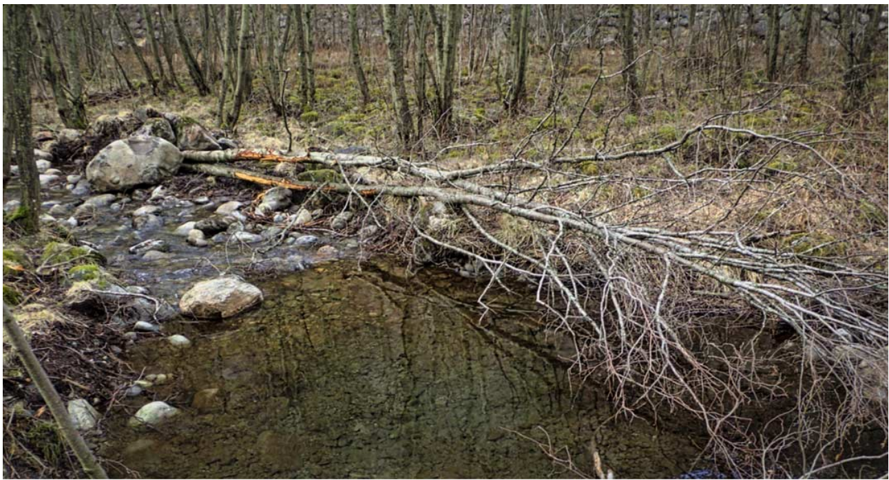
Døde trær som er festet med steinblokker i restaurert sideløp til Vassbygdelva i Aurland 2017. (E-Co energi med NORCE LFI)
