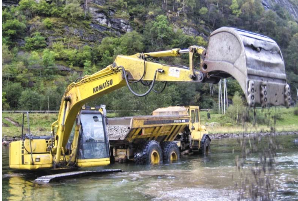
Grusutlegg med helikopter i Nidelva (Foto til venstre: Agder Energi), og med gravemaskin og dumper i Aurlandselva (Agder Energi, E-Co Energi og NORCE LFI).
