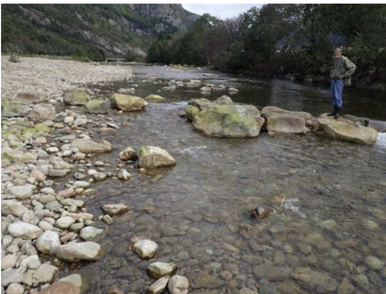
Fig. 57 Steingrupper av stor stein og blokker utlagt i Frafjordelva, og villaks som hviler i skjul av steinene
