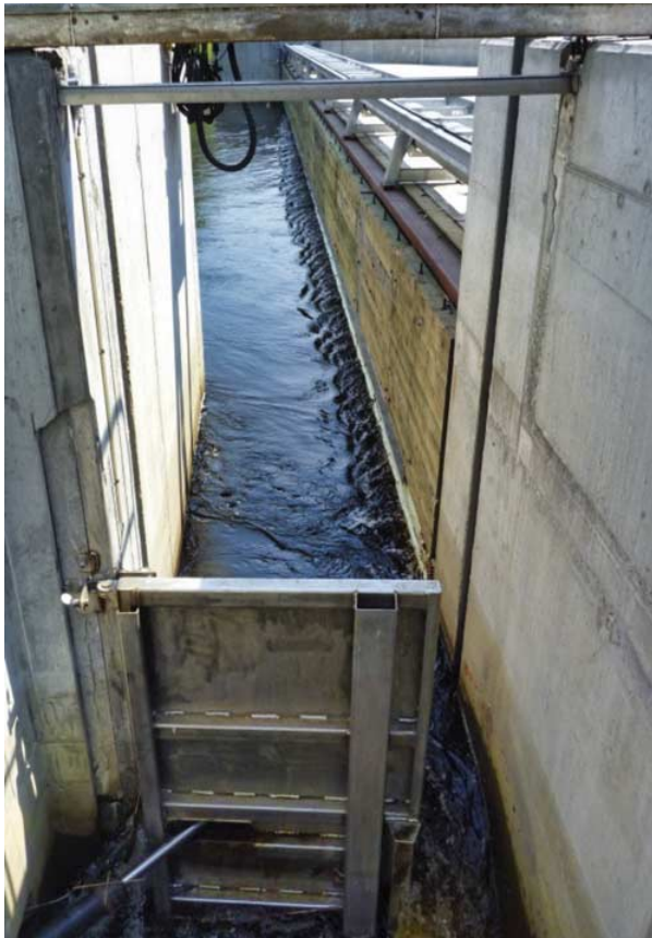
Fig. 146 Flutkåpning med spyleluke (venstre bilde, Foto: Olle Calles) og passasje-effektivitet [%] for ål, laks og havniøye (få individer) etter tiltaket.
