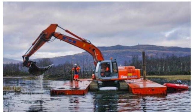
Fig. 119 Fjerning av vannvegetasjon og slam ved bruk av gravemaskin («Langemann») på flåte til venstre og på Forsvarets belastningsmatter til høyre for å unngå skader i våtmarksområder (foto NVE Region Nord).
