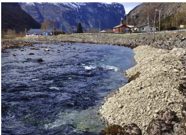
Fig. 62 100 m 3 grus og rullestein (32–200 mm) utlagt langs en erosjonssikret elvebredd i Aurlandselva (2016). Året etter (høyre bilde) var mesteparten av sedimentet erodert og fordelt nedstrøms utover elvebunnen, der det virker som gytesubstrat og ungfiskhabitat (E-Co Energi og NORCE LFI).
