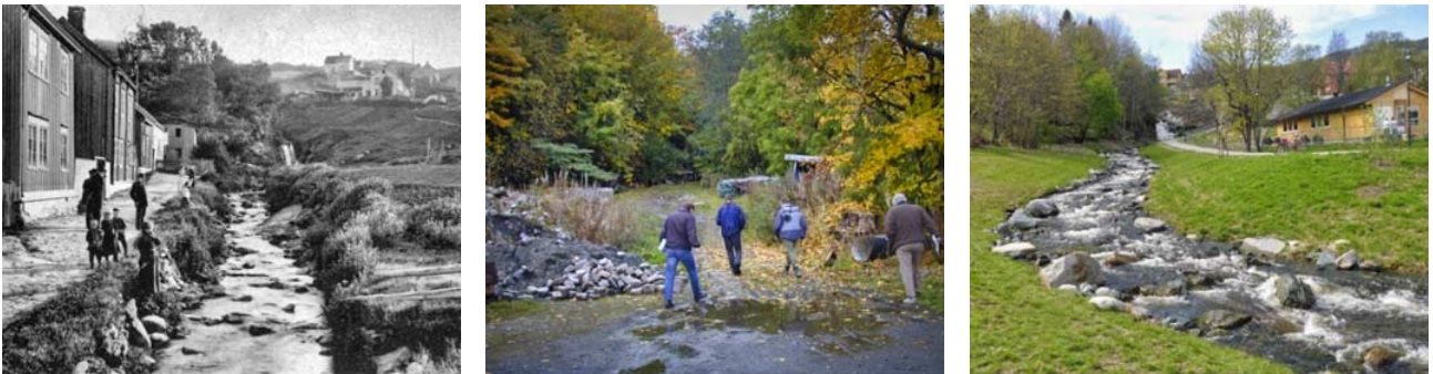
Fig. 114 Ilabekken parti fra nedre del: bildet til venstre viser åpen bekk i 1896, bildet i midten fra 2003 illustrerer at bekken har vært lukket i mange tiår, bildet til høyre viser gjenåpnet bekk i 2008. Foto: Trondheim kommune.
