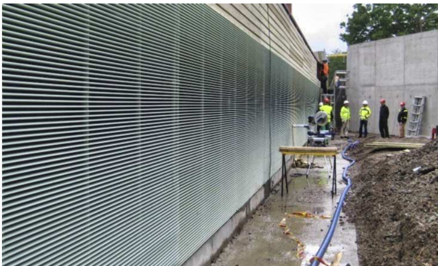
Fig. 47 \beta -varegrind med fluktåpning (bakgrunn) foran vanninntak ved kraftverk Herting. Varegrinden har horisontale spiler med 15 mm spaltevidde, automatisk ristrenskning og vertikal fluktåpning som også brukes som spyleluke (Foto: Olle Calles).
