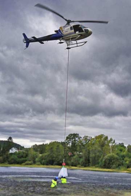
Grusutlegg med helikopter i Nidelva (Foto til venstre: Agder Energi), og med gravemaskin og dumper i Aurlandselva (Agder Energi, E-Co Energi og NORCE LFI).
