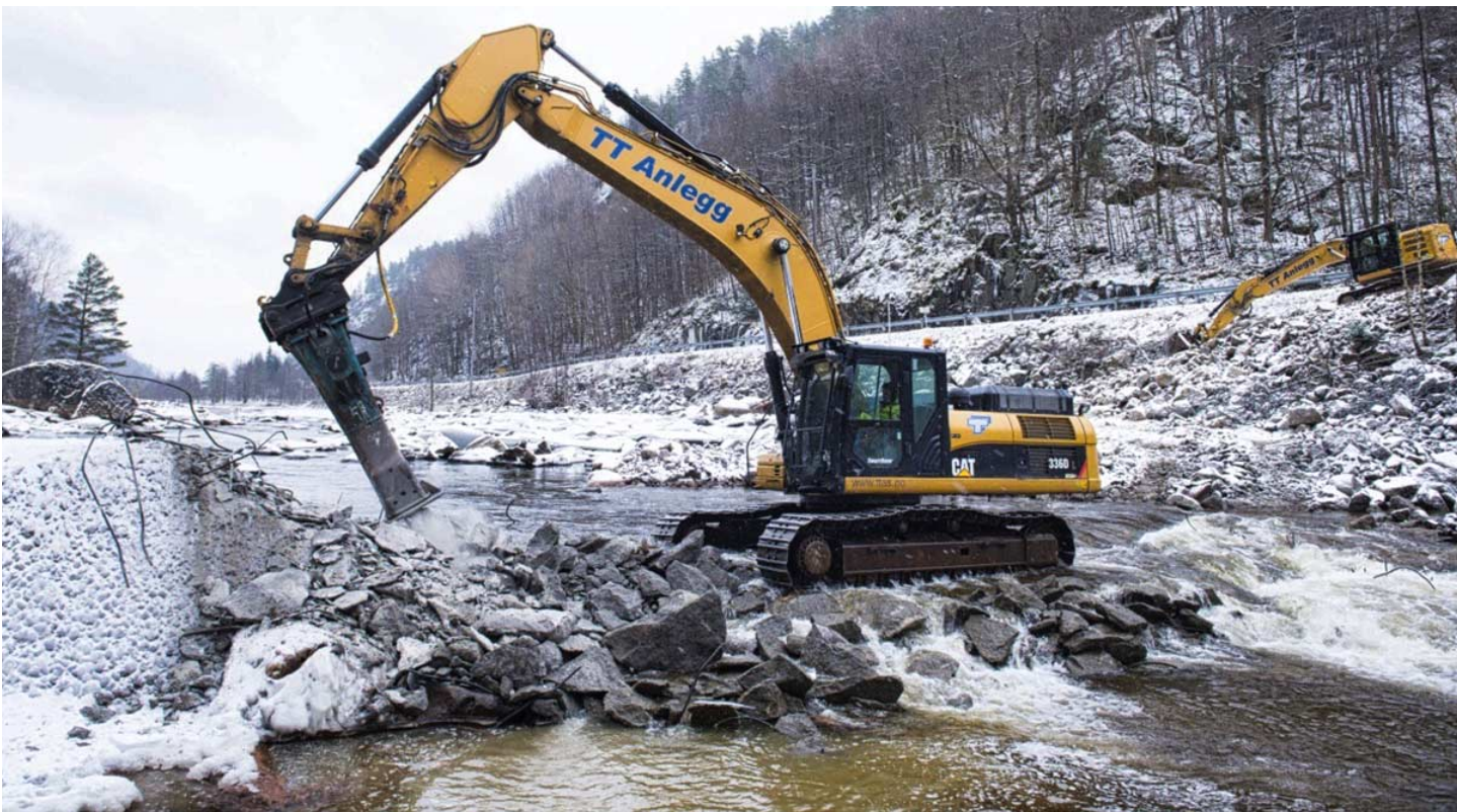
Fig. 15 Fjerning av terskler i Mandalselva 2016. Miljødesign-prosjektet er blant Norges mest omfattende og gjennomføres av Agder Energi sammen med Nina, Sintef, NORCE LFI m.fl. Foto: Agder Energi.
