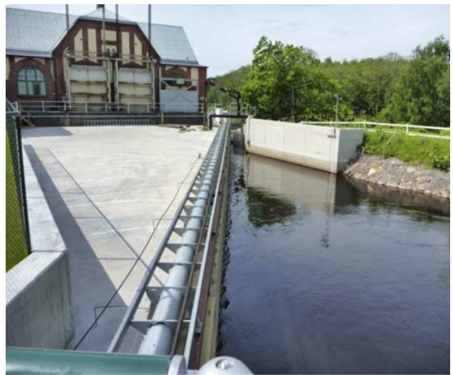
Fig. 145 \beta -varegrind med fluktåpning (bakgrunn) uten og med vann. Varegrinden har horisontale spiler med 15 mm spaltevidde, automatisk ristrenskning og vertikal fluktåpning som også brukes som spyleluke (Foto: Olle Calles).
