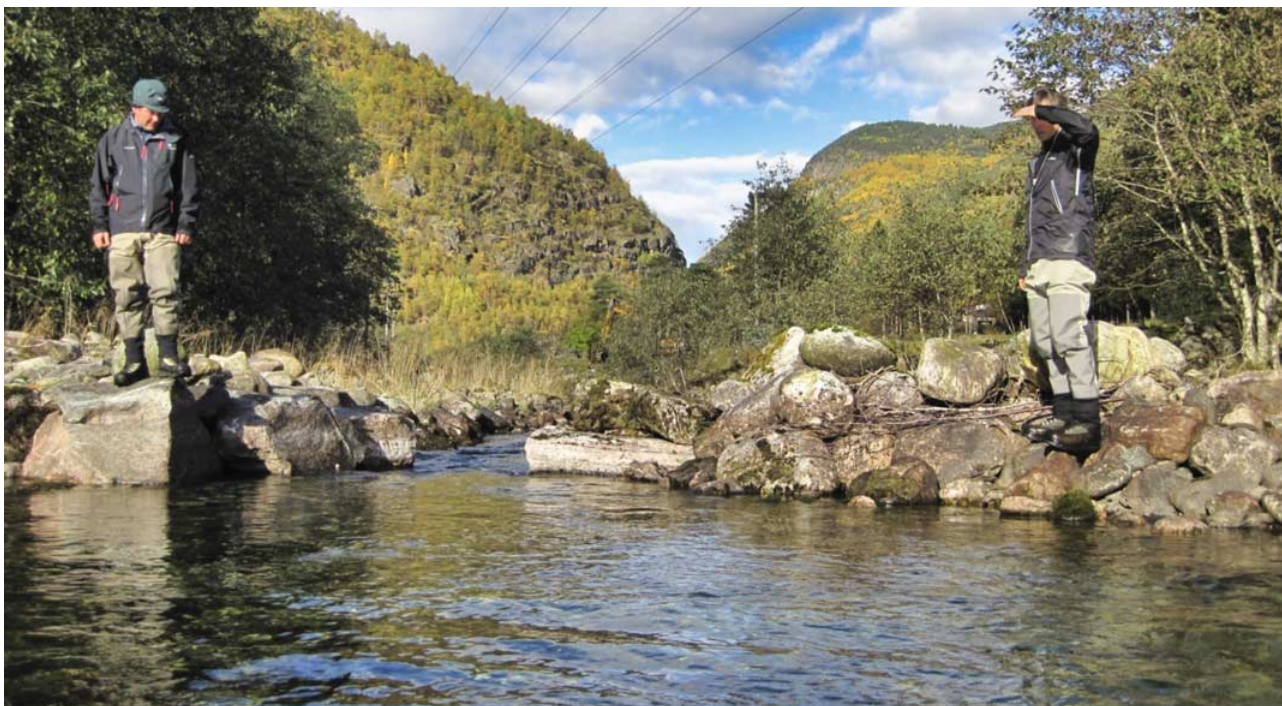
Fig. 20 Åpen grøft som leder vann i sideløpet ved klekkeribekken i Aurland. Vannføringen dimensjoneres av tverrsnittet i innløpet. Hele inntaket er tilgjengelig og enkelt å vedlikeholde, samt at det er passerbart for fisk og gir habitatareal. En slik utforming gir lignende vannføringsdynamikk i sideløpet som i hovedløpet.
