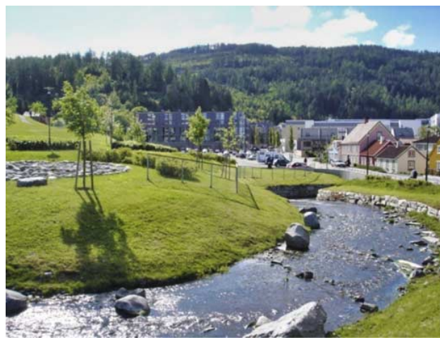
Fig. 113 Ilabekken etter gjenåpning med etablering av fisketerskler og gyteområder for sjørret.
