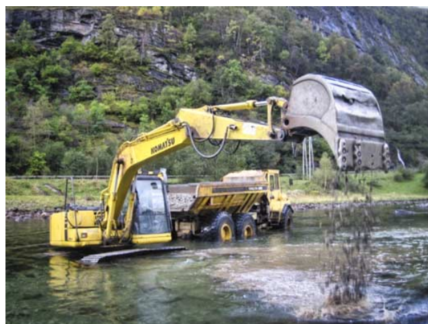
Fig. 136 Ripping (venstre) og utlegging av gytegrus (høyre)
