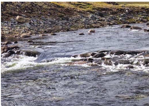
Fig. 28 Detaljer fra lavvannsrennen i Djupa. Den er utformet som trinn-kulp -type med spalteformete overløp, til venstre ca. ved medianvannføring, til høyre ved lavvannføring om vinteren. Vandringsmuligheter for fisk finnes ved alle vannføringer.
