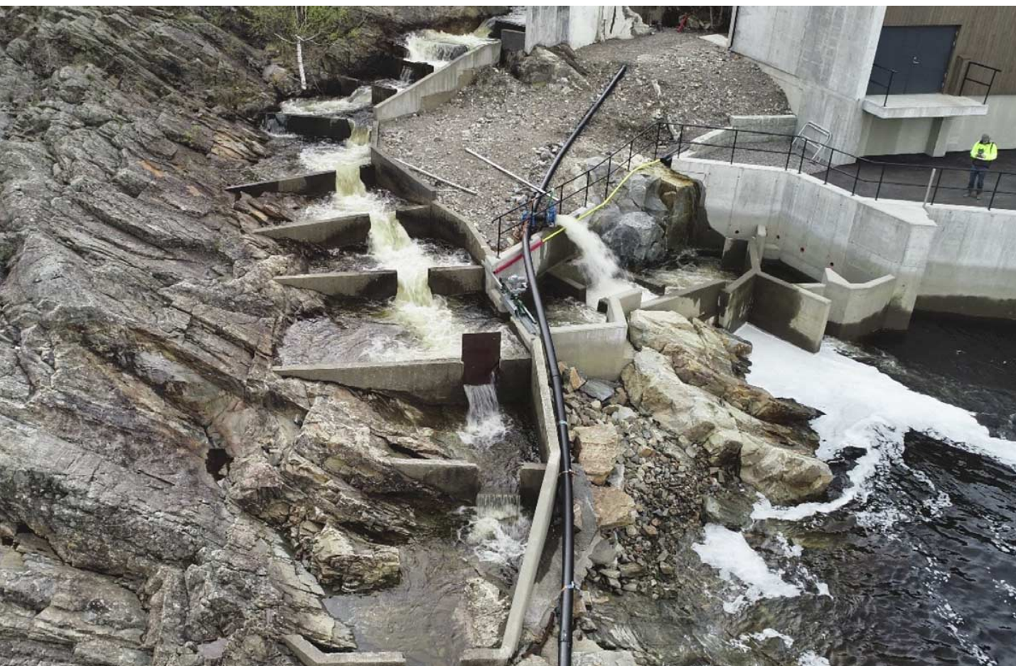
Fig. 42 Kulpetrapp ved Boenfoss kraftstasjon med to innganger : Inngang 1 brukes når vannføring går i hovedsak over fossen. Inngang 2 går via en spaltetrapp når vannføring domineres fra kraftverk. Regulant: Boen Foss AS, prosjekterende: Norconsult. (Foto: Lars Bendixby)
