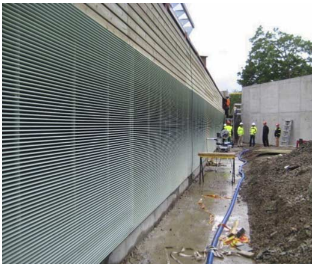
Fig. 145 \beta -varegrind med fluktåpning (bakgrunn) uten og med vann. Varegrinden har horisontale spiler med 15 mm spaltevidde, automatisk ristrenskning og vertikal fluktåpning som også brukes som spyleluke (Foto: Olle Calles).
