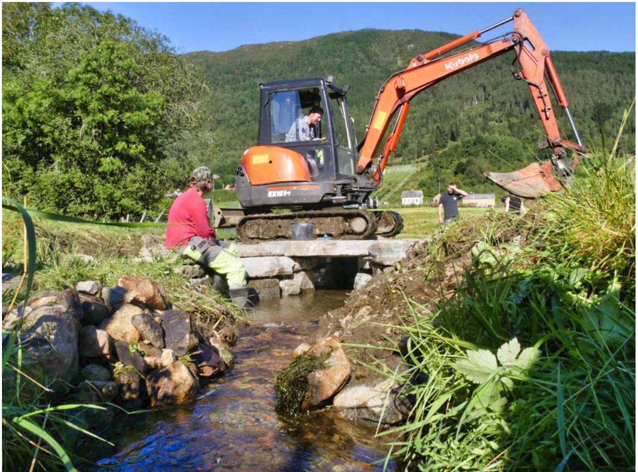
Ulvik Sportsfiskarlag har fjernet rørkulvert og bygget tradisjonell bro av steinheller med gjennomgående naturlig bunnsstrat. Fisk kan vandre fritt igjen. (Foto: Hardangerfjord Villfisklag)
