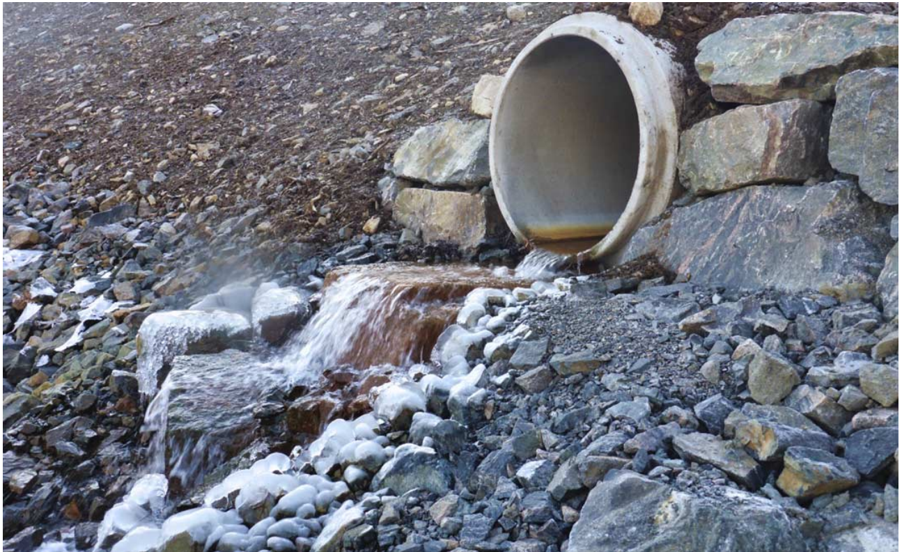
Fig. 8 Stadig nye inngrep: Ny vandringsbarriere ved veikulvert bygget i 2016 ved munning av anadrom sjørretbekk ved Arefjordpollen, Vestland.
