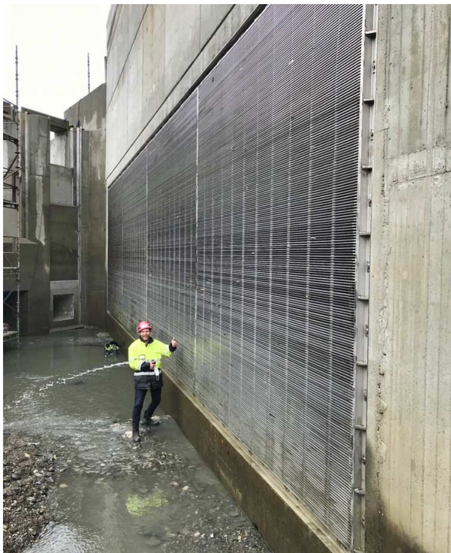
Fig. 45 Vannkraftverk Palmafossen i Raundalselva (Voss) med beta-varegrind foran inntak, fluktåpning med bunn- og overflateinntak.
