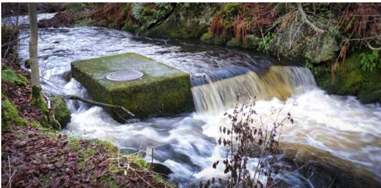
Fig. 37 Eksempel på et lite omløp ved terskel med vanninntak i Apeltunelva i Bergen. Sideløpet til venstre for vanninntaket ble åpnet og sikret med stein. Fisk kan nå vandre fritt ved de fleste vannføringer. Tidligere kunne fisk bare passere ved større flommer (vannførings-avhengig vandringshinder). Sideløpet ble lagt slik at vanninntaket fortsatt fungerer etter hensikten (bidrag til sirkulering av brakkvannspoll). Kostnader 4 timer dugnad (Bergen Sportsfiskere).
