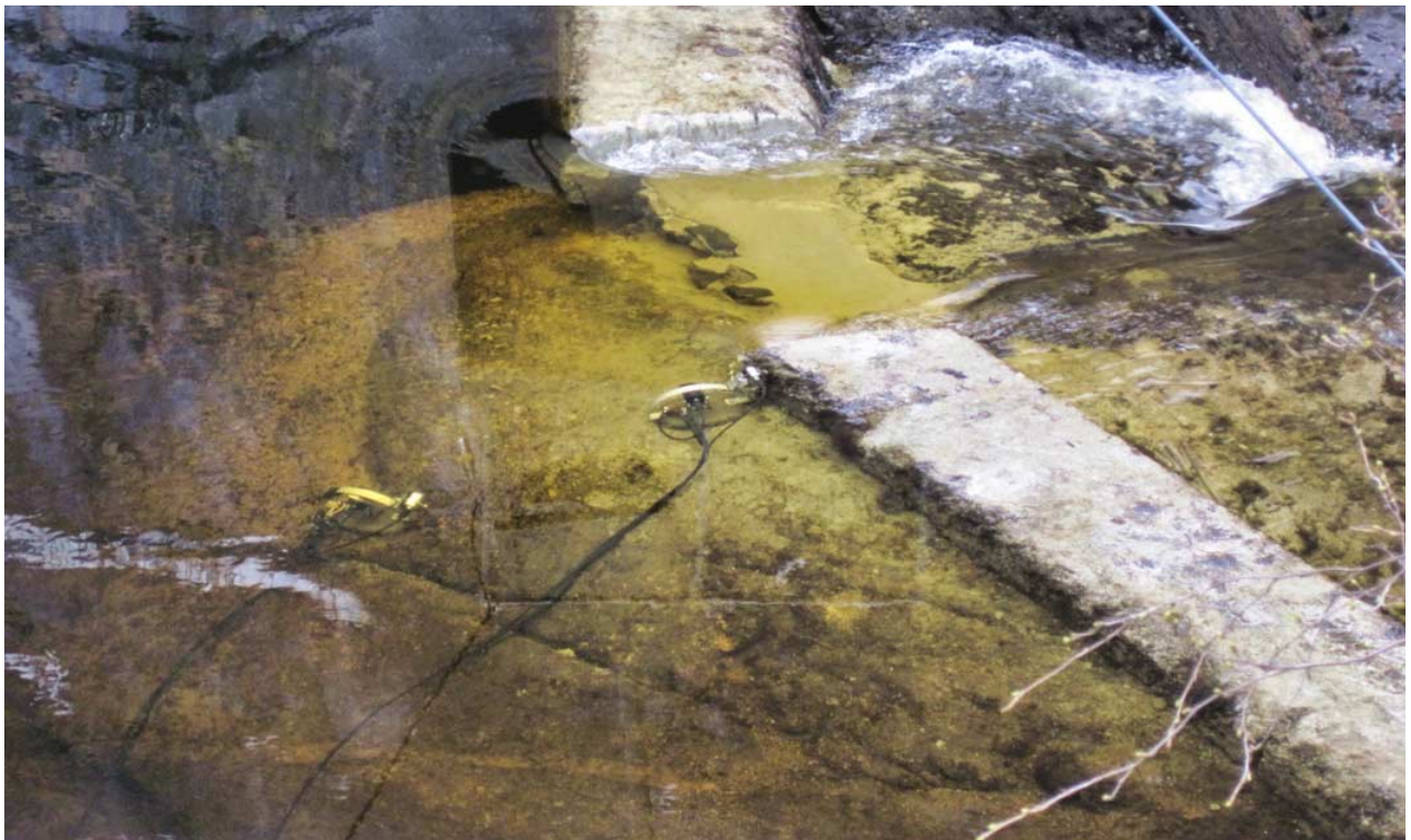
Fluktåpninger er et viktig hjelpemiddel for å få nedvandrende fisk trygt forbi demninger og kraftverk. Her fra demning Tveitofoss kraftverk i Bjoreio, Hordaland.
