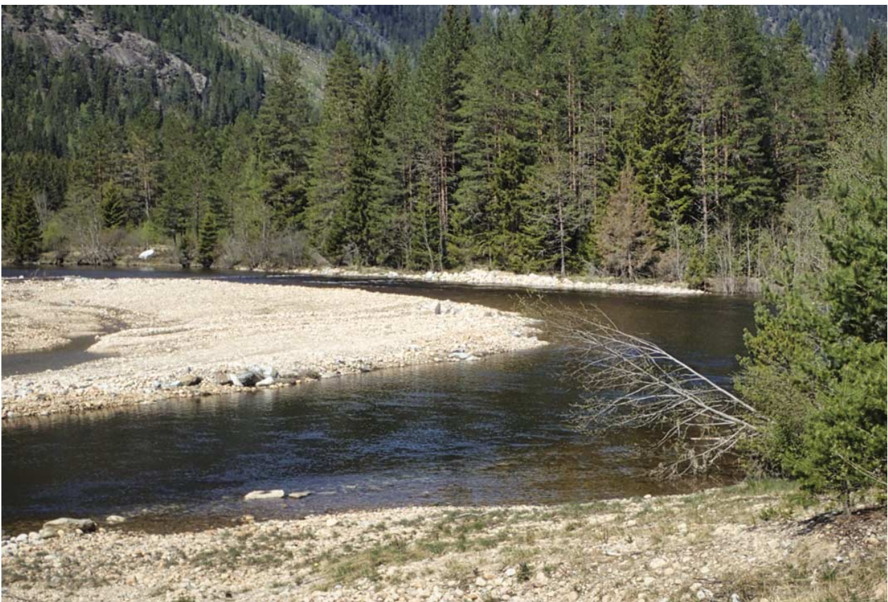
Fig. 36 Omløp kan ha større omfang, f.eks. som her «Blekeløpet» i Otra. Det er 460 m langt, utformet som naturtypisk elveløp av kulp-stryk-type, har dynamisk substrat i erosjonssikre rammer, og 7–24 m bredde. Qdimensjonerende er 3–15 m 3 /s, gradient er 0,002–0,008 (Statens Vegvesen, Agder Energi, NORCE LFI, 2012). Kostnader var 2,5 MNOK.
