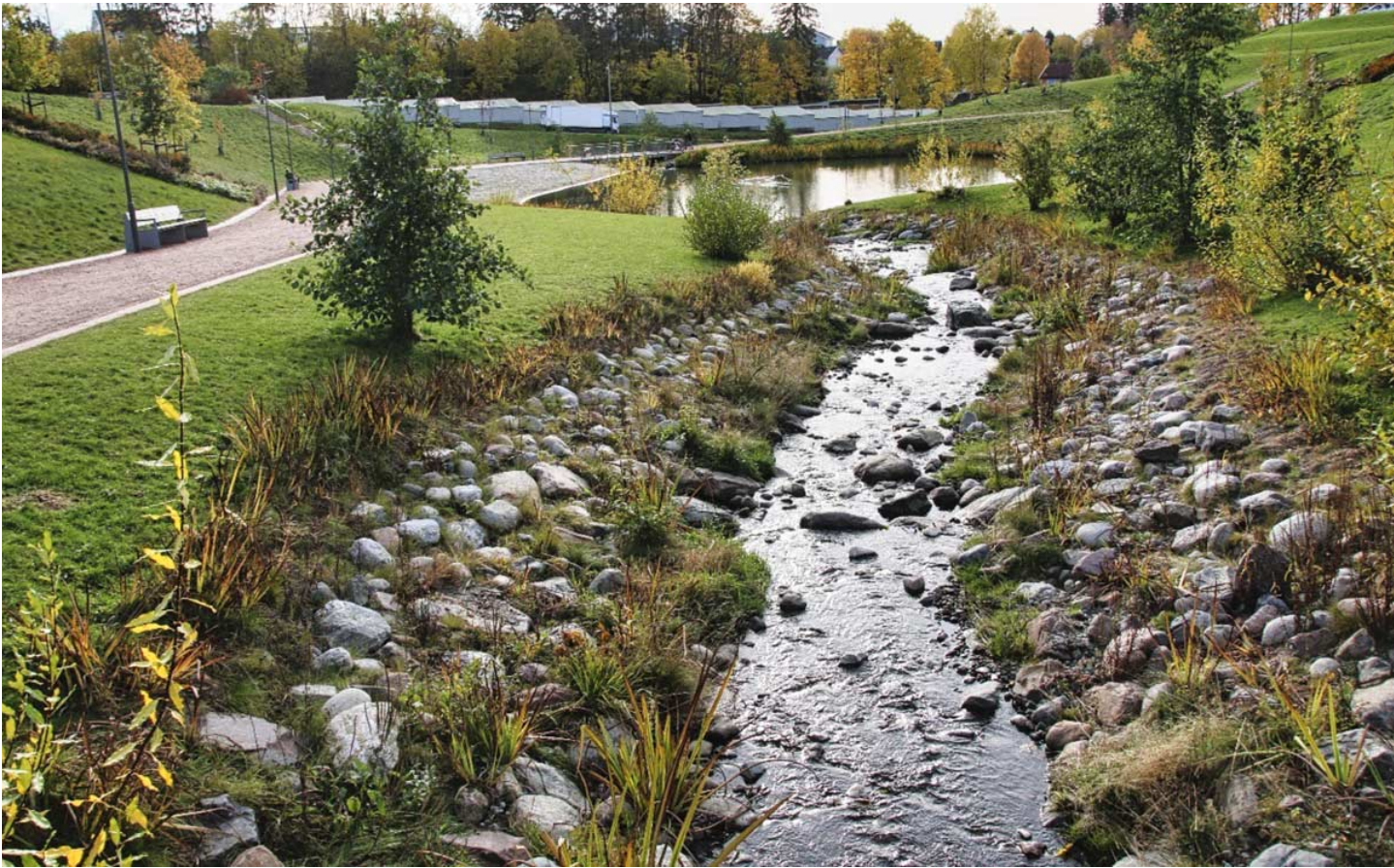
Fig. 14 Bjerkedalen park ble åpnet i oktober 2013. Hovinbekken er gjenåpnet gjennom parken over en strekning på 350 meter. Det er lagt til rette for vandring og opphold for ørret som naturlig hører til i vassdraget. Prosjektet har vunnet Oslo Bys Arkitekturpris i 2015 og pris for Norges beste uterom i 2016. Foto: VAV Etat Oslo.
