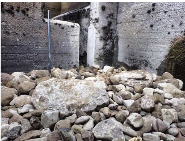
Bilder fra ombygging av kulpetrappen på Høyegga i Glomma til en spaltetrapp i rammen av SafePass-prosjektet (CEDREN, med GLB, Eidsiva Energi, NINA, SINTEF og NORCE LFI).
