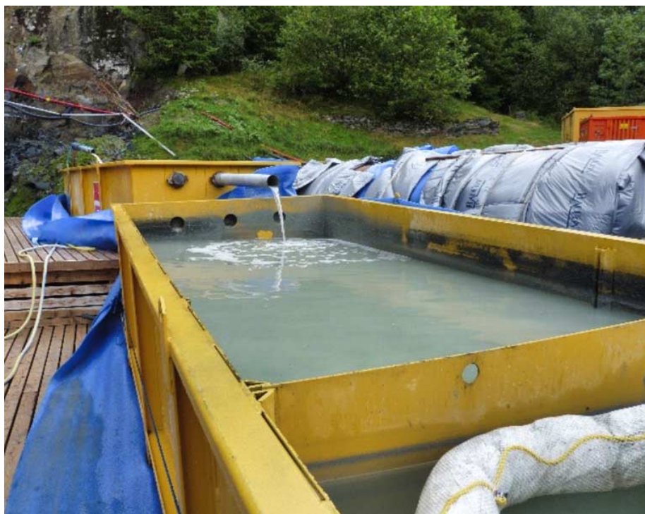
Fig. 64 Tiltak mot finsedimentutslipp fra anleggsområder: Venstre bilde viser en voll ved Apeltunelven som dannet et stort avsetningsbasseng for overvann fra et anleggsområde. Vann fra tunneldriving ble ledet direkte til kommunalt avløpsnett, slik at denne urbane sjørretelven kunne skjermes mot forurensning. Høyre bilde viser et mobilt renseanlegg for tunelldrivingsvann i bruk for Statens Veivesen ved Granvinsvassdraget.
