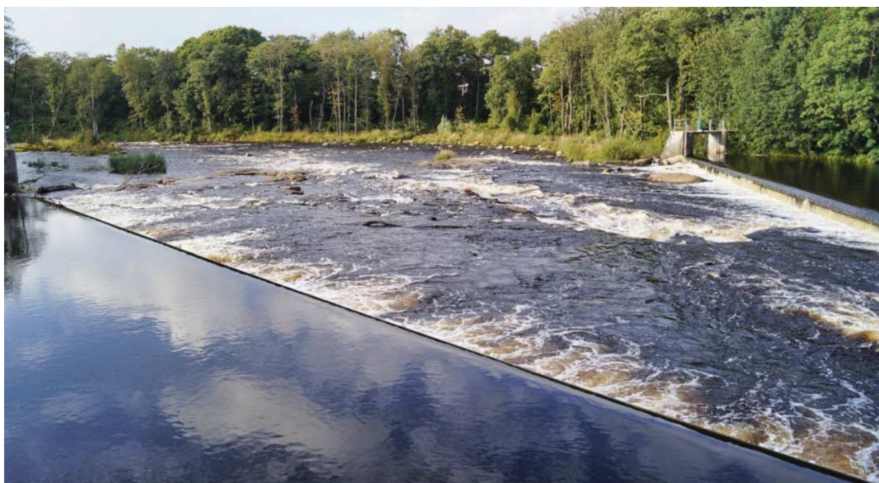
Fig. 144 Øvre del av det naturtypiske omløpet med V-formet demning (Foto: Olle Calles).
