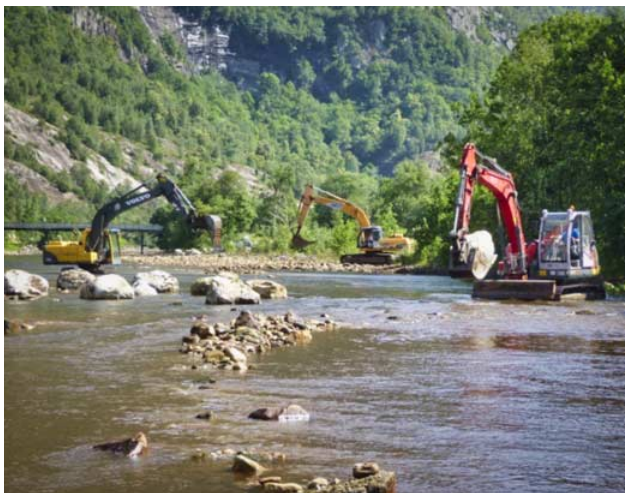
Fig. 83 Bygging av buner satt opp av enkeltstein i nedre deler av elven i 2013
