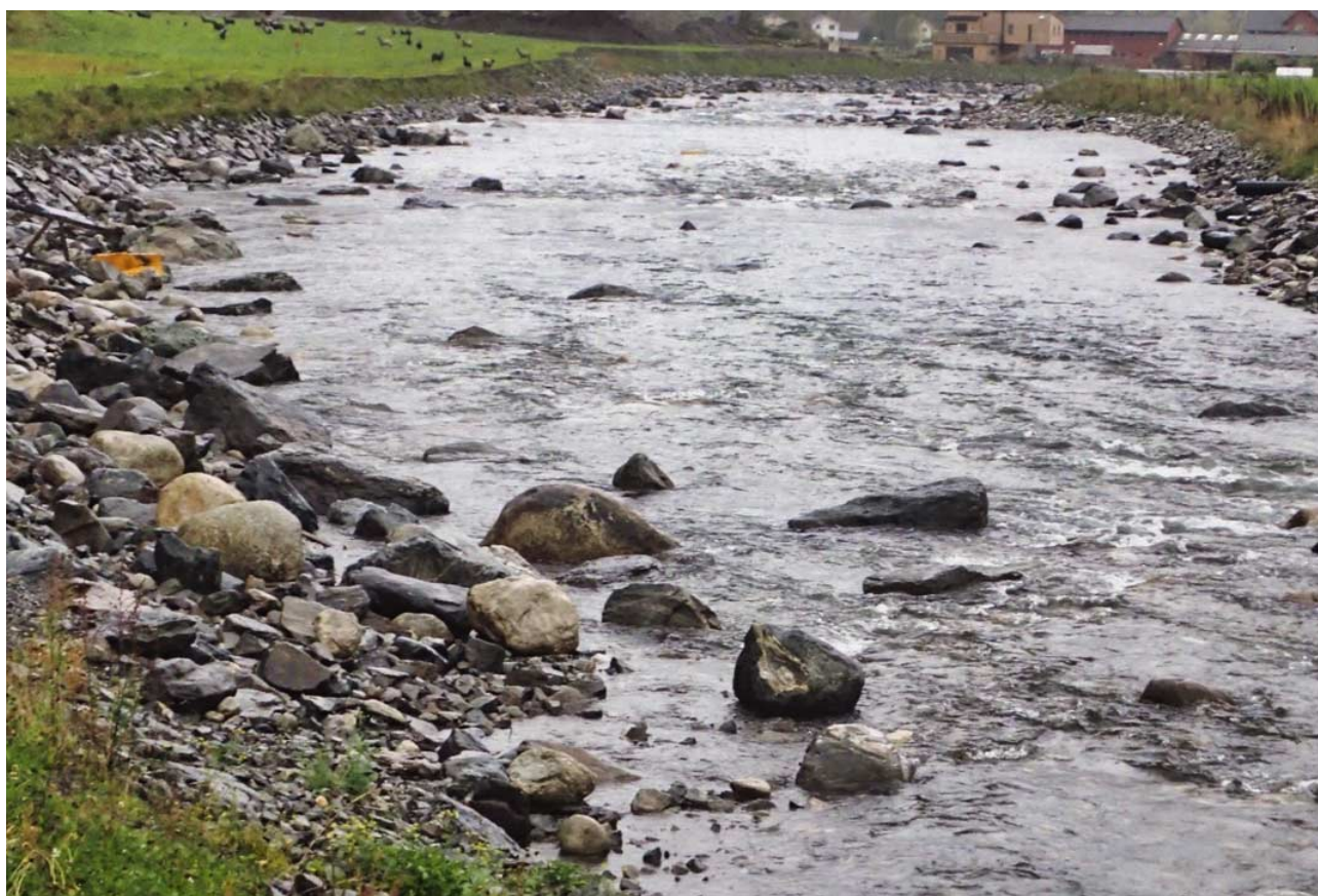
Tradisjonell erosjonikring med glatt plastring (øvre bilde) og tilbaketrukket erosjonssikring med mer naturtypiske elvebredder (nedre bilde Flåm 2017, NVE med NORCE LFI).
