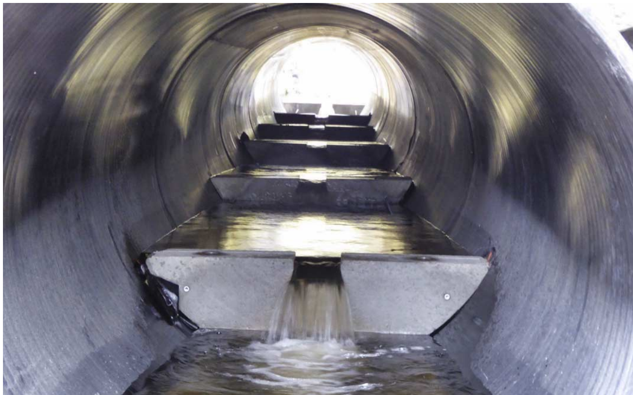
Fig. 31 Støpte terskler i en veikulvert. Vandringsforholdene kan bedres ytterligere med spalteformete utsparinger i tersklene. Bredde i utsparing bør ligge mellom 20 og 60 cm, avhengig av arter og forventet vannføring. Foto: Anton Rikstad
