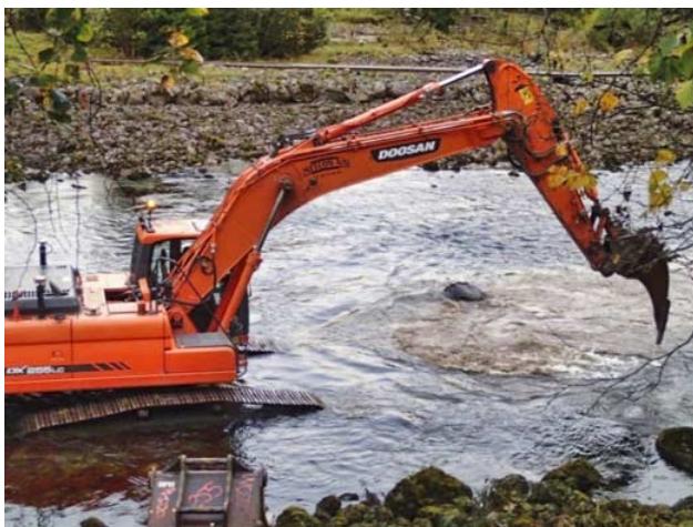
Fig. 60 Harving med ripper.
