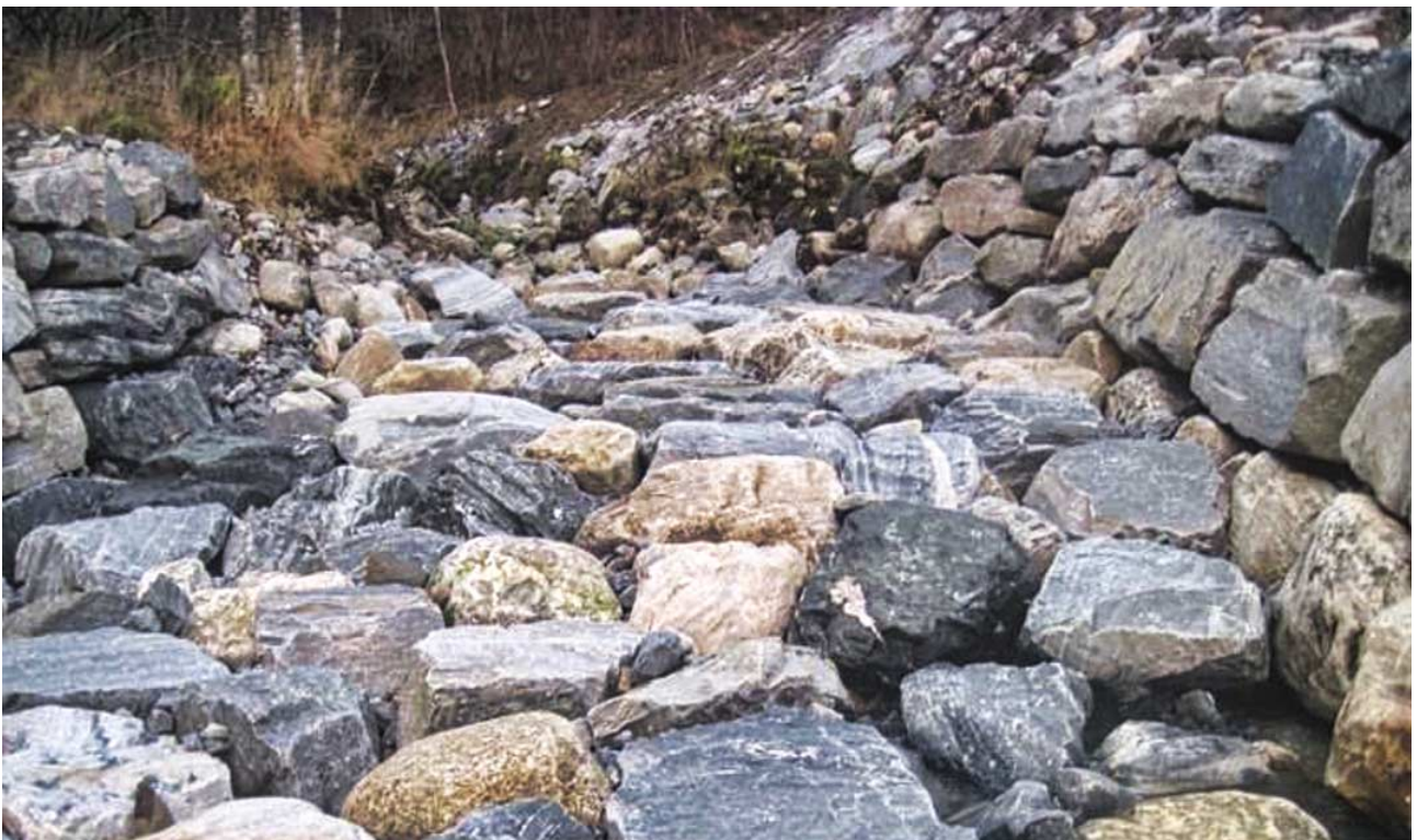
Fig. 11 Kanalisering og erosjonssikring ved plastring av både elvekanter og elvebunn kan fjerne fiskehabitat fullstendig. Det kan dessuten redusere vandringsmuligheter for fisk, som vist på dette bildet fra en anadrom bekk ved Nordrevik, Høyanger kommune i Vestland. Vannet sildrer gjennom plastringen. Bekken ble erosjonssikret og kanalisert i 2012. Lignende miljøreduserende tiltak er fortsatt utbredt i Norge. Sammenlign med alternativ utforming på side 113, Fig. 66.
