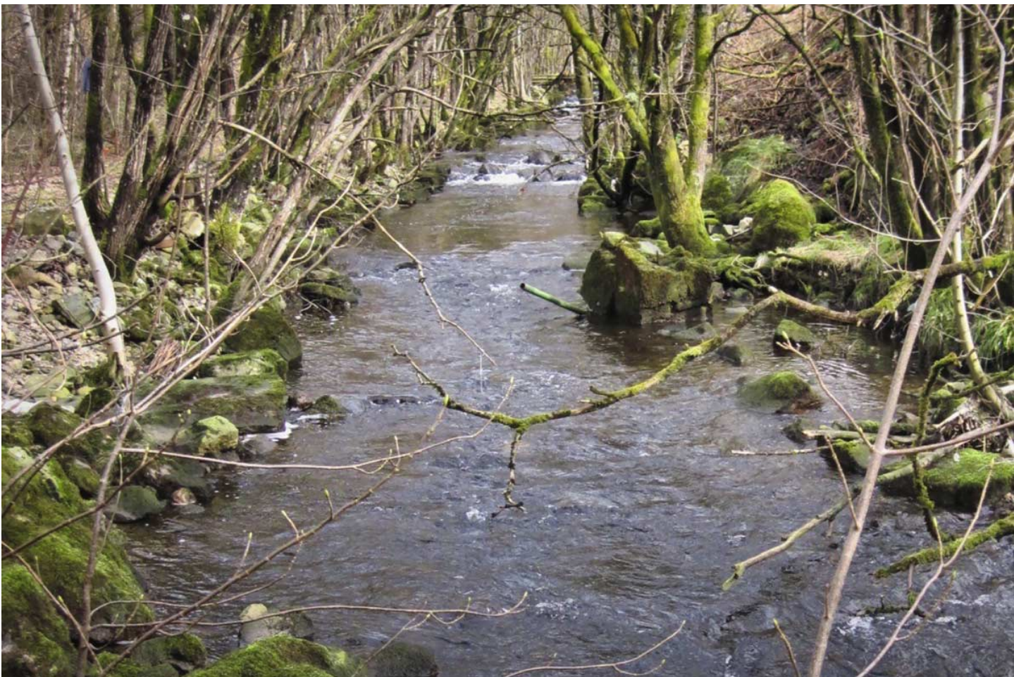
Fig. 71 Denne erosjonssikringen med uregelmessig steinutlegg («steinrøys») og trær i Sælenelven har tålt mange tiår med flommer, og har gitt bedre miljøforhold enn glatt plastring eller mur. Sedimentdynamikken er redusert, men det finnes fortsatt skjul, hulrom, røtter og trær langs elvekantene.
