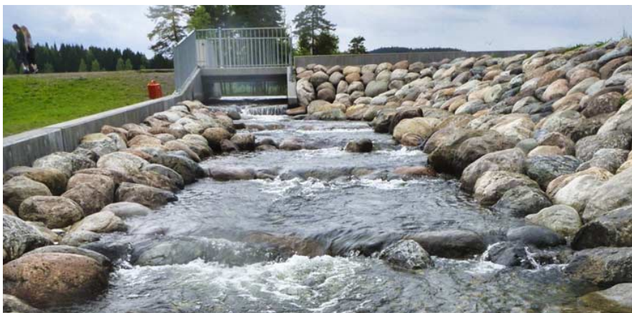
Fig. 32 Eksempel på passerbar terskel nedenfor veibro i Storelva ved Tromvik (med tillatelse fra Statens Veivesen, SVV rapport 459 «Frie fiskeveger»)
