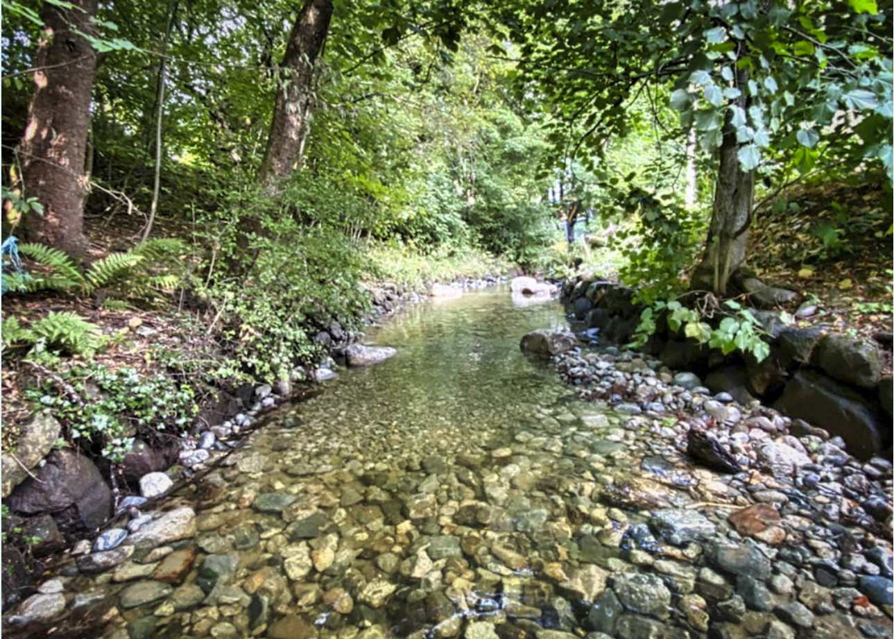
Fra tiltak i Bruelandsparken, Storåna i Sandnes, september 2021. Prosjektet gjennomført i samarbeid med Sandnes Kommune, Ecofact og Sjøørretprosjektet Rogaland. Gjennomførte tiltak er etablering av struktur med kulper, brekk totalt 12 terskler/buner og lavvannsrenne. Det er lagt ut habitatstein og gytegrus samt steingrupper. Det ble fjernet store mengder sand. Til slutt er vann ledet inn i sideløpet som er 170 m langt og > 800 m 2 nytt habitat er etablert. (Foto: Knut Ståle Eriksen)
