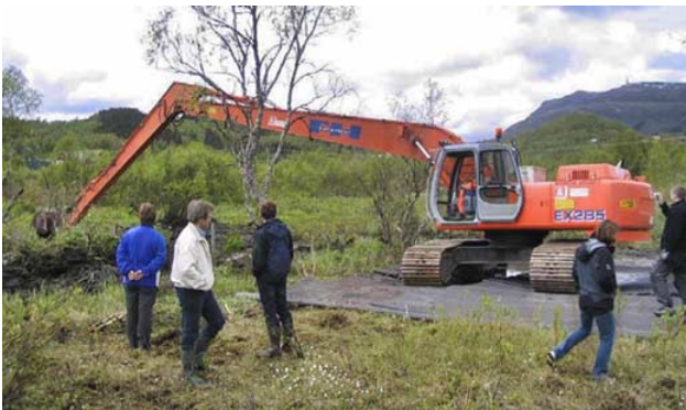
Fig. 119 Fjerning av vannvegetasjon og slam ved bruk av gravemaskin («Langemann») på flåte til venstre og på Forsvarets belastningsmatter til høyre for å unngå skader i våtmarksområder (foto NVE Region Nord).
