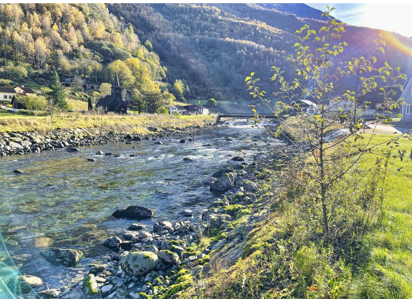
Bunnstabilisering som reduserer erosjonsrisiko langs elvebreddene ovenfor. Tiltaket er utformet som et naturlig brekk bygget opp av enkelte steinblokker. Det virker moderat oppstuende ved lav vannføring siden det er en lavvannsrenne og vann kan renne mellom steinene. Bevegelse av enkeltstein tolereres.
