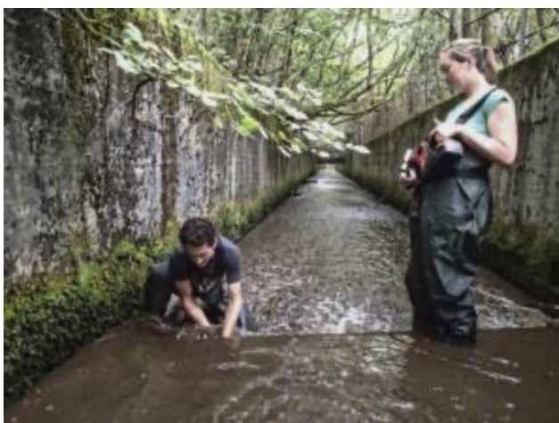
Fig. 78 Venstre: Montering av bunnelementer i en betongkanal som var vandringshindrende ved lav og middels vannføring. Høyre: Fra bygging av fisketrappen ved Osbanekulverten (hybridtrapp).
