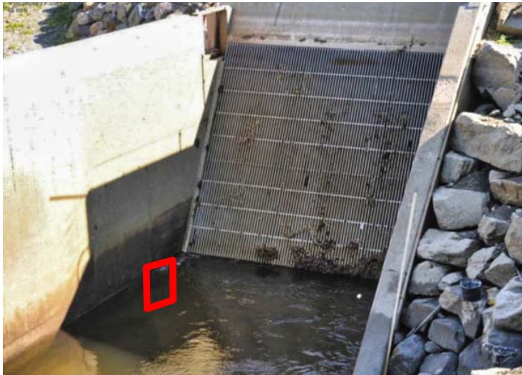
Fig. 111 Inntaksvaregrinda ved Fosstveit kraftverk. Varegrinda er dykka ca. 60 cm, og hevet ca. 50 cm over bunnen. Fluktrute for anadrom fisk er markert med blå firkant. Fluktrute for ål er ikke synlig på bildet, men markert med rød firkant. Vannspeilet ved normal drift av kraftverket er markert med blå strek. Karakteristiske data for kraftverket er gitt i tabell (høyre).
