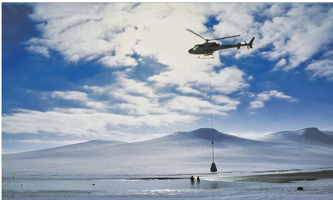
Fig. 95 Utlekking av gytegrus i Bjornesfjorden i ved bruk av helikopter. Grusen var i forkant sortert til spesifisert kornfordeling, pakket i storesekk og transportert inn til Bjornesfjorden med beltevogn.
