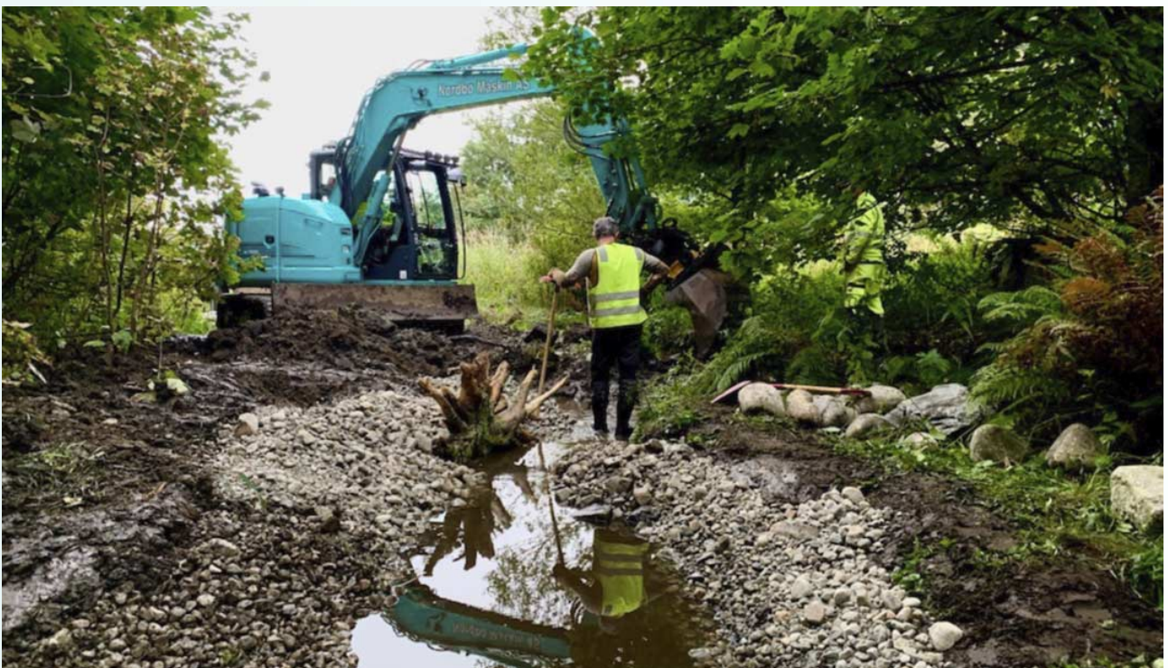
Restaurering av Mississippibekken ved Store Stokkavann i Stavanger by et prosjekt med Stavanger kommune , NIVA og sjøørreprosjektet Rogaland. Røtter er brukt for å lage struktur i bekken med kulper, brekk med gytegrus/habitatstein i denne svært viktige gytebekken for sjøaure. (Foto: Trond Askildsen)
