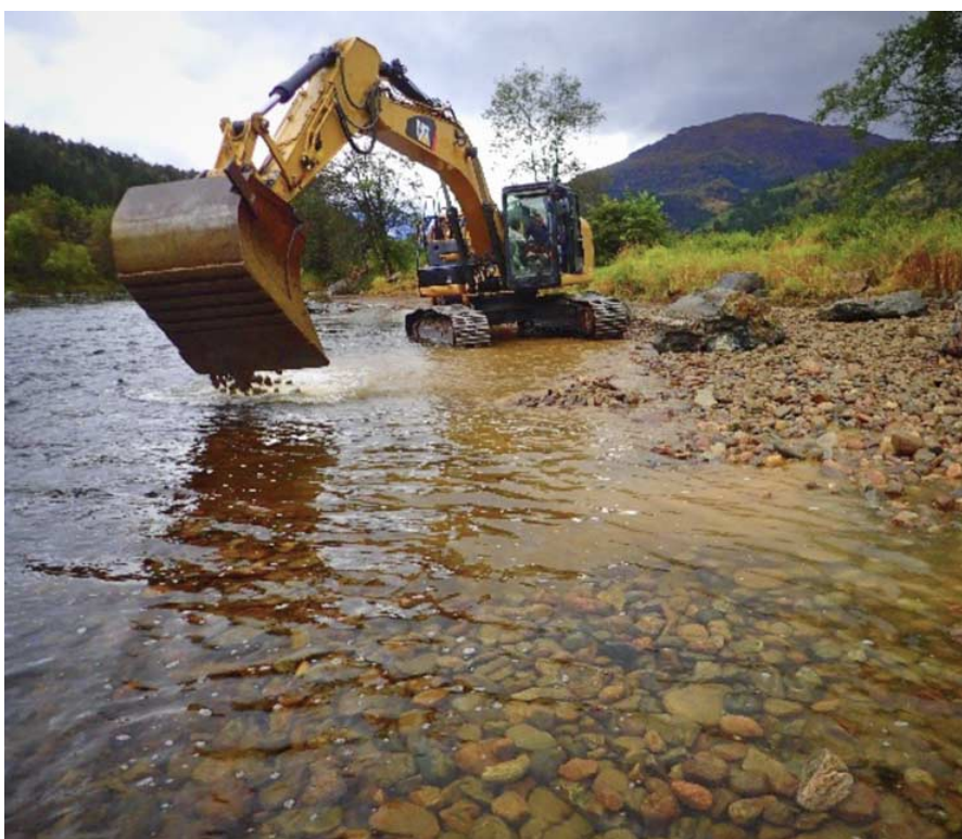
Fig. 148 Grove masser siktet for sand og fingrus legges ut langs bredden av Nausta.
