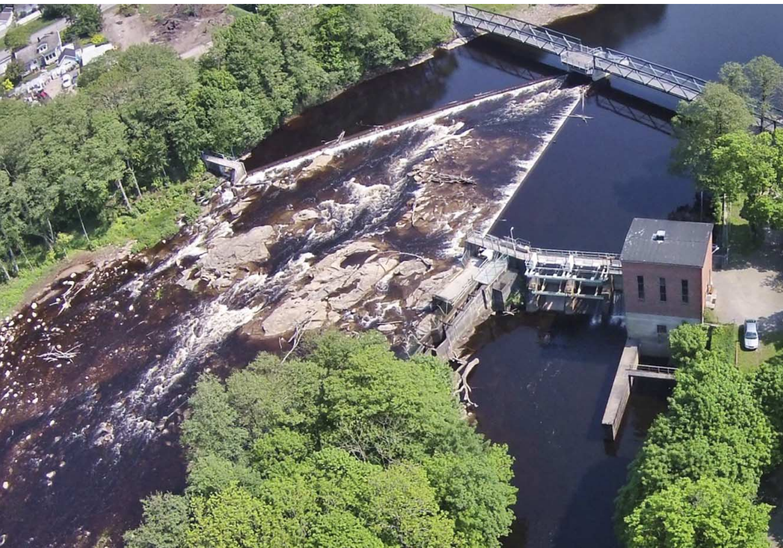
Naturtypisk omløp ved Herting kraftverk i Åtran (Sverige, se også nærmere beskrivelse i kap. 9). Omløpet har minst 11 m 3 /s og brukes både til opp og nedvandring av fisk. (Foto: Fiskevårdsteknik AB)
