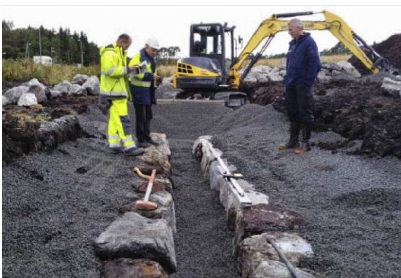
Fig. 142 Tv. Elvemuslingbekken på Haukås ligger omgitt av tykke lag med 8 mm grus. Naturstein stabiliserer kantene. Noe jord legges tilbake på toppen og tilsådd med en gressfrøblanding som får dype røtter. T.h. Steinar Kolås, Rådgivende biologer, konstaterer god vekst på muslingene etter 8 måneder i «nyebekken».
