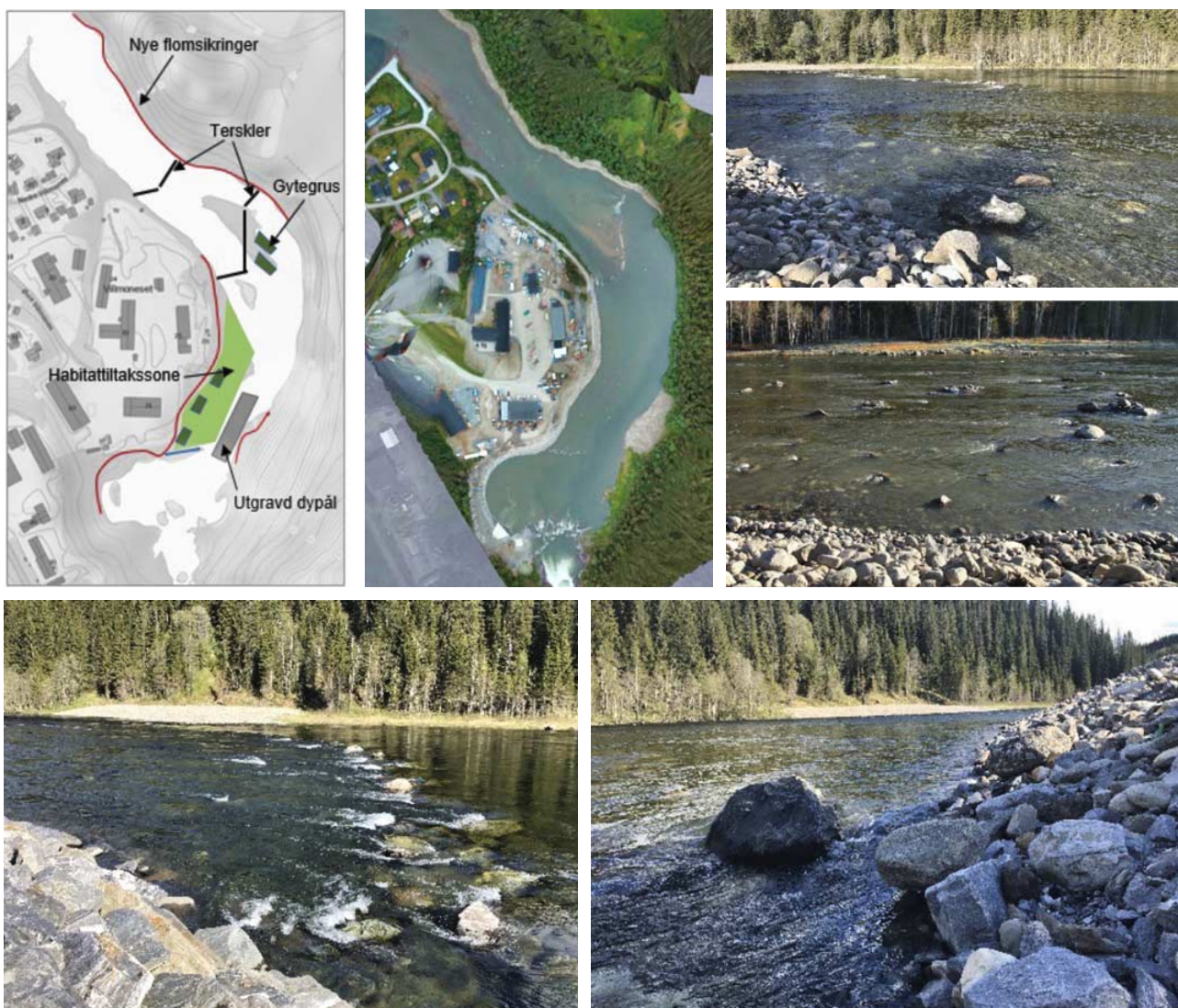
Fig. 134 «Sjøforsløpet» i Røssåga etter gjennomførte tiltak.
