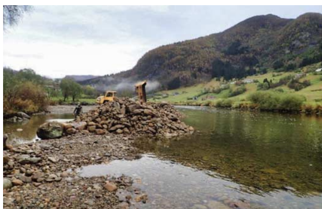
Fig. 147 Øverst: Tiltaksområder før- (venstre) og etter (høyre) habitatforbedrende tiltak. Nederst: Bilder fra arbeidet med å legge ut siktet stein som skjul for ungfisk.
