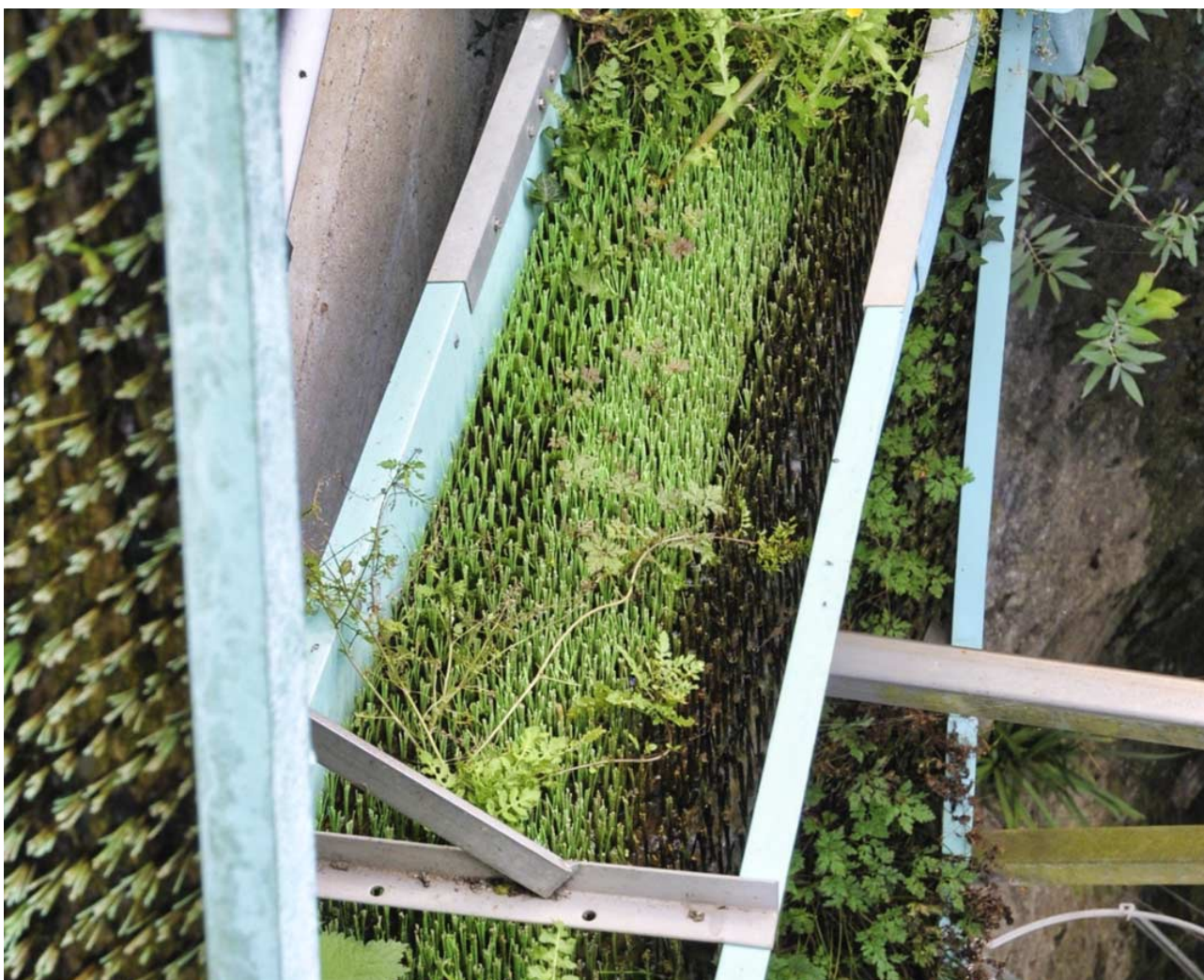
Fig. 43 Ålepassasje ved kraftverk i Frankrike. Her ledes oppvandrende glassål til en rampe fylt med «kunstgress» og vann. Denne og lignende metoder er benyttet ved mange kraftverk i Frankrike, Tyskland, Irland og England. (Foto: Frode Kroglund).
