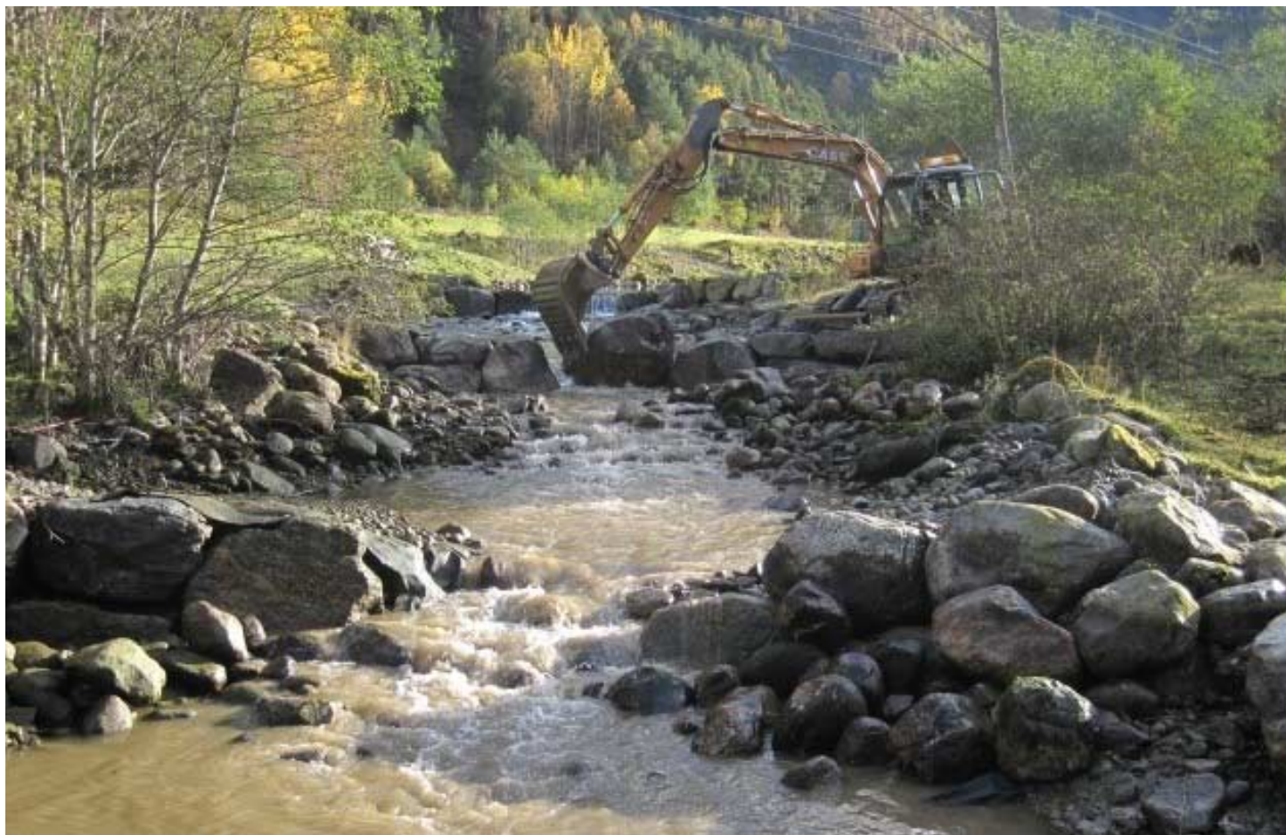
Fig. 17 Fjerning av terskler og reetablering av naturtypisk morfologi (trinn-kulp og stryk type) i sideløp til Aurlandselva (E-Co Energi, Melcon AS, NORCE LFI, se også s. 128)
