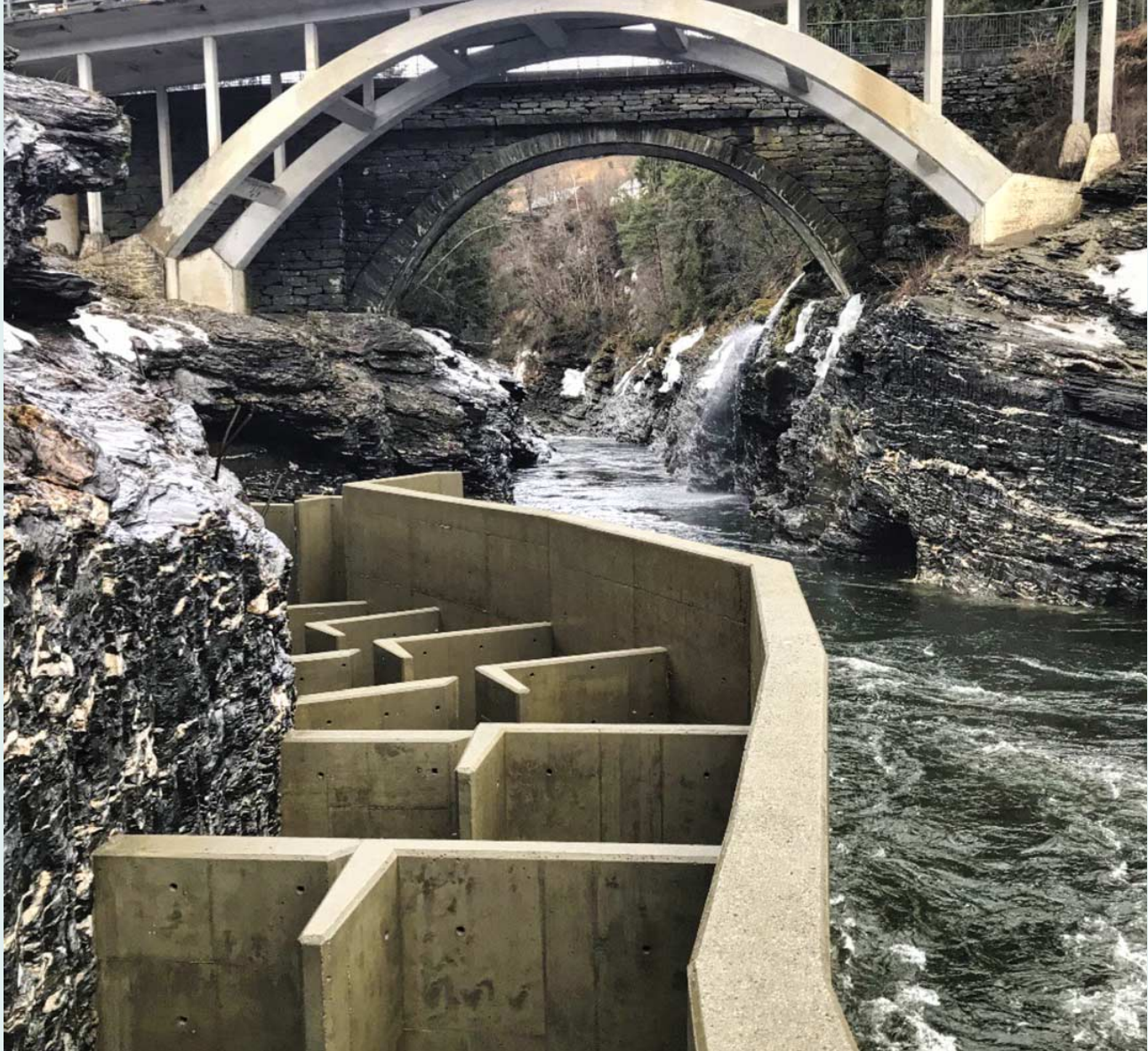
Spaltetrappen under bygging med juvet bak
