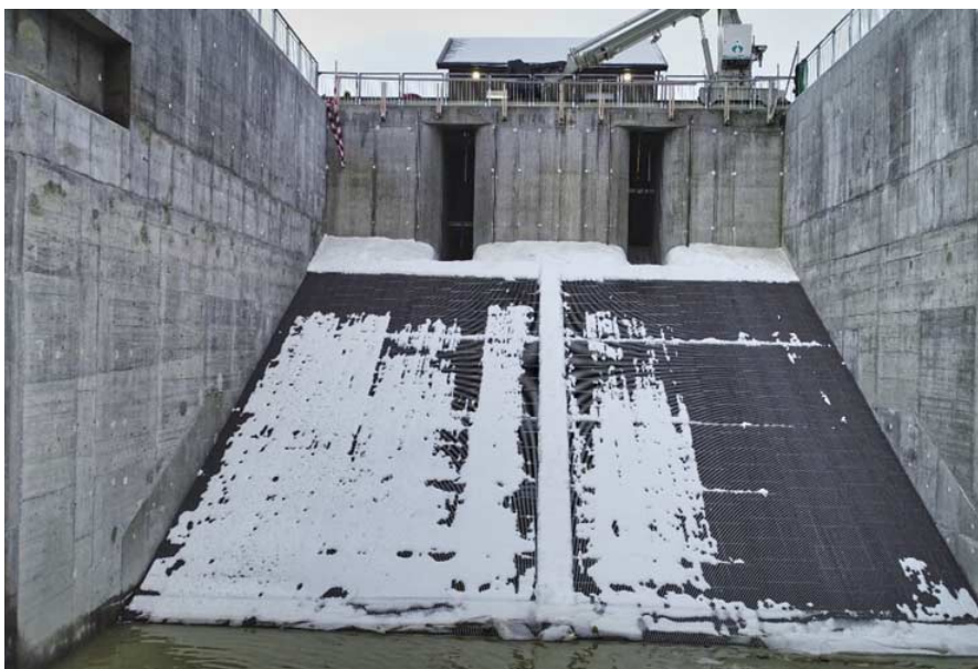
Fig. 48 30° alfa-rist med 15 mm lysåpning og 2 fiskeavledere i Tolga kraftverk. Slukeevne kraftverk 60 m 3 /s, avledere 1–3 m 3 /s hver. Regulant: Hafslund Eco/Opplandskraft, Prosjekterende: Norconsult i samarbeid med NINA Lillehammer. Foto: Lars Bendixby)
