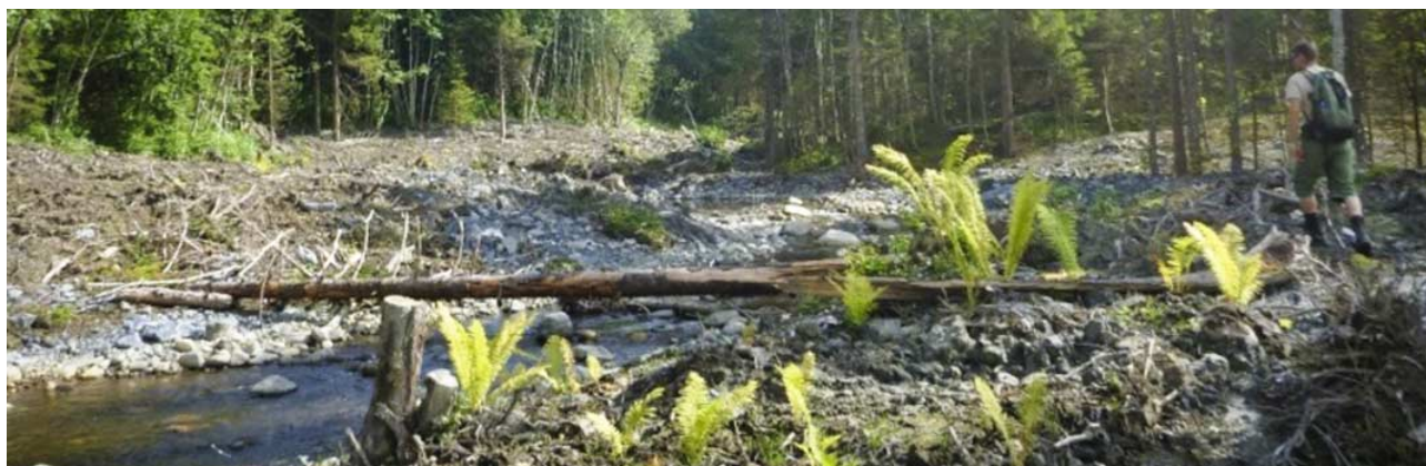
Fig. 125 Prinsippskisse som viser hvordan bekk og terrenget «heves». Bildet under er tatt på sensommeren 2015, og viser at det allerede samme sommer begynte å vokse på stedegne vekstmasser som ble lagt oppå sprengsteinen.
