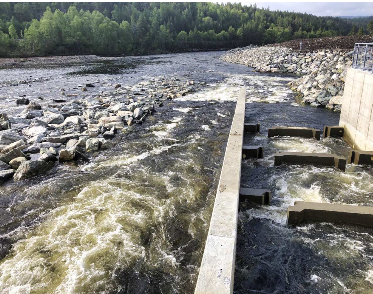
Fig. 40 Fiskepassasje forbi Tolga kraftverk. Kombinasjon av dobbeltsplattetrapp (5 m 3 /s) og rampe ved lav vannføring (3 m 3 /s), og over hele terskelbredde ved høy vannføring gir fisken forskjellige muligheter for oppvandring, noe som kan være nødvendig i vassdrag med høy artsdiversitet. Regulant: Hafslund Eco/Opplandskraft, Prosjekterende: Norconsult i samarbeid med NINA Lillehammer. (Foto: Norconsult)
