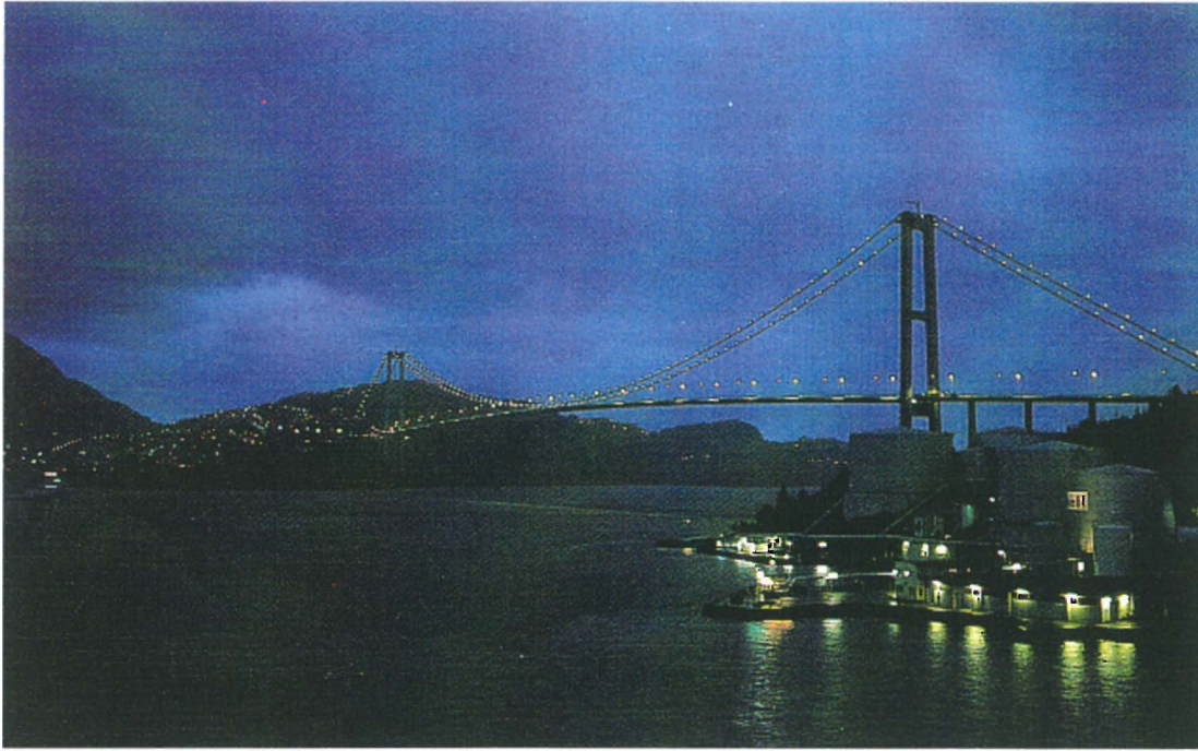
4.9. I tillegg til belysning av vegbanen fikk Askøy bru en dekorativ belysning gjennom en perlerad av lys på kablene. Perlekjeden av lys understreker hovedformen på hengebrua. Kilde: «Utforming av bruer», Vegdirektoratet, 1992
