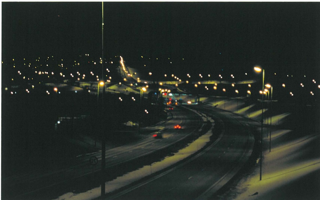
2.21. E6 Øst mot Stjørdal. Bildet er fra et parti med «tradisjonelle» armaturer som gir stor grad av blinding og lysstøy. Bruk av armatur som blander unødvendig bør unngås. Foto: Selberg Arkitektkontor As
