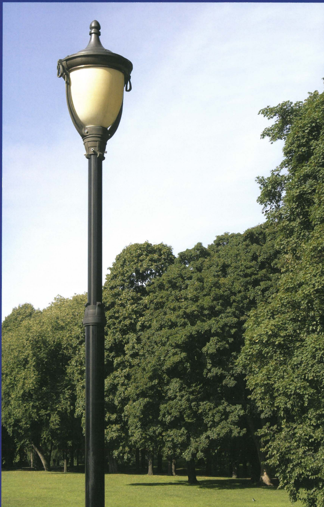
2.9. «Egget» fra Oslo er rundstråler som gir mye blending og lite lys på gategulvet. Foto: Jim Bengston
