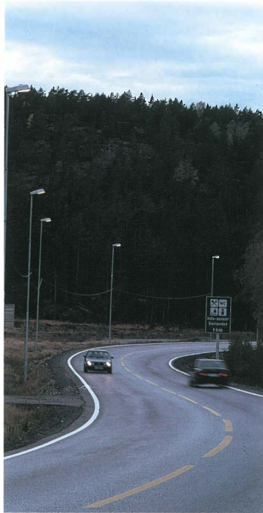
6.10. I forhold til vegens tverrsnitt vil en plassering inn mot et stigende sideterreng eller inn mot tette vegetasjonsfelt, være mindre dominerende enn en plassering ut i et synkende sideterreng eller mot åpne flater. En masterekke med terreng som bakgrunn er mindre visuelt tilstede i dagslys enn når himmelen eller utsikten utgjør bakgrunnen. Foto: Slidessamling fra Vegdirektoratet
