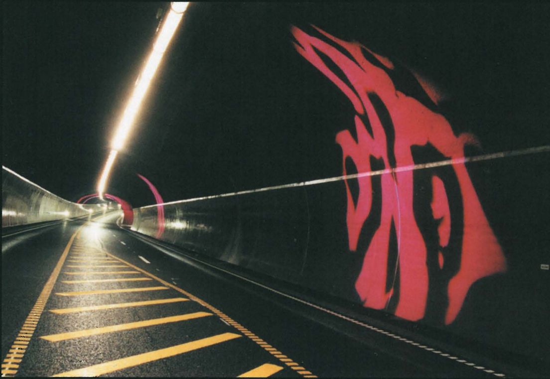
7.1 Oslofjordtunnelen. Foto: Byggenytt 6, 2000
