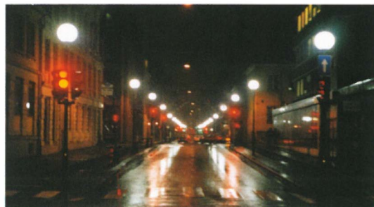
2.12-13. Rådhusgaten i dagslys og nattlys. Primærbelysningen i gaten er strekkbelysning med retningsbestemt lys av typen høytrykk natrium. Tilleggsbelysning med sideplasserte rundtstrålende armaturer er etablert i henhold til «Estetisk plan for Oslo». De sideplasserte lysene er av kvikksølvtype. Stolpene er ca 5 meter høye der lysene utgjør to «lyspølser» på hver side av gaten med en meget høy blendingsgrad. Lyset er senere redusert, nettopp på grunn av blinding og det uheldige lysmiljøet dette resulterte i. Kilde: Byggekunst nr. 1/1993. Foto: Einar Lillebye
