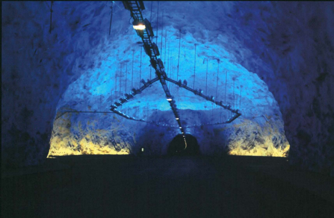
8.4. Lærdalstunellen, lyssetting av fjellhall for å bryte monotonien på den lange reisen. Foto: Erik Selmer
