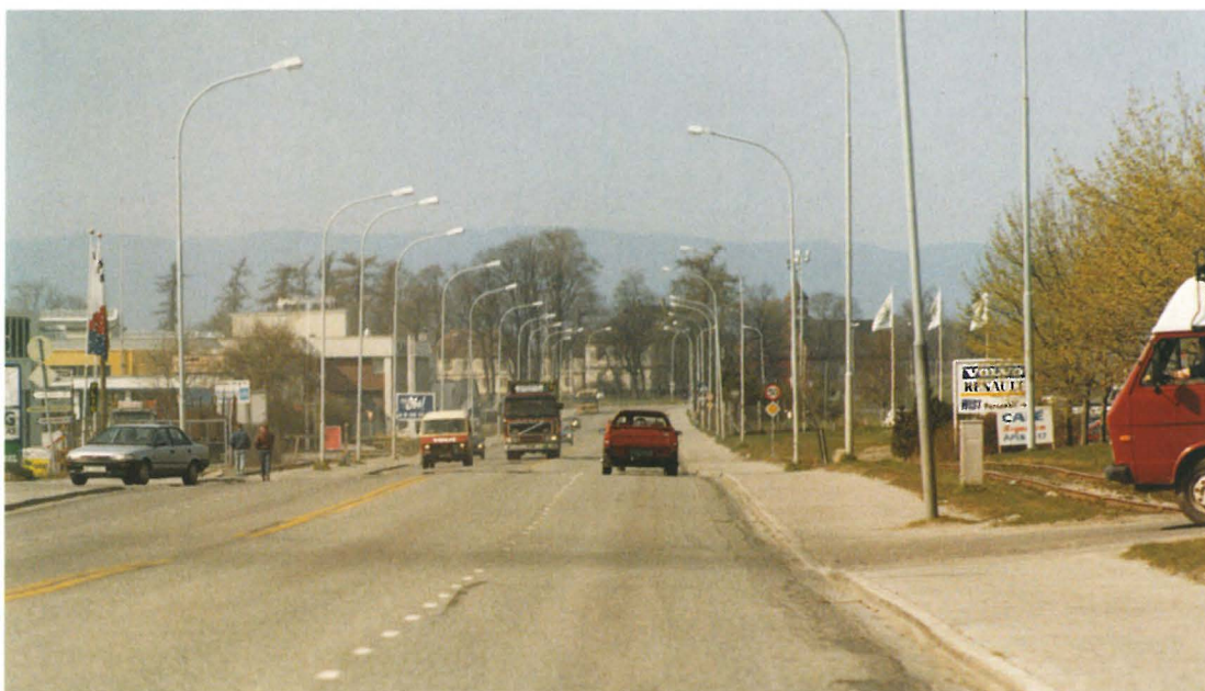
6.35. Belysning som et veganlegg, linjeføring som veg, men med kantsteinavslutning som gate. Ila, Trondheim. Ilakrysset er behandlet som et veganlegg, men ligger i bymessige omgivelser. Foto: Selberg Arkitektkontor As
