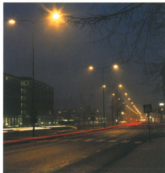
2.22. Belysningen skal følge vegens geometri; vegen må kunne leses. Den beste optiske føring oppnåes gjennom en perlerad som beskriver vegens geometri. Foto: Philips Lightning 1992/3
