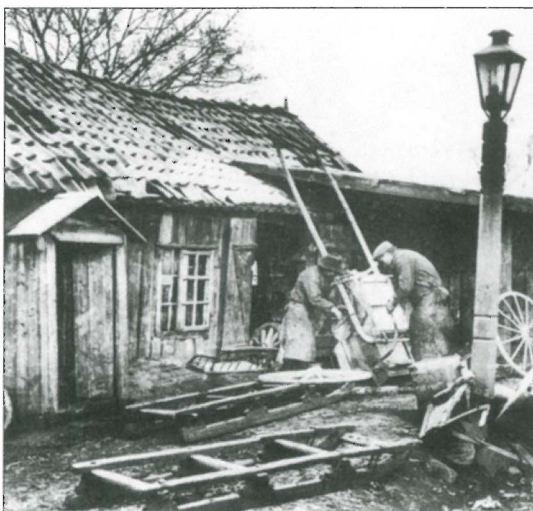
3.6. Tradisjonell oljelykt. Lykten har fire sider med utskrådde glassruter og et toppstykke med avtrekk, montert på trestolpe. Kilde: Fortidsvern 4/88
