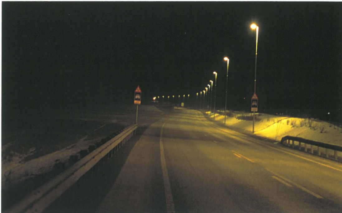
2.19. E6 Øst mot Stjørdal har i partier belysning som ikke gir blinding. Oppmerksomheten trekkes vekk fra lyspunktet og mot den belyste vegen. Foto: Selberg Arkitektkontor AS
