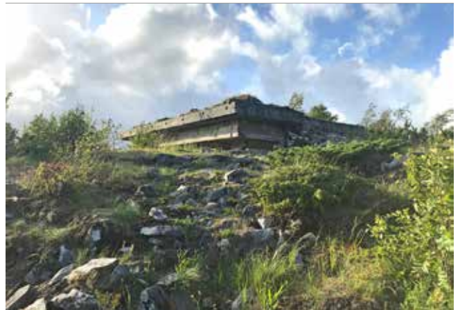
Ildledningsbunker/kommandobunker. Foto: Lise Brekmoe
