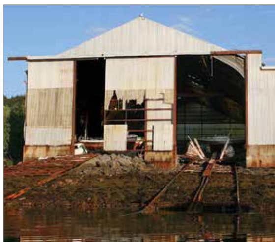
Byggehallen ved Forra slipp og båtbyggeri i 2014. Foto: Unn Kristin Laberg
