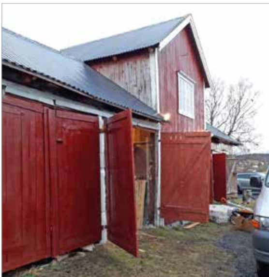
Snekkerverksted, smie og uthus er bygget på rekke på gårdstunet. Foto: Unn Kristin Laberg
