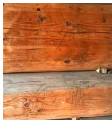
Nummerert tømmer i stabburet tyder på at bygninga har blitt flyttet. Foto: Lise Brekmoe
