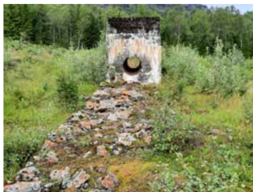
Restene etter rørgatefundamentene slik de fremstår i dag. Foto: Aina Heimdal
