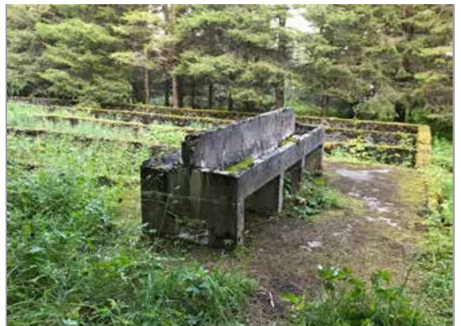
Sanitæranlegg. Foto: Lise Brekmoe
