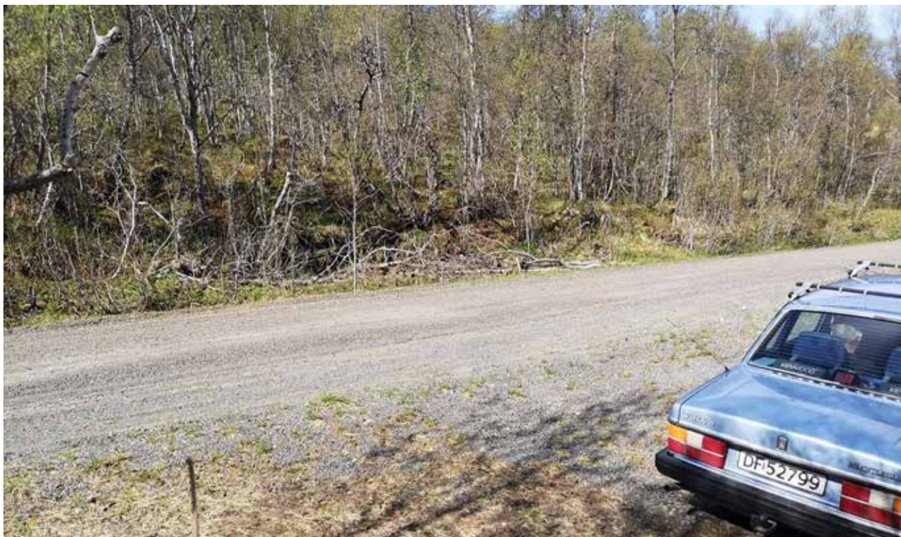
Over: Synken ved Melladalsveien. Bilen står på tippet etter prøvedriften. Foto: Tore Amund Svånå.
