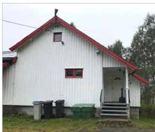
Snubba grendehus har blitt bygget ut i nyere tid, men omriset av den opprinnelige tømmerbygningen er fremdeles tydelig. Foto: Lise Brekmoe
