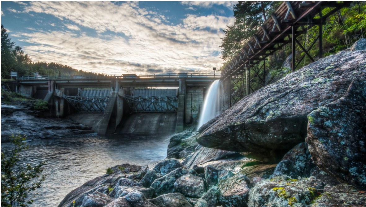
Bilde 21: Tømmerrenna ved siden av demningen (Foto: Ingvald Røinås Ingebretsen).
