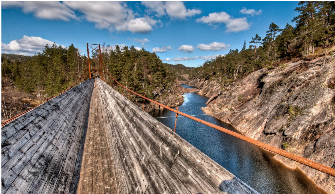
Bilde 20: Steinsfoss tømmerrenne som lukket gangvei (Foto: Ingvald Røinås Ingebretsen).
