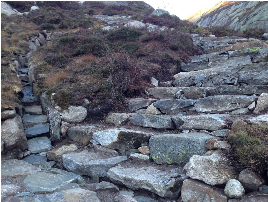
Bilde 14: Utbedret stisegment opp til Kjerag med steintrapp og restaurering av kantvegetasjon (Foto: Per Henriksen).
