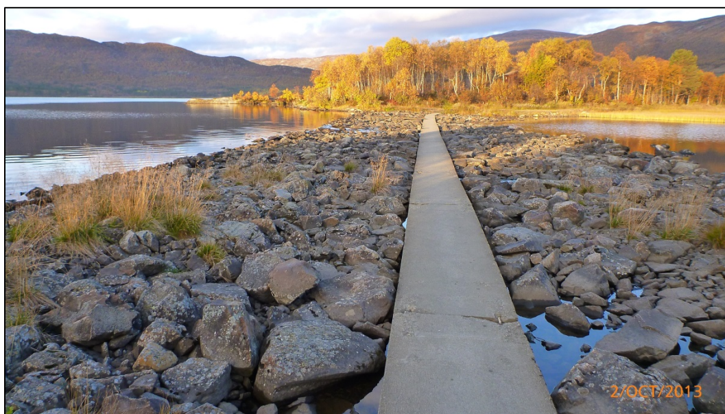
Figur 2. Undersøkte terskler i Usteåne. Tersklene er avbildet fra oppstrøms (vest i Fig. 1) og nedover (mot øst). A) Ved utløpet av Ustedalsfjorden deler en øy tersklene i to; hovedsterskelen 1 ( øverst , mot sør jfr. Fig. 1) og en mindre terskel 1A ( nederst , mot nord).
