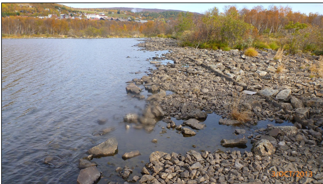
Figur 2 forts. Undersøkte terskler i Usteåne. Tersklene er avbildet fra oppstrøms (vest i Fig. 1) og nedover (mot øst).B) Øverst: Terskel 2 ved utløpet av Veslefjorden. Nederst: Terskel 3 Fossgård.
