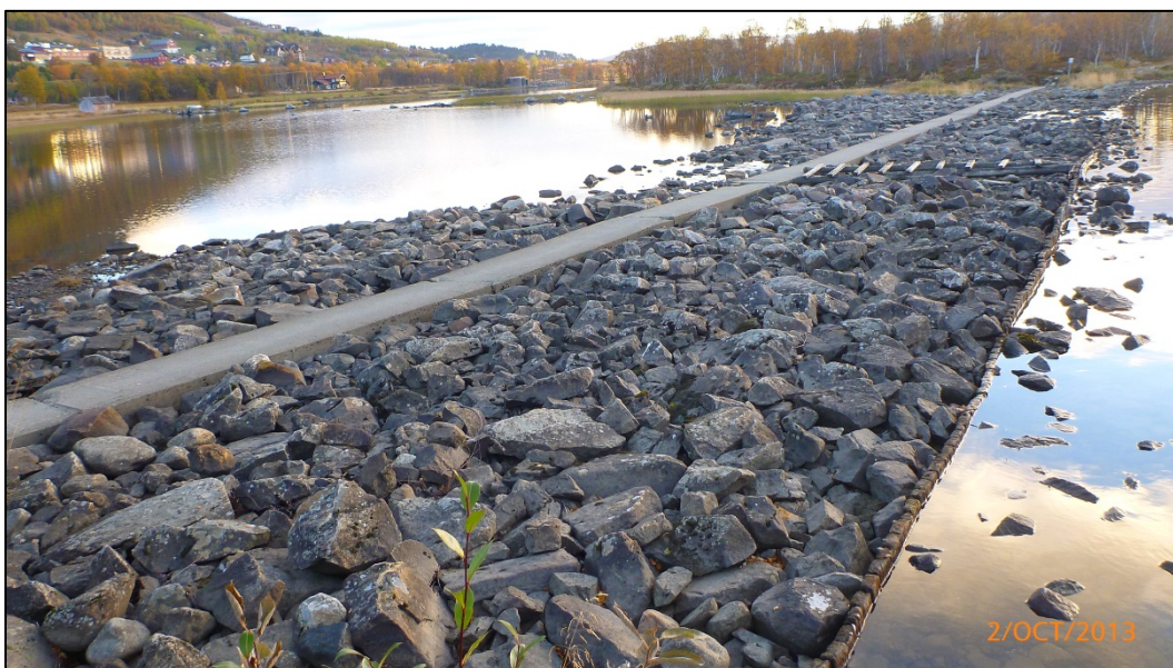
Figur 3. Løsmasseterskel ved utløpet av Ustedalsfjorden med oppstrøms tetting (nåler).
