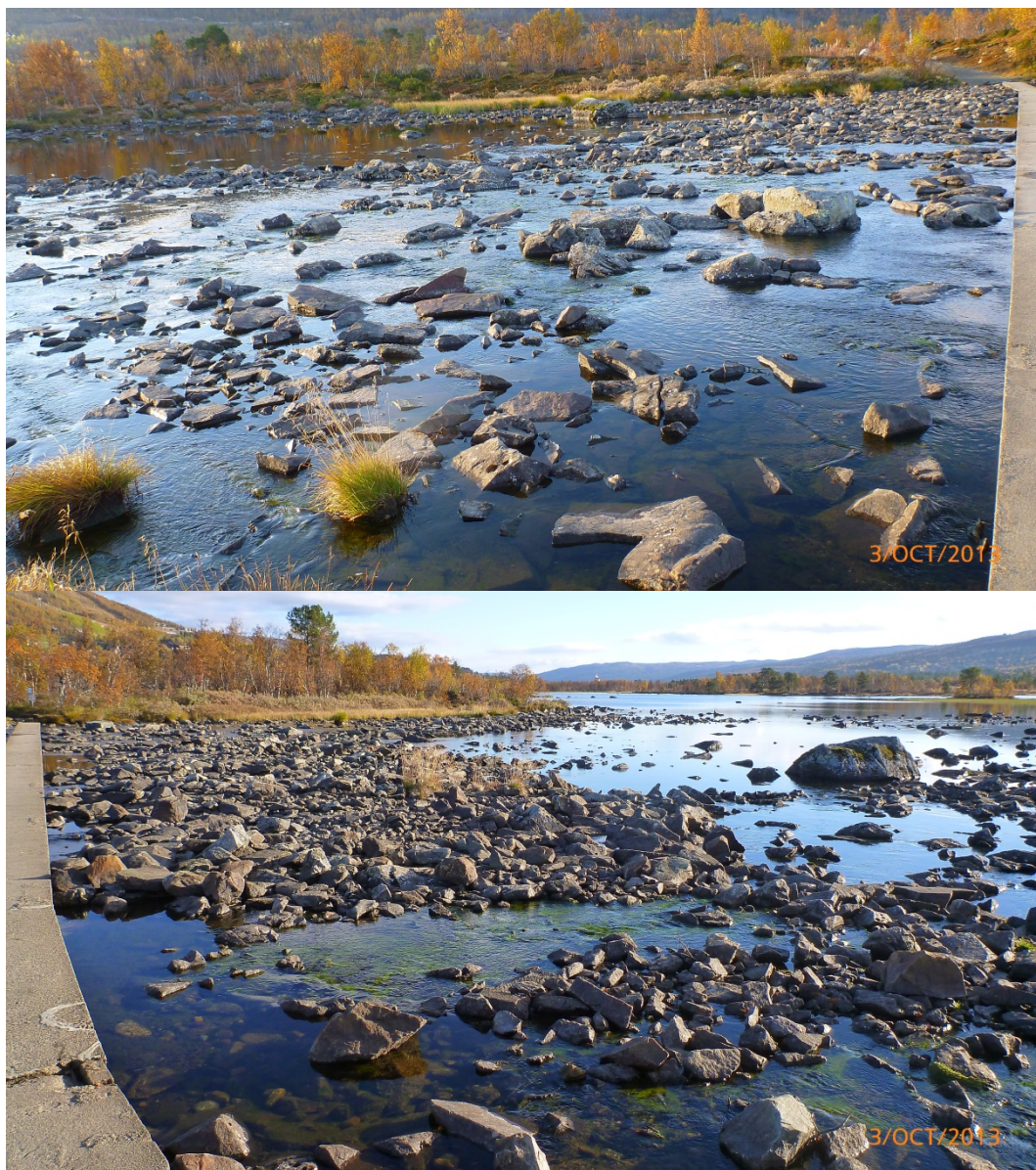
Figur 38. Terskel 1 har lite fall som allerede er utnyttet i en mer mosaikkpreget terskel med mindre lekkasje ned i grunnen enn øvrige terskler. Mot sør er vannløpet mer sammenhengende (øverst) enn mot nord hvor det er småløp (nederst).
