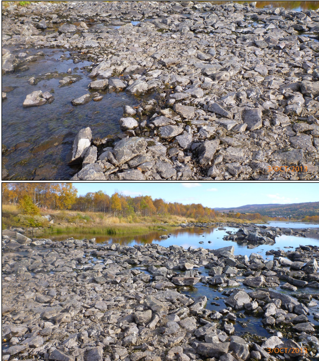
Figur 35. På terskel 2 Vesleffjorden forsvinner vannet ned i terskelen og dukker opp nedstrøms, særlig på den nordre del av terskelen. Nedre del kan ha gunstige habitater.
