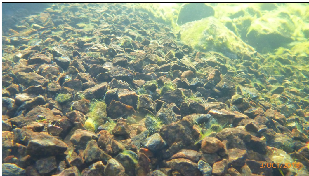
Figur 16. Grov grus av skuddstein brukt til tetting oppstrøms terskel 1.
