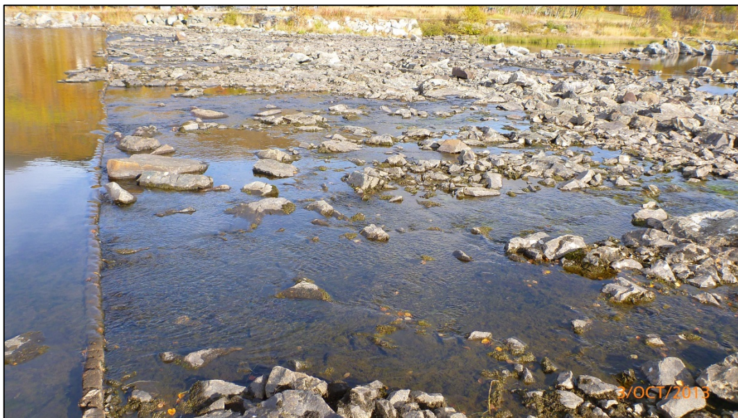
Figur 24. Oppstrøms tetting av terskel 1A og 2 på utløp Ustedalsfjorden vha. dykket nåledam.
