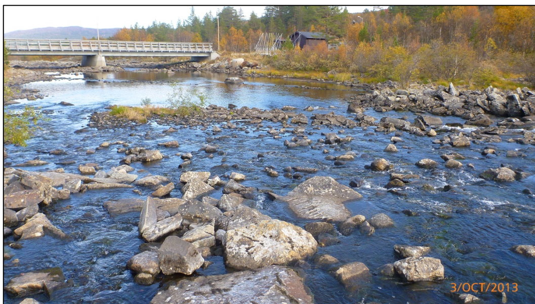
Fig. 30. Nedre, grunnere del av terskel 5 Lauverud.
