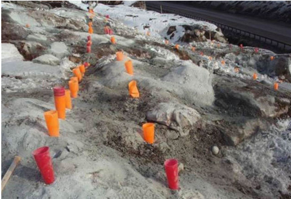
Figur 6.1 Bildet viser eksempel på uheldig plassering av hull ved slettsprengning. Konturen til venstre med akseptabel forsetning (avstand til neste hullrast – hjelperasten – midt på bildet). Det er derimot langt til neste hullrast (til høyre i bildet), dvs. alt for stor forsetning for hjelperasten. Foto: H. Fagerheim.
