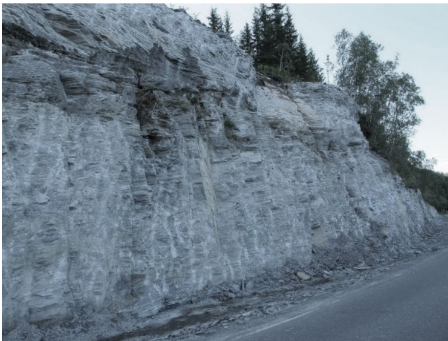
Figur 4.13 Fv. 826 i Nordland. Breddeutvidelse av bergskjæring er utført med hydraulisk hammer. Bergart er marmor. Foto: V. Aronsen.
