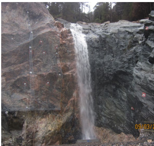
Figur 3.4 Nedføringsrenne til kum. Foto: T. Kirkeby
