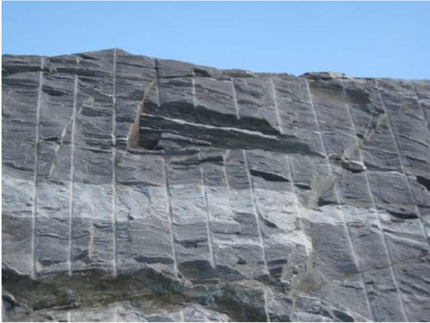
Figur 4.8 Eksempel på presplitt i godt berg. Foto: K. B. Pedersen.
