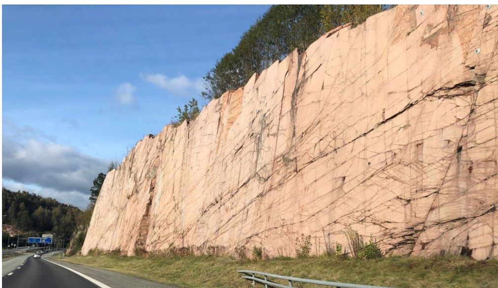
Figur 4.11 Vaiersaget bergskjæring. Foto: T. Kirkeby.
