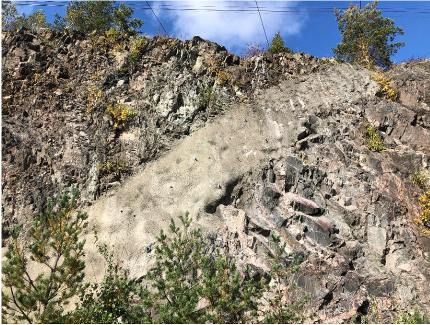
Figur 5.6 E6 i Oslo. Bergskjæring med halvmeter tykk svakhetsone skjult bak sprøytebetong. Betongen har holdt i over 25 år og effektivt stanset erosjon og utvasking langs sonen. Foto: T. Kirkeby.
