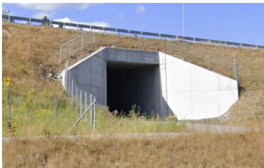
Figur 2.2.5—1 — Mulig løsning ved bruk av gjerde for å sikre konstruksjonens ytterkanter.
