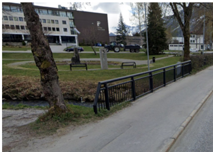
Figur 3.5.3—1 — Eksempel på avslutning av bybrurekkverk.
