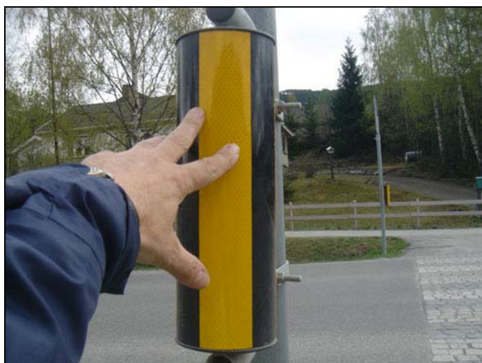
Figur 2.34 Roterbare sylindre ved gangfelt (Rolrefleks)
