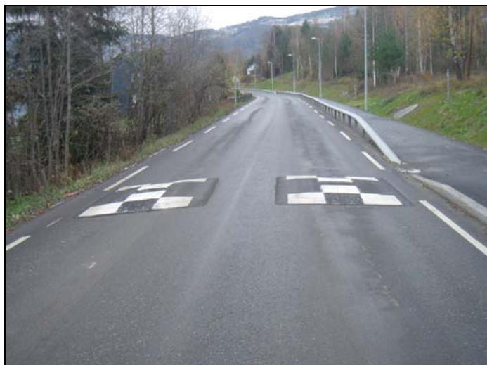
Figur 2.33 Fartsputer og 40-sone på Fv312 nord for Granrudmoen
