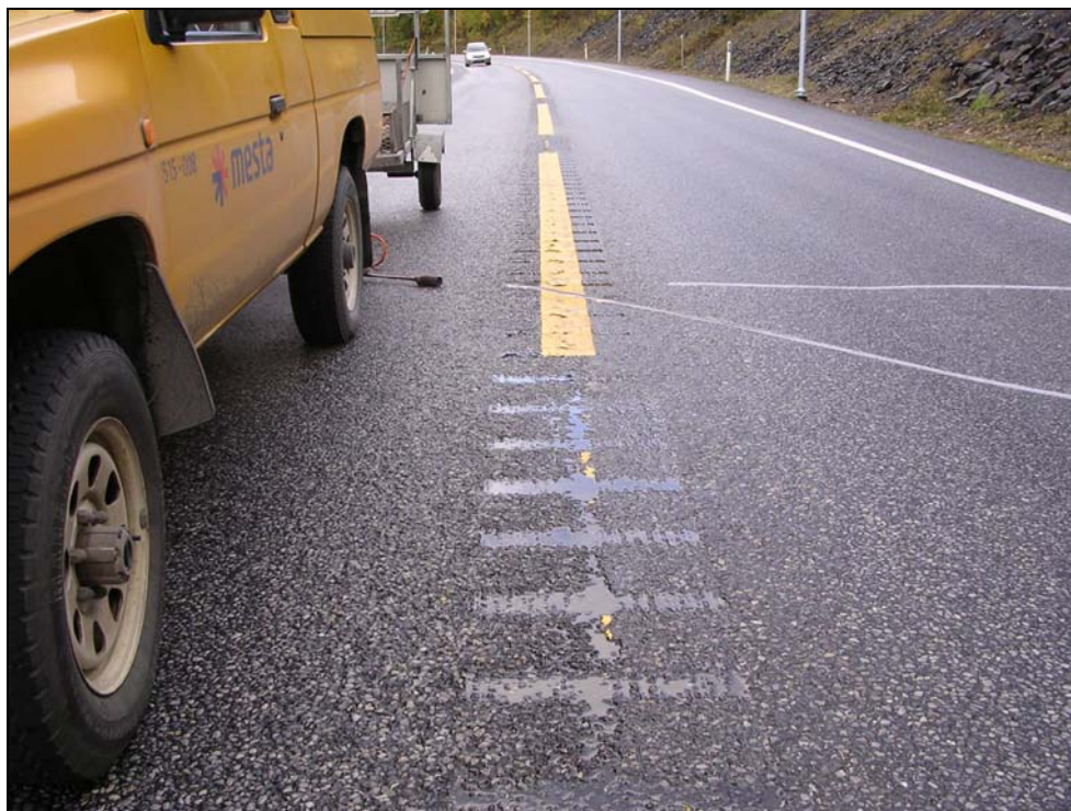
Figur 2.13 Rumlestripe med 50 cm bredde på ordinær midtlinje
