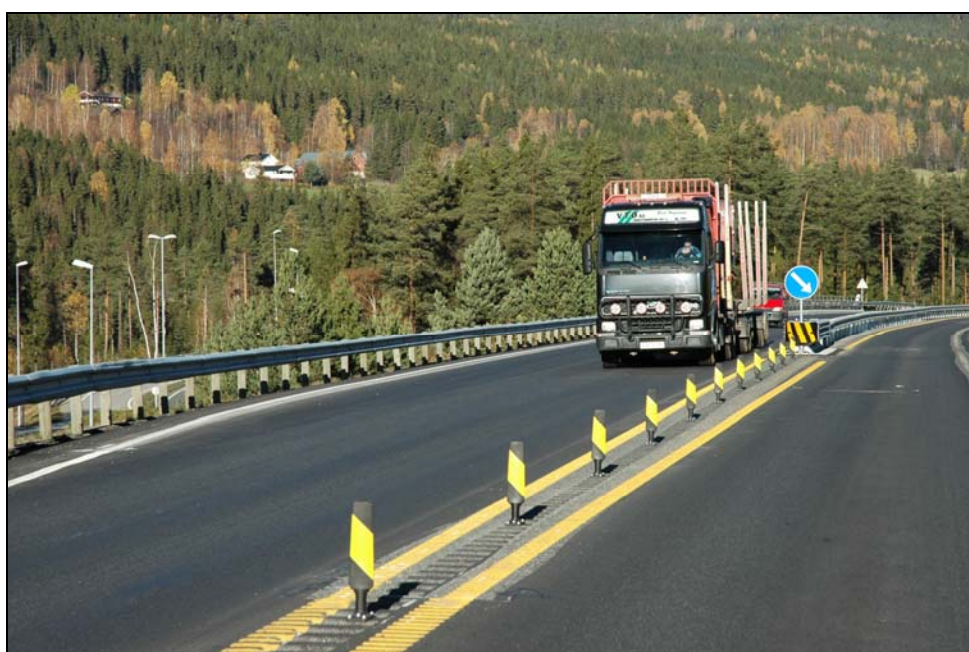
Figur 2.10 Fleksible plaststolper varsler starten av midtrekkverk på strekningen
