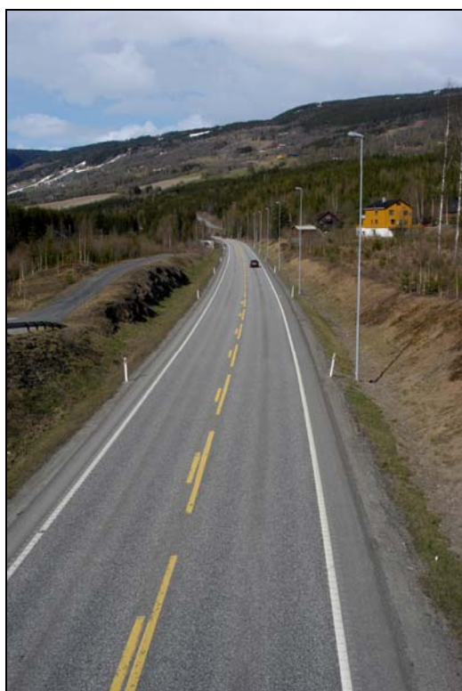
Figur 2.2 E6 i Øyer før byggestart
