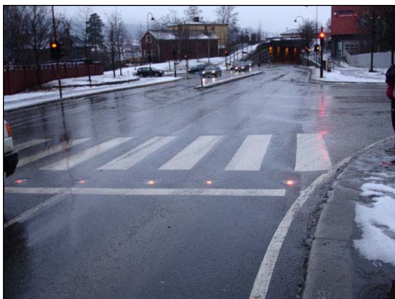
Figur 2.29 LED-lys i vegbanen i krysset Kirkegata/Brufoss gate
