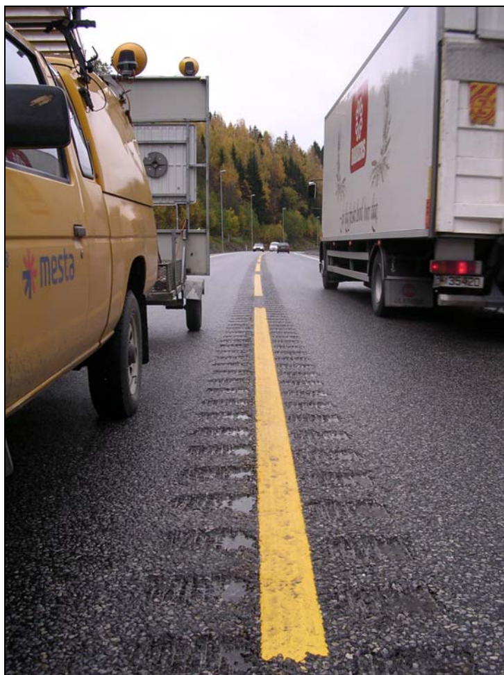
Figur 2.14 Rumlestripe på hver side av midtlinje. Total bredde 70 cm.
