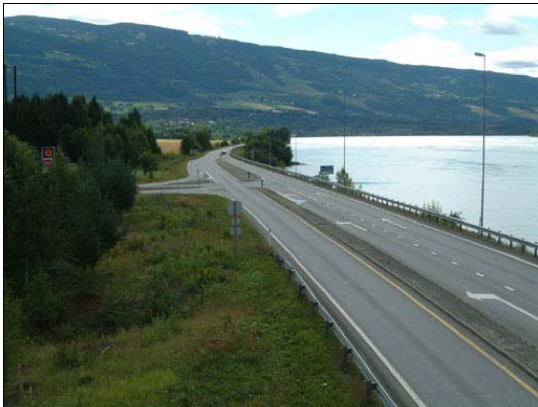
Figur 2.19 Tingbergkrysset før utbedring
