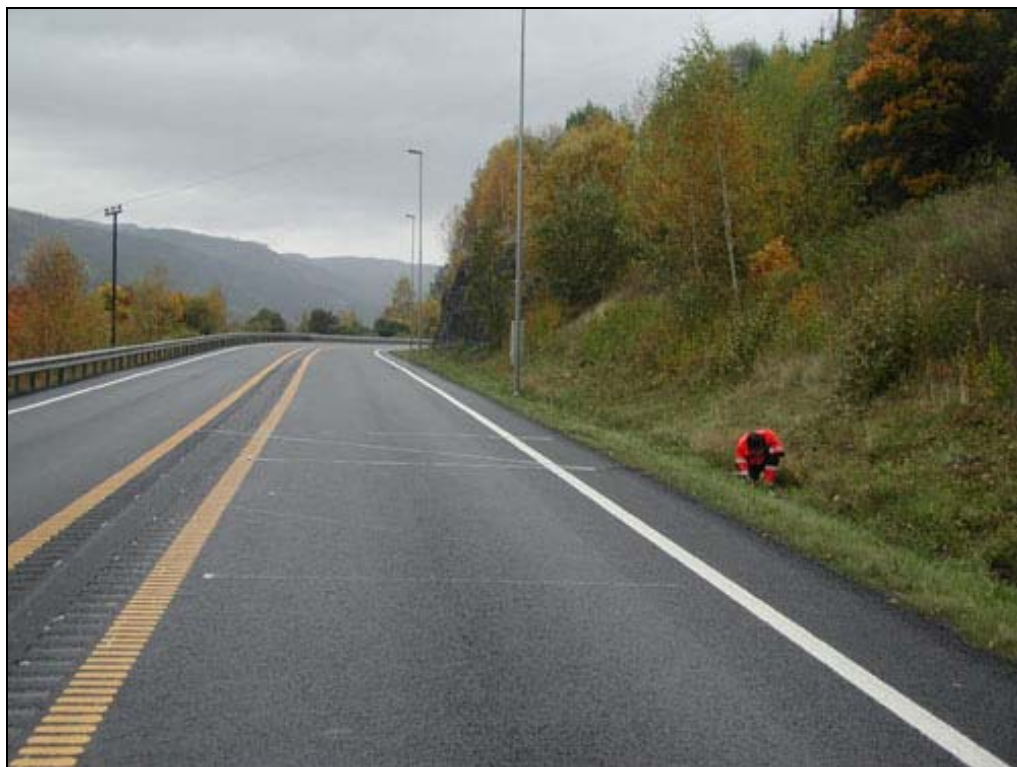
Figur 2.16 Ordinært midtfelt med bredde 1,0 meter ved Storhove
