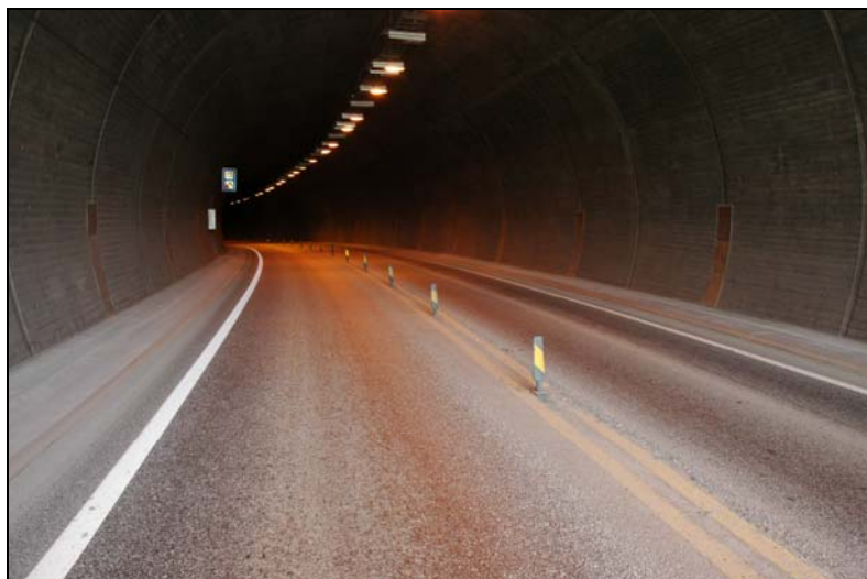
Figur 2.31 Overkjørbare plaststolper (Flexi-mark) i Sorgendalstunnelen
