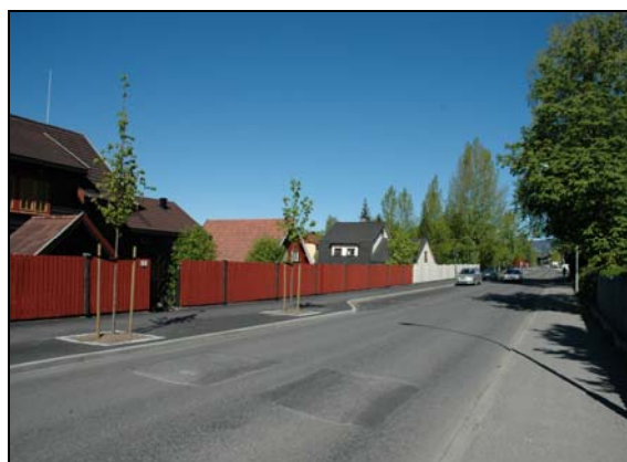
Figur 2.27 Bilde fra Storgata før og etter anlegging av fartsputer og innsnevring
