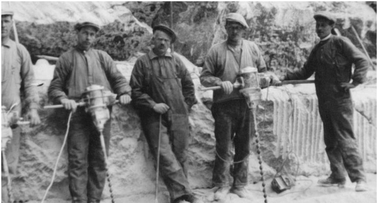
SØMBORING: Kleberarbeidere med bormaskiner, trolig i Bårstadbruddene ved Lalm på 1920-tallet. Til høyre ses sømboring i bergveggen. Foto gjengitt med tillatelse av Sel Historielag, se deres fotosamling. 8
