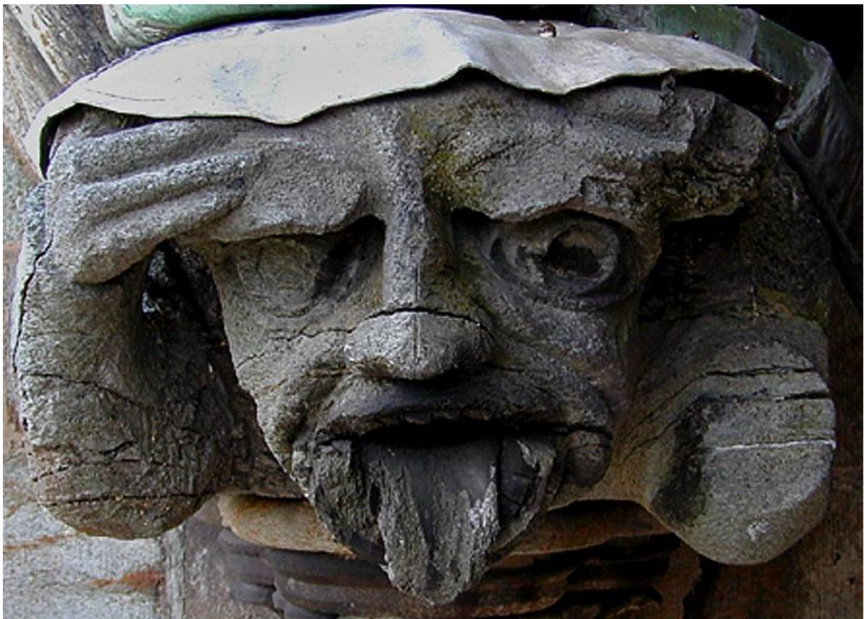
FORVITRET: Middelalderskulptur på Nidarosdomens oktagon. Slik så den ut for 20 år siden. Nå er den ødelagt. Den sprakk opp. Den må kanskje erstattes. Med hvilken kleberstein? Foto: Per Storemyr
