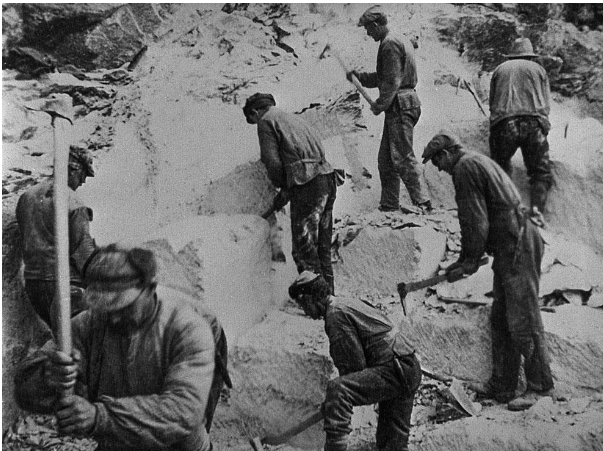
SPETTO: Uthogging av kleber med «spetto» i Vesleseterbruddet i Heidal ved Vågå i 1932. Dette var nødsarbeid i mellomkrigstiden og kleberen ble brukt til ovner og peiser. Foto: Maihaugen. 6 Foto også gjengitt i boka «Det mjuke berget» (red. Kirsti Krekling) 7
