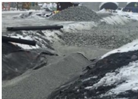
Figur 39. Oppbygging av drensledning langs veg over masselager.
