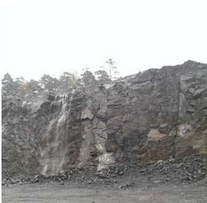
Figur 12. Veggen (nord) i dagbruddet 21. oktober, 2015. Vannet som renner over topp-kant på bruddet er fra overflatevann (foto: K.J. Tuttle).
