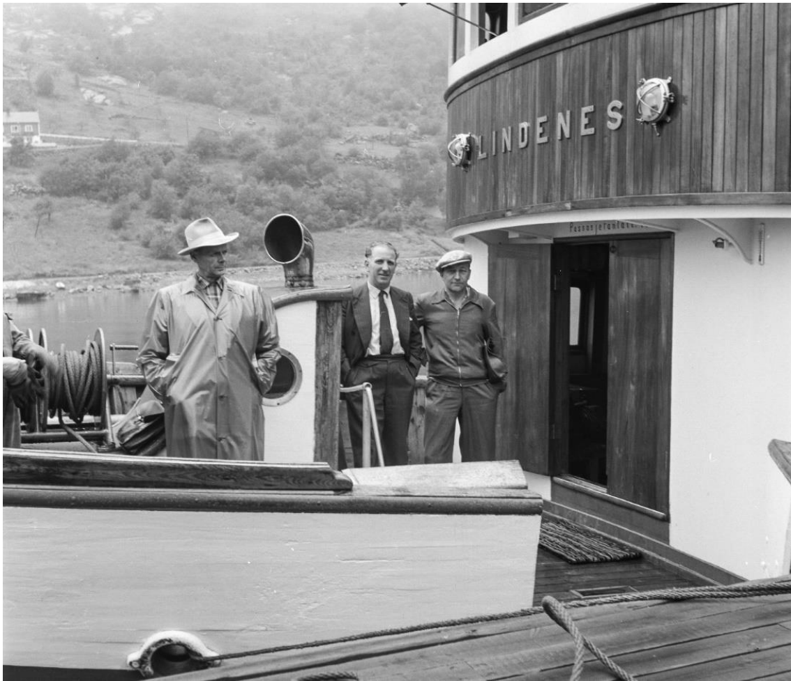
figur 135: Fordekk etter ombygging, ca. 1950-1976.
