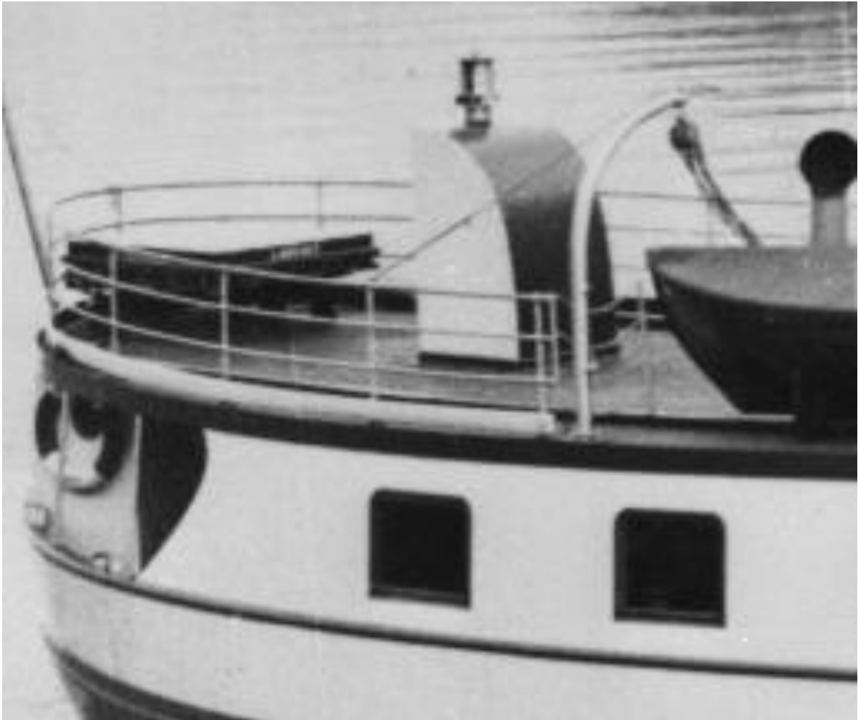
figur 93: Nedgangskappe, ca. 1950-77 (utsnitt av figur 54).
