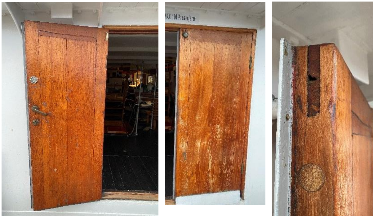
figur 72: Dobbelt hengslet dør i inngangspartiet til dekkssalongen (230), 2021. Spor etter gjenbruk.
