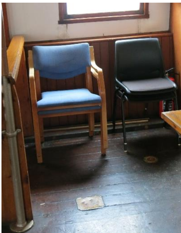
figur 82: Dørk i dekkssalong, spor etter feste for benk og bord akter mot maskinrom, 2015.
