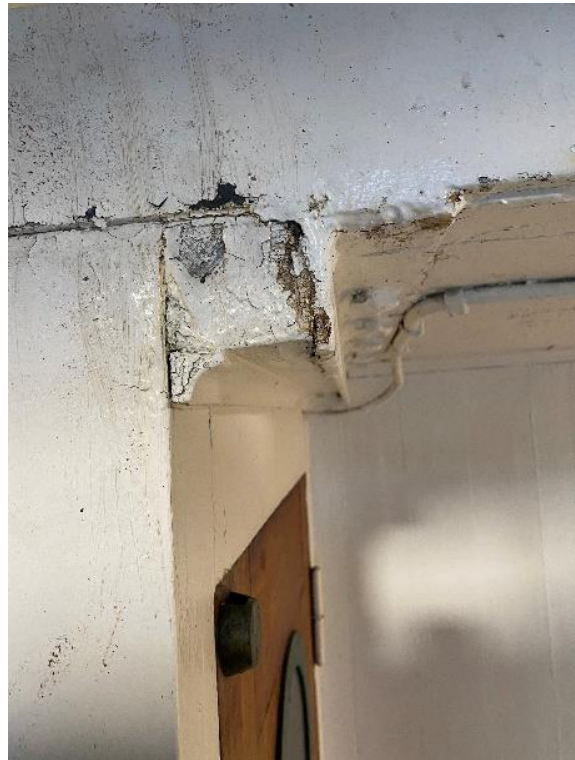
figur 69: Avkuttet stålbejelke, 2021. Endring i forbindelse med bygging av ny trapp opp til båtdekket (330).
