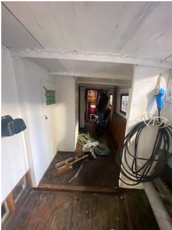
figur 70: Rester av svill i akre skott styrbord, 2021. Skottet ble bygget i 1950.
