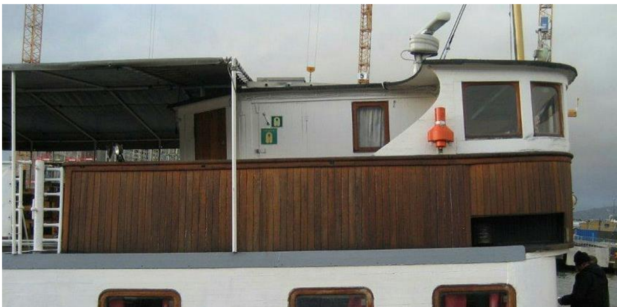
figur 109: Dør til trapperom (321) på båtdekket er på samme sted, men et vindu er fjernet og erstattet med en dør der det er bygd inn skap for sikkerhetsutstyr (321). Samme dørløsningen gjelder for skap 323. 2014.
