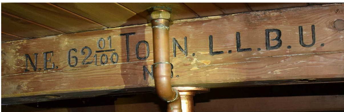
figur 58: Dekksbjelke med nettotonn og kjenningssignal innrisset, 2015.
