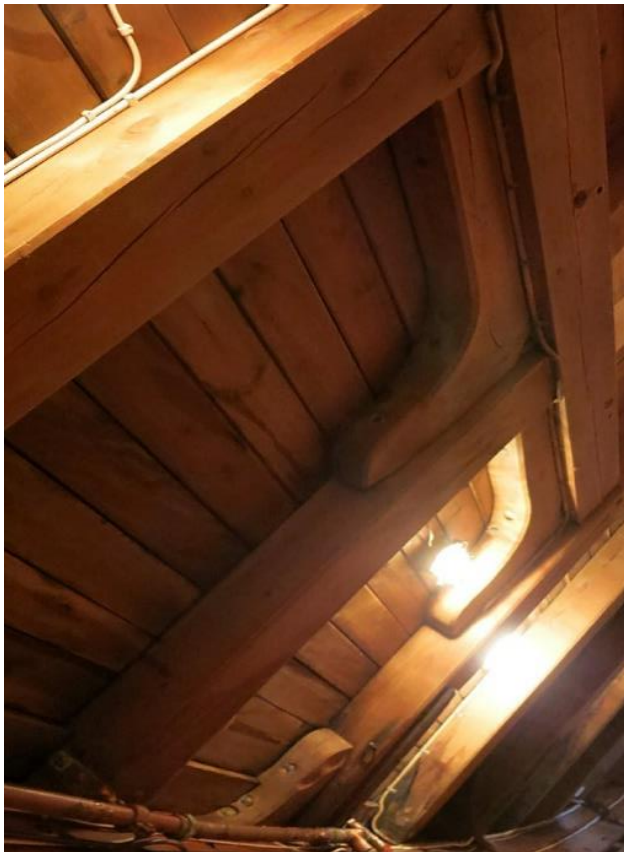
figur 11: Det er fem par vinkelknær rundt luka til ruffen.
