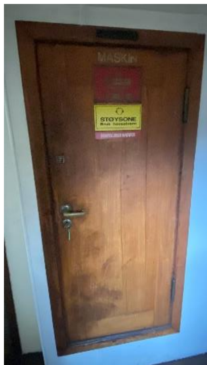
figur 74: Dør til maskinrom (140), 2021. Dører til toaletter er like.
