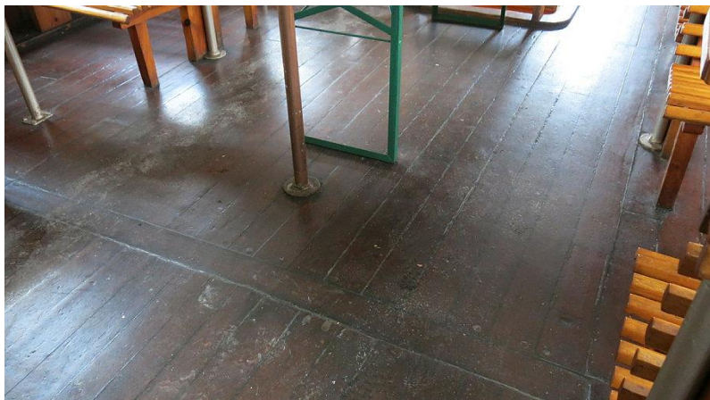
figur 22: Spor etter fronten på original lukekarm i dekket, 2014.
