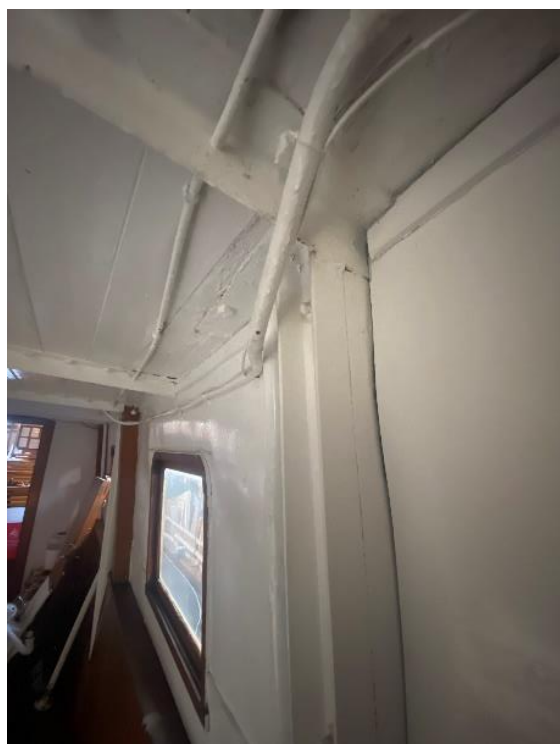
figur 67: Overgang mellom stålbjelke og profil, 2021.
