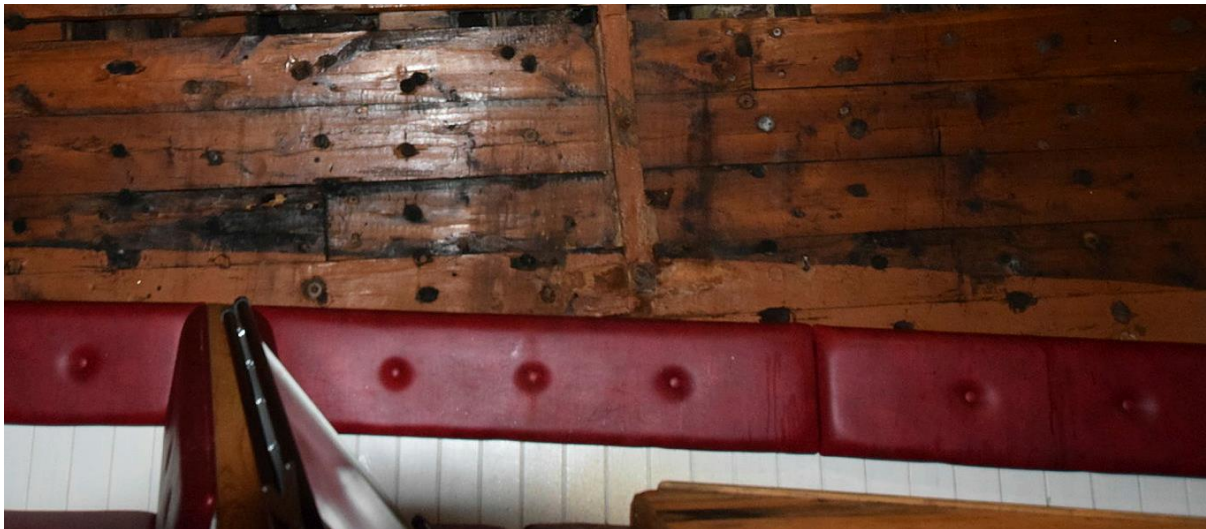
figur 59: Malt linje i garneringen rett over benkene, 2015. Det er usikkert hvorvidt det er malt lenger ned.
