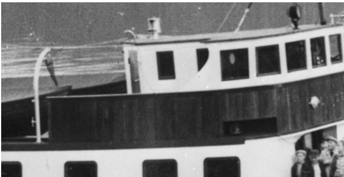
figur 108: Dør til trapperom (321) og to vinduer i bestikk (320) (utsnitt av figur 134).
