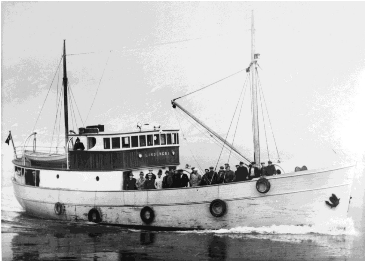
figur 9: MS «Lindenes I», ca. 1946-50. Legg merke til at den korte stålveggen langs akterdekket (220) er forlenget med presenning.
