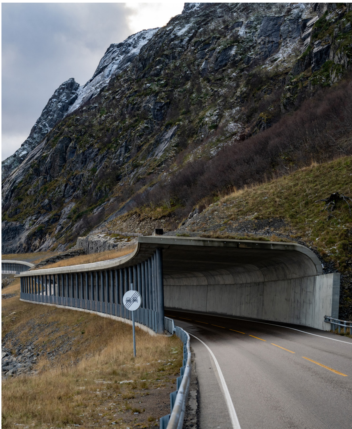
E10 Rasoverbygg Moskenes. Et prosjekt knyttet til Nasjonale turistveier som slynger seg i fire etapper langs havet gjennom Flakstad og Moskenes kommuner i Lofoten. Foto: Bård Asle Nordbø, Statens vegvesen.
