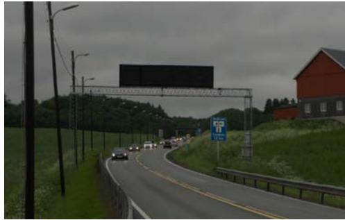
Teksttavle ved Storler med reisetidsinformasjon og hendelsesvarsling
