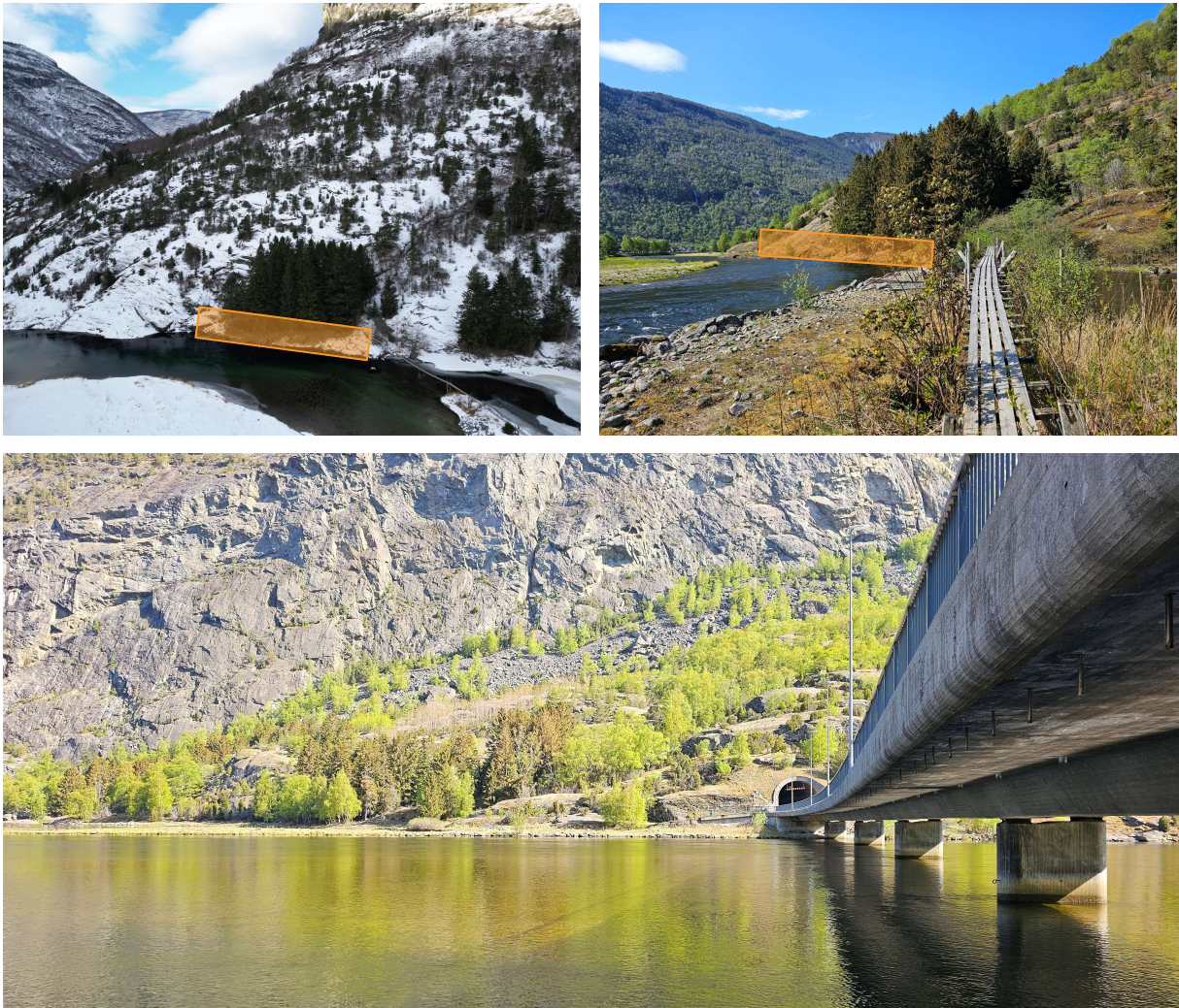
Figur 5-25: Inntaksområdet når sett fra høyden (tv.). Inntaksområdet når sett fra fotbro langs nordsiden av Lærdalselva (th.). Evt. utløpsområdet ved Jektesanden i sammenheng med Hellerbrui (under). Den oransje polygonen viser omtrentlig plassering av inntaksarrangementet.
