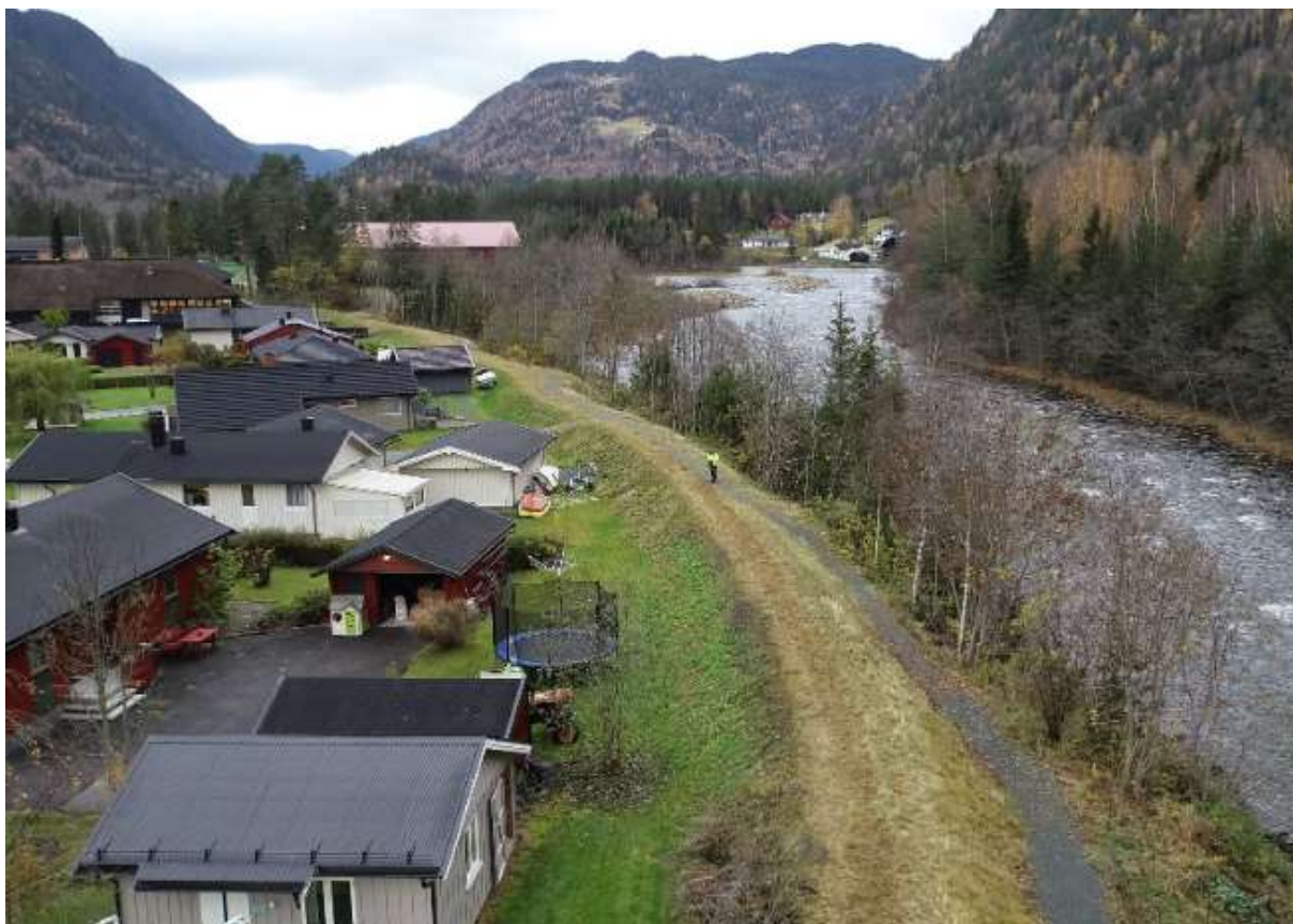
Figur 5-3: Eksempel på en konstruksjon som sikrer mot oversvømmelser i Dalen, Tokke kommune. Det er en flomvoll mot Tokkeåi og med tursti på toppen. Foto: Bjørn Lytskjold, NVE.
