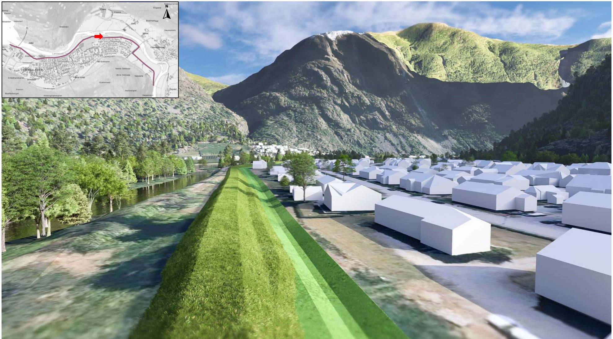
Figur 2-10: 3D-illustrasjon av planlagte flombarrierer og grøfter i tiltakskombinasjon 2A ved Hanseskogen sett fra vest.
