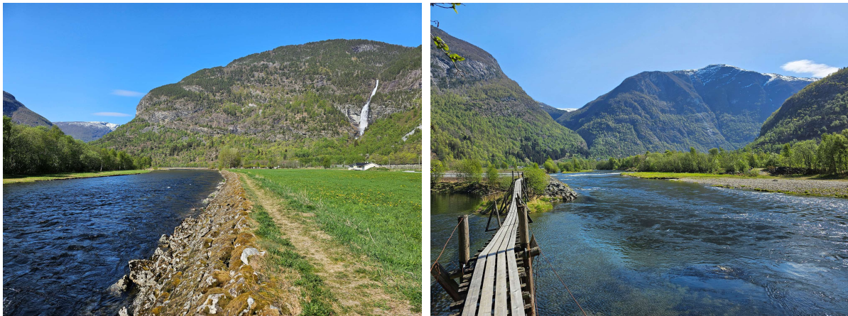
Figur 5-27: Kanalisering av Lærdalselva (venstre) i kontrast til nylig deponerte masser (høyre).
