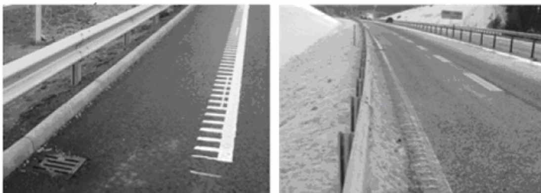
Figur 17: Oppsamling av saltholdig avrenning fra veibanen gjennom kantrenner og sluk på E4 ved Begråsen i Sverige for beskyttelse av grunnvannsressurs brukt til drikkevann (Lundmark, 2008).
