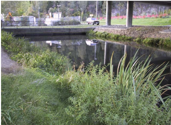
Figur 11: Rensedam ved E6 Skullerud i Oslo med helstøpt og lukket sedimentasjonskammer og vanddyp 1,5 m (Fra Åstebøl og Coward 2005).
