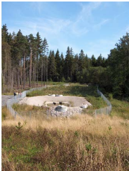
Figur 12: Rensedammer ved E6 i Råde som består av et eget sedimentasjonsbasseng med hard bunn etterfulgt av et grunt våtmarksfilter (0,5 m) med overløp til bekk (Foto: Roger Roseth).
