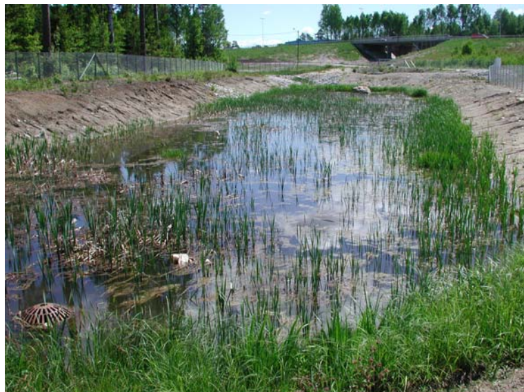
Figur 12: Rensedammer ved E6 i Råde som består av et eget sedimentasjonsbasseng med hard bunn etterfulgt av et grunt våtmarksfilter (0,5 m) med overløp til bekk (Foto: Roger Roseth).
