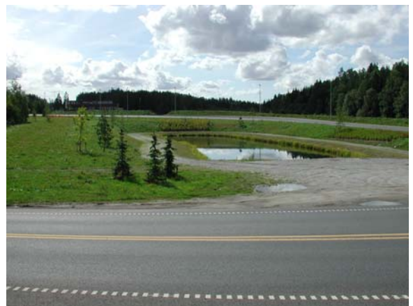
Figur 10: Rensedam for behandling av overvann E6 ved Taraldrud i Ski kommune med helstøpt sedimentasjonskammer og vanddyp i hovedbasseng 2,5 m (Foto: Roger Roseth).
