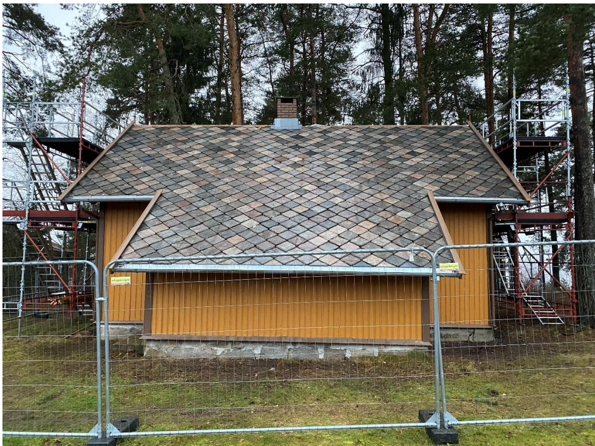
Foto: Øystein Bøe – Rehabilert tak på Sonsveien banevokterbolig med fantastisk fargespill
