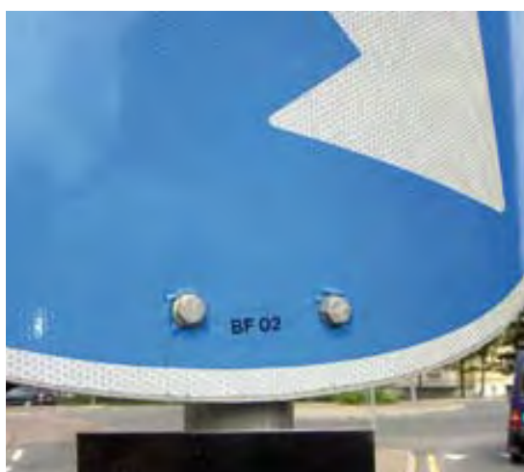
Figur 2.2—2 — Merking av trafikkskilt med kode for leverandør og angivelse av hvilket år skiltet ble produsert
