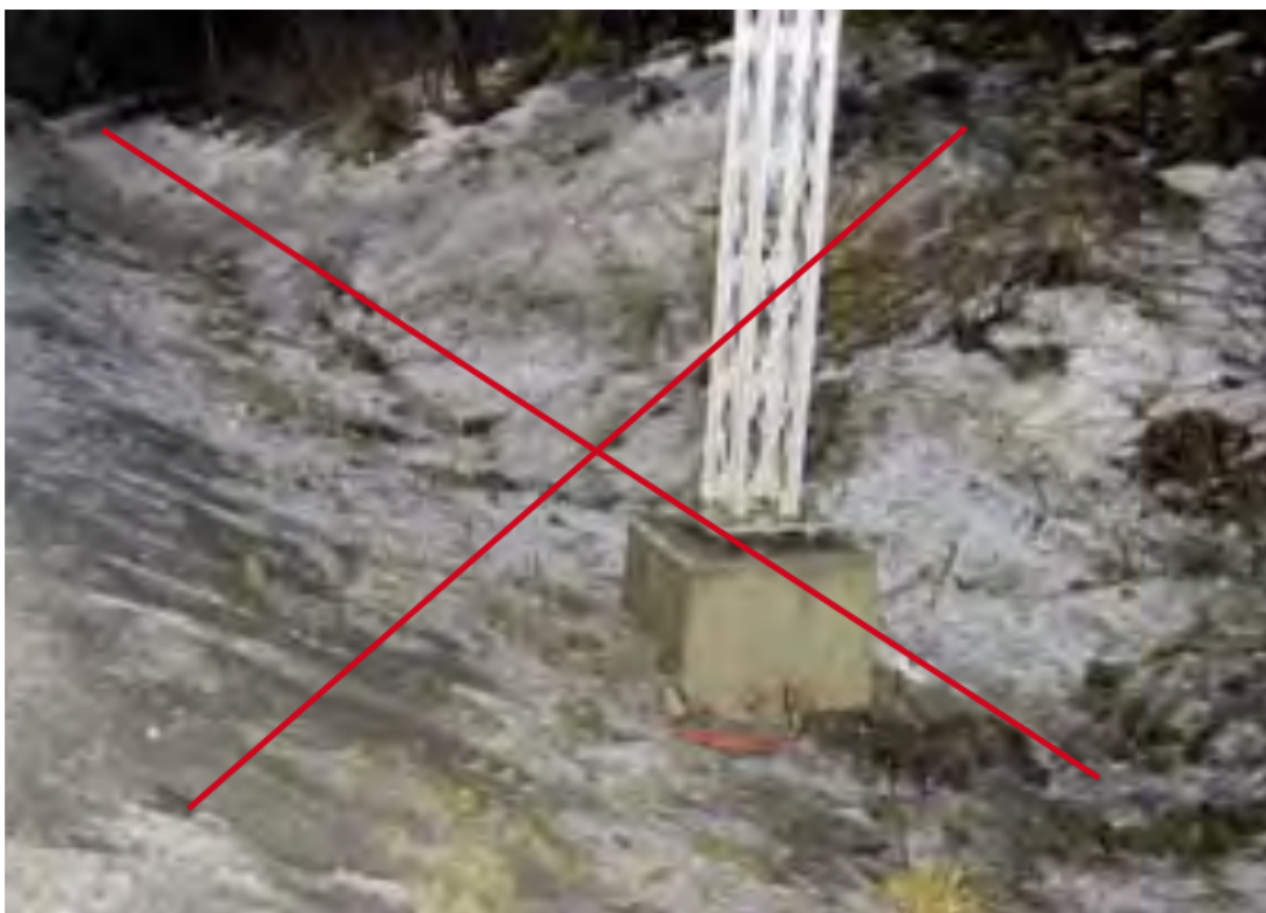
Figur 4.2.5—1 — Topp fundament følgernormalt terreng høyden og bør ikke stikke opp som her.
