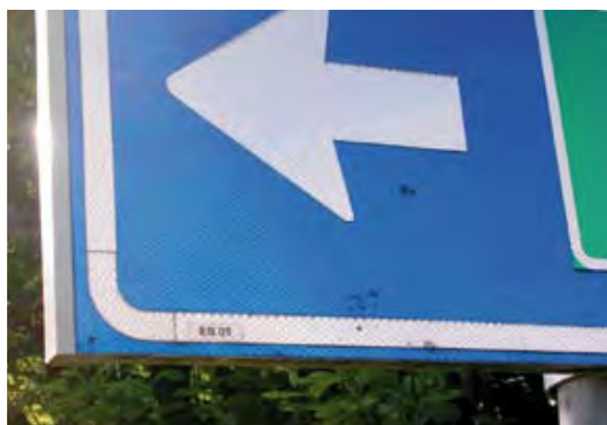
Figur 2.2—2 — Merking av trafikkskilt med kode for leverandør og angivelse av hvilket år skiltet ble produsert
