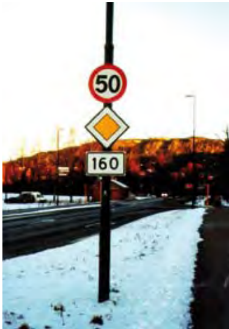
Figur 4.2.4—5 — Trafikkskilt montert på en lysmast med avskjæringsledd (NE)
