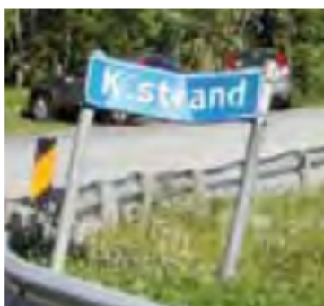
Figur 5—1 — Eksempler på behov for skiltfornying (fortsetter)
