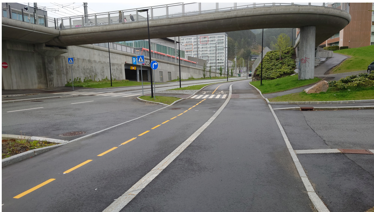
Figur 3.2—1 — Eksempel på tydelig utformet avkjørsel som krysser sykkelveg med fortau der kjørende i avkjørselen har vikeplikt for annen trafikant iht. Trafikkreglene §7 nr. 4. Denne vikeplikten gjelder både for syklende og gående i sykkelvegen og kjørende i gaten.
