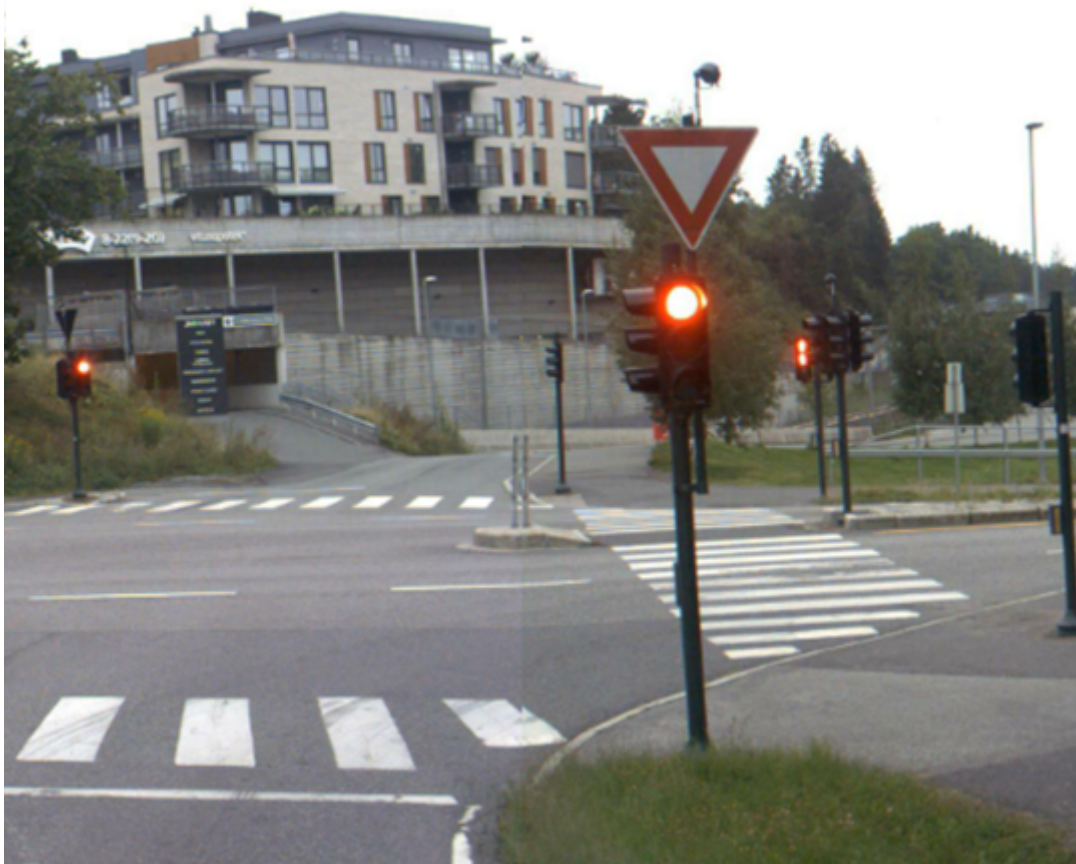
Figur 3.2—6 — Vikepliktskilt er tillatt montert på signalstolpe
