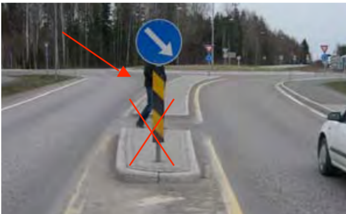
Figur 3.3.9—4 — Øymarkering som skjuler fotgjenger - her bør man bruke strørrelse US på skilt 404 og halv LS på 906.
