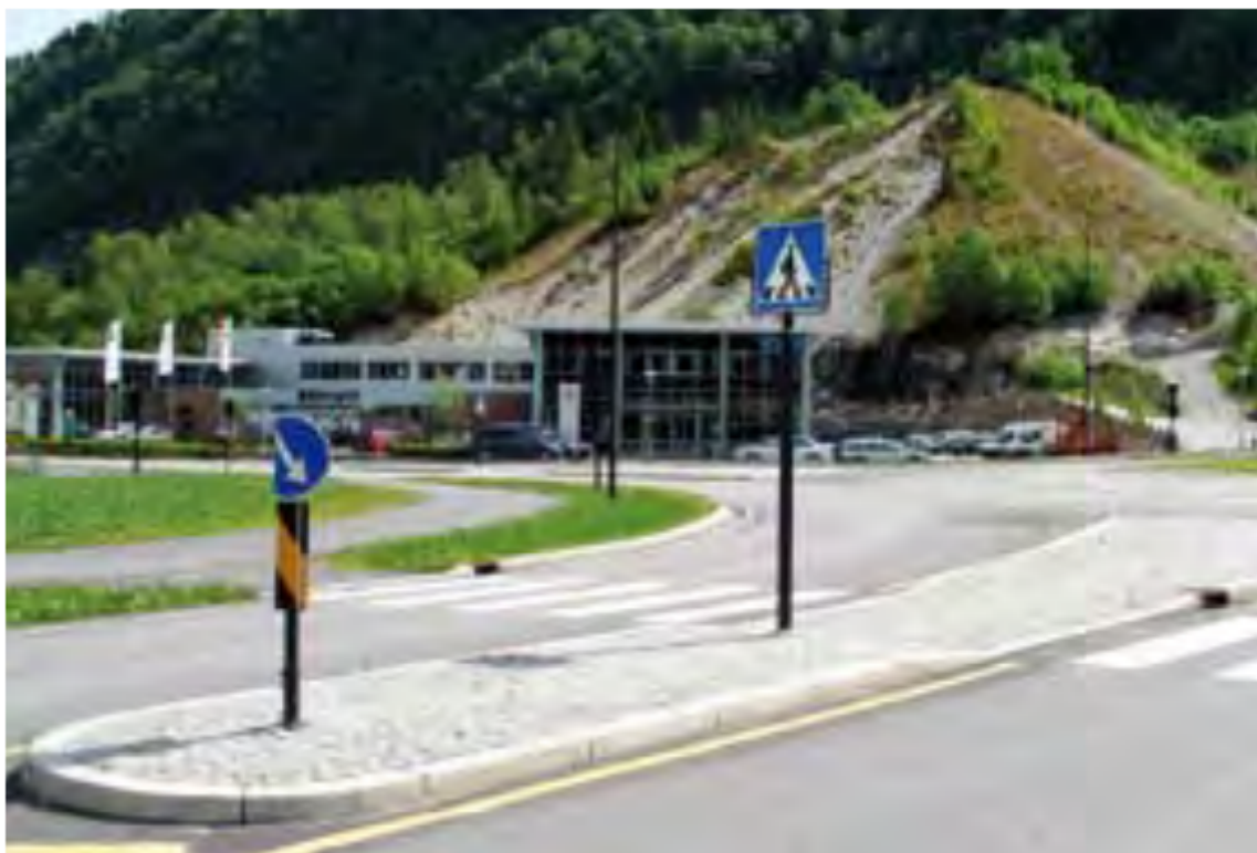
Figur 3.3.9—5 — Øymarkering og gangfeltskilt settes på hver sin stolpe når avstand fra øyspiss til gangfelt er >2m
