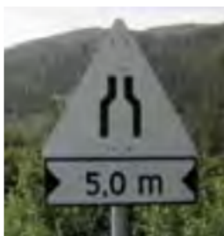
Figur 5—1 — Eksempler på behov for skiltfornying (fortsetter)
