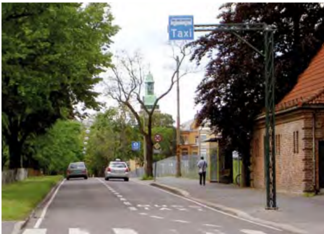
Figur 3.4—2 — Eksempel på kollektivfeltskilting med overhengende 508.2-skilt
