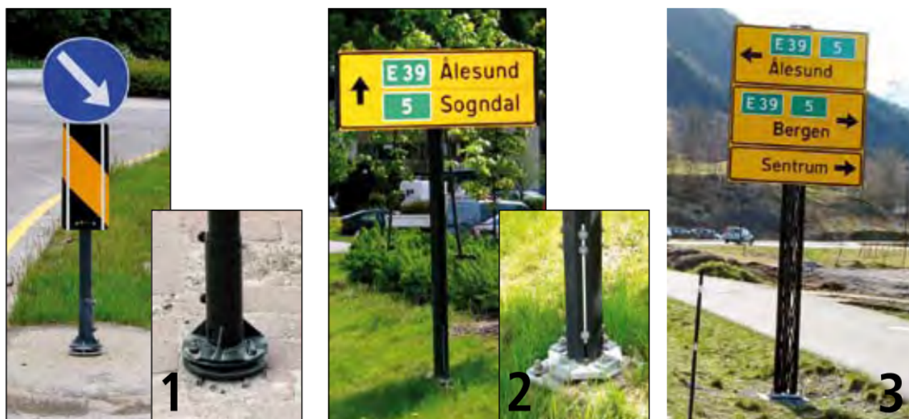
Figur 4.2.4—2 — Eksempler på stolper med avskjæringsledd (1 og 2) og ettergivende mast (3)
