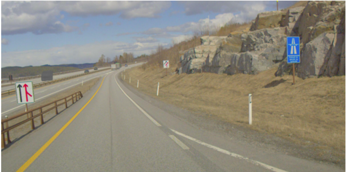
Figur 3.4—1 — Eksempel på innføring av motorveg og kjørefeltskilt
