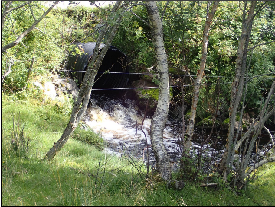
Foto 5.12. Kulvert under veien til Konsvika gravplass i Volaelva. Foto: Jon H. Magerøy.
