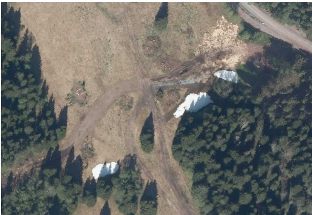
Figur 33. Flyfoto over sørlige deler av engene på Rønningen fra mai 2023 som viser kjørespor og skader på enga etter hogstmaskiner (fra venstre mot høyre). I tillegg vises kjørespor i forbindelse med vedlikehold av skiløypetraséen sør for engene og spor etter løypemaskiner (fra øverst til nederst). Foto fra norgebilder.no.
