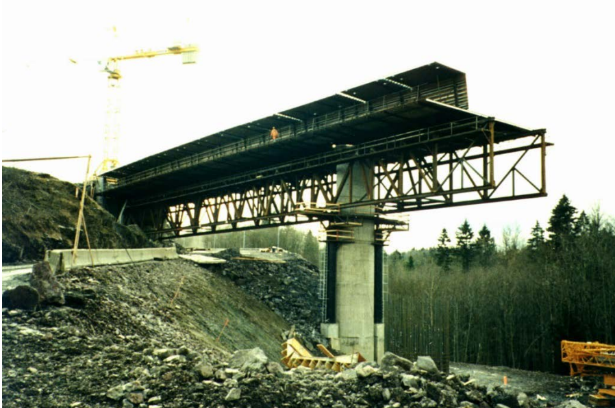
Figur 7 Engangsvogn for støp av bru (foto: Gaute Nordbotten)
