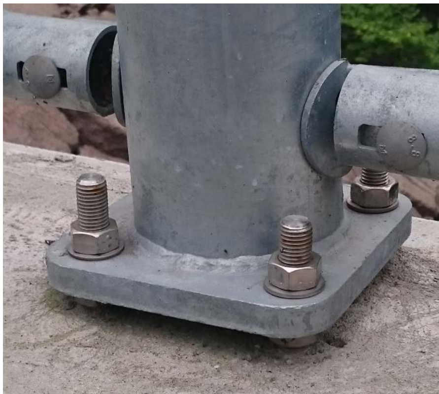
Figur 20 Rekkverksinnfesting (foto: Gaute Nordbotten)
