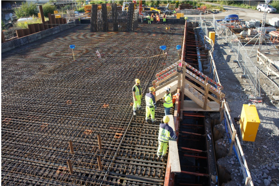
Figur 19 Spuntgrop med separat forskaling innenfor (foto: Morten Jordbakke)
