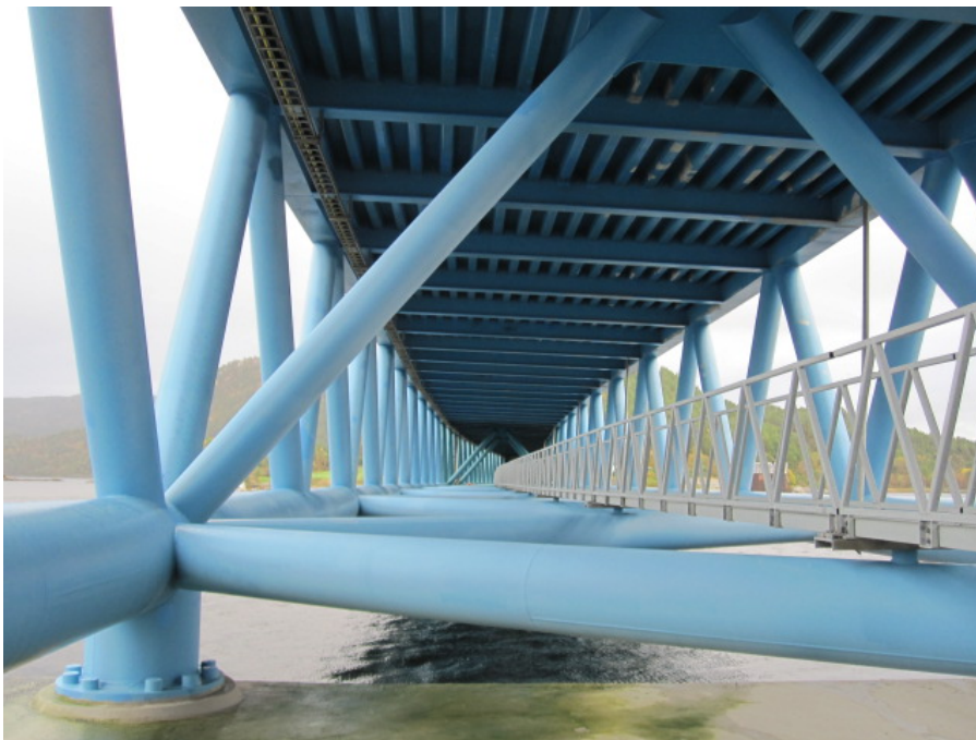
Figur 10 Mye malingsskader i underkant brudekke på Bergsøysundbrua (foto: Gaute Nordbotten)
