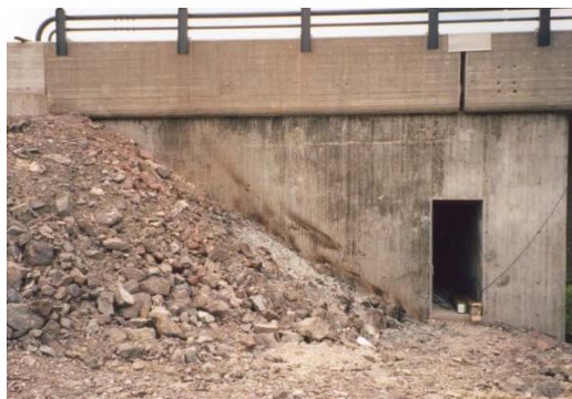
Figur 12 Rom under fuge (fra håndbok N400 Bruprosjektering, foto: Gaute Nordbotten)
