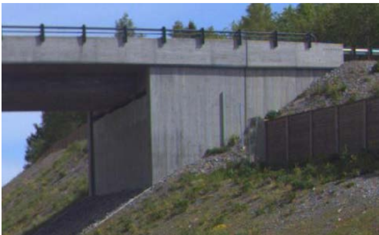
Figur 14 Fugefri løsning med overgang til støttemur (foto fra Norsk vegdatabank)
