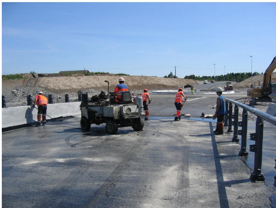
Figur 25 Legging av fuktisolering type A3-4 (foto: Gaute Nordbotten)
