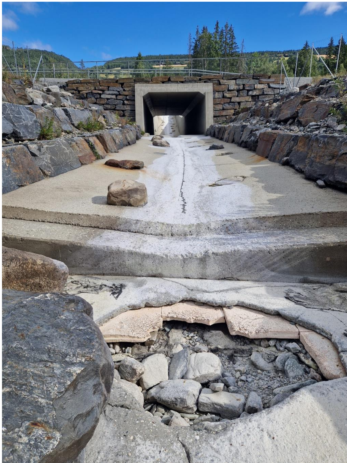
Figur 8-3. Dagens kulvert under E6 sommeren 2026. Multiconsult / Rune Bratlie
