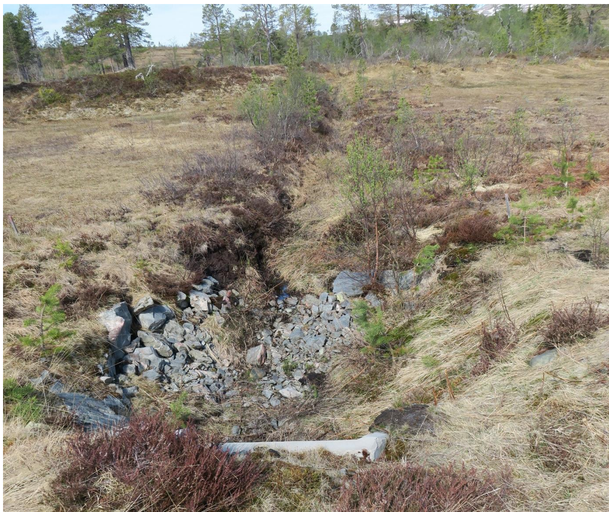
Figur 18. Ei skogsgrøft ledes gjennom kulvert F. Etter en eventuell restaurering av denne grøfta antas det at kulverten sjelden vil være vannførende.
