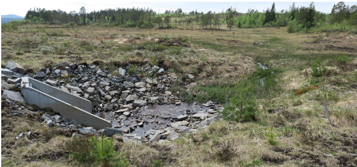
Figur 14. oppstrøms kulvert D føres vannet gjennom en forsenkning i terrenget.
