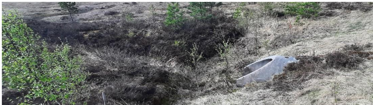
Figur 19. Utløpet fra kulvert F ledes til ei ca. 60m lang skogsgrøft som fører til en liten, naturlig bekk i myra.
