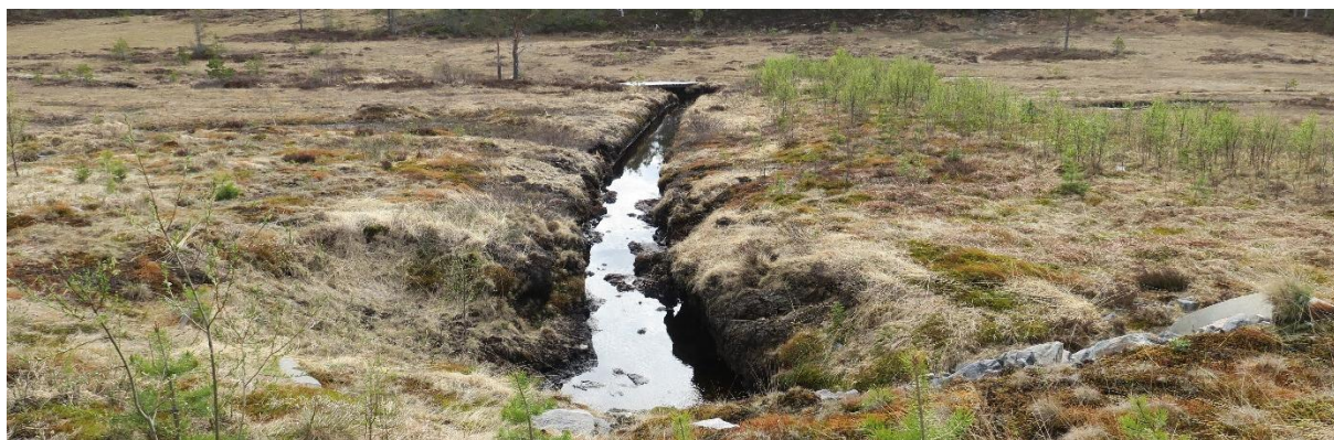
Figur 10. Utløpet av kulvert B kan sees til høyre i bildet. Vannet ledes gjennom myra til en bekk via en større kanal. Massene som ble gravd opp fra myra ses som en gjengroende voll til høyre for kanalen.
