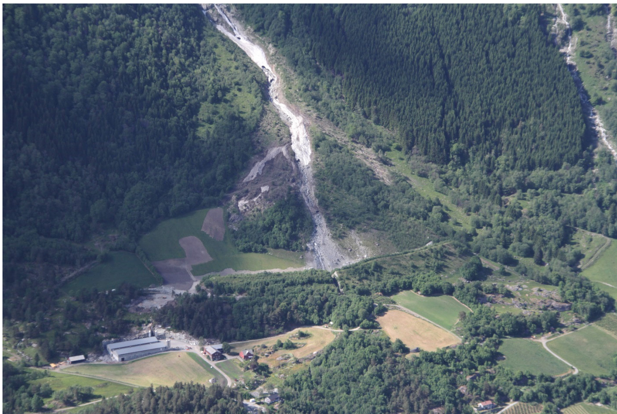
Foto 4: 10 m høy og 200 m lang fangvoll som sikring for gårdsbebyggelsen nedenfor og for noen boliger. Nordlig skredutløp er ikke sikret av fangvullen.
