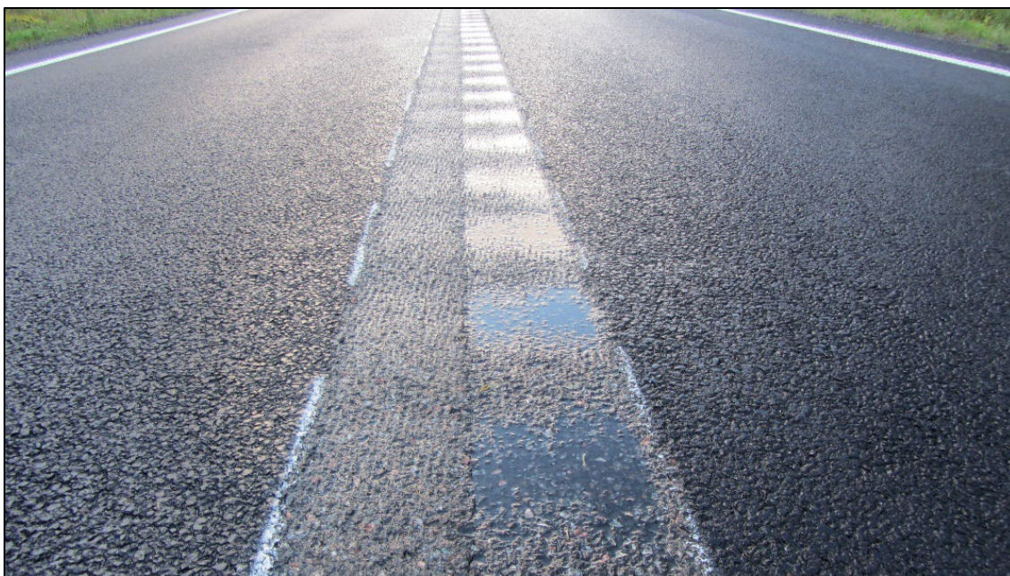
Figur 9-4: Bilde av 55 centimeter bredt fresespor som er godt gjennomført. Det er tydelig fra figuren at sinuskurvene fra de to kuttene går omtrent i motfase, og at høyre side er litt bredere enn venstre side (Richard Skjæret, ukjent dato).
