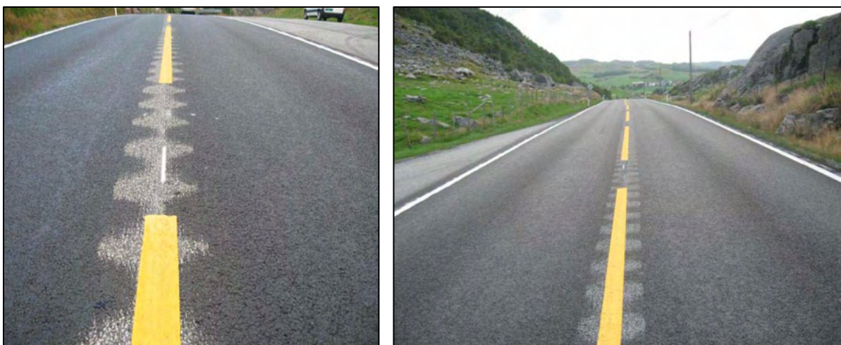
Figur 9-5: Problem med ett kutt på takfall og utilstrekkelig tyngde på utstyret (Haglund & Skjæret, 2010, ss. 17-18).
