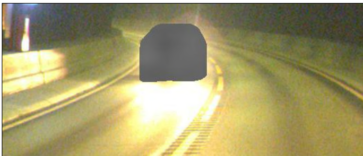
Figur 15-6: Rv. 70 Oppdølsstrandtunnelen, omtrent fra kurven ved smelteverket i Sunndalsøra, har fått frest FMO i ett kutt med ensidig fall (Vegbilder, RV70 HP2 M1371 F1, september 2016).
