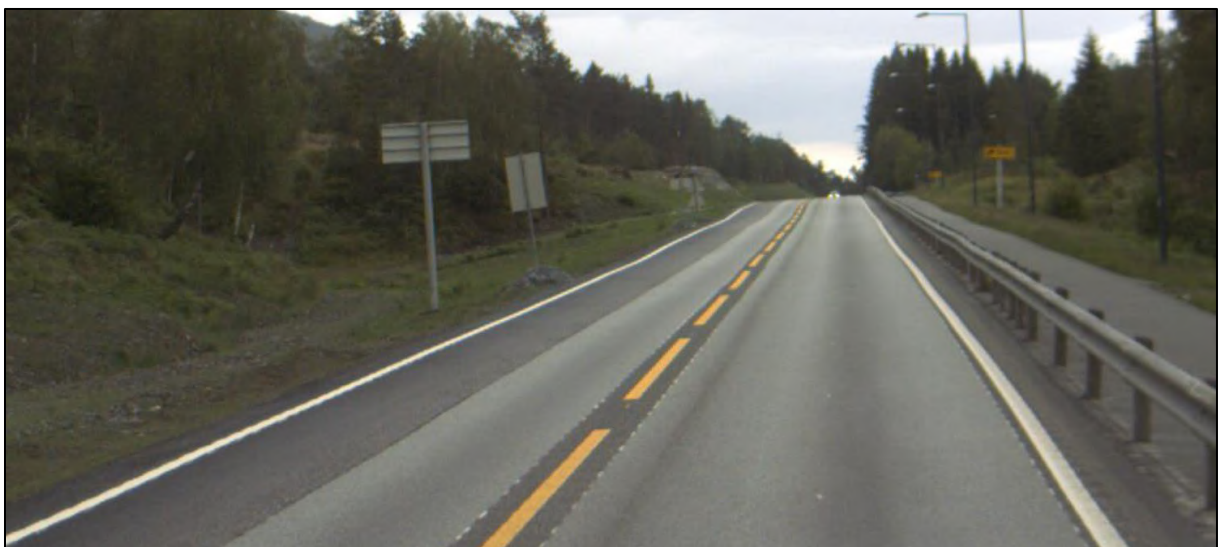
Figur 15-4: E39 like nord for Førlandskrysset på Stord i Vestland fylke. Sett mot nord. Øverst: Vegbilde tatt år 2018 i forkant av breddeutvidelse. Nederst: Vegbilde tatt år 2020, i etterkant av breddeutvidelse og etablering av ensidig frest FMO til venstre for asfaltskjøten. Vegsystemreferanser er henholdsvis EV39 HP8 M5166 F1 og EV39 S85D1 M59 F1.
