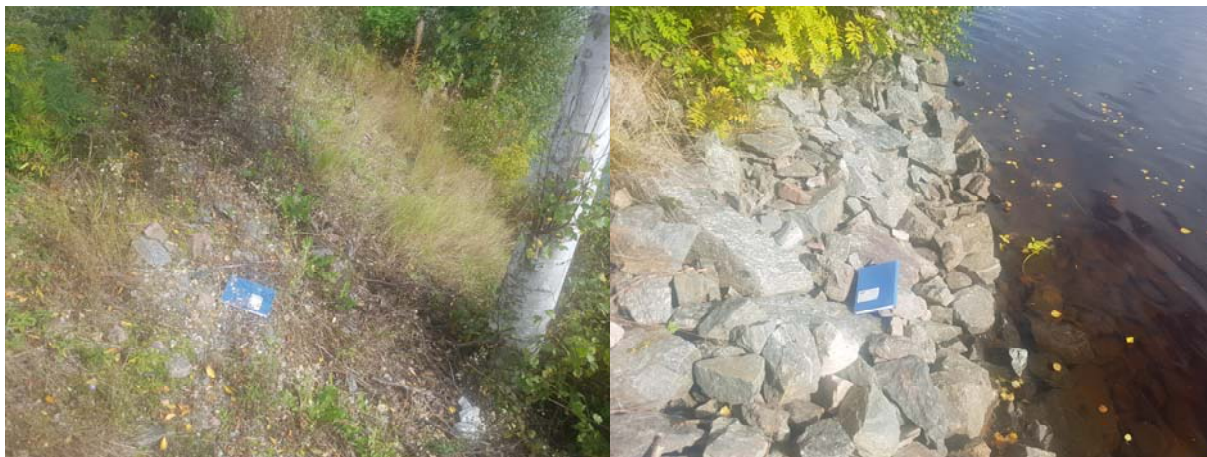
Figur 6: Erosjonssikring i to nivåer langs flomverket (Boken på bildet er 21,5x17cm) (Bilde: Multiconsult).
