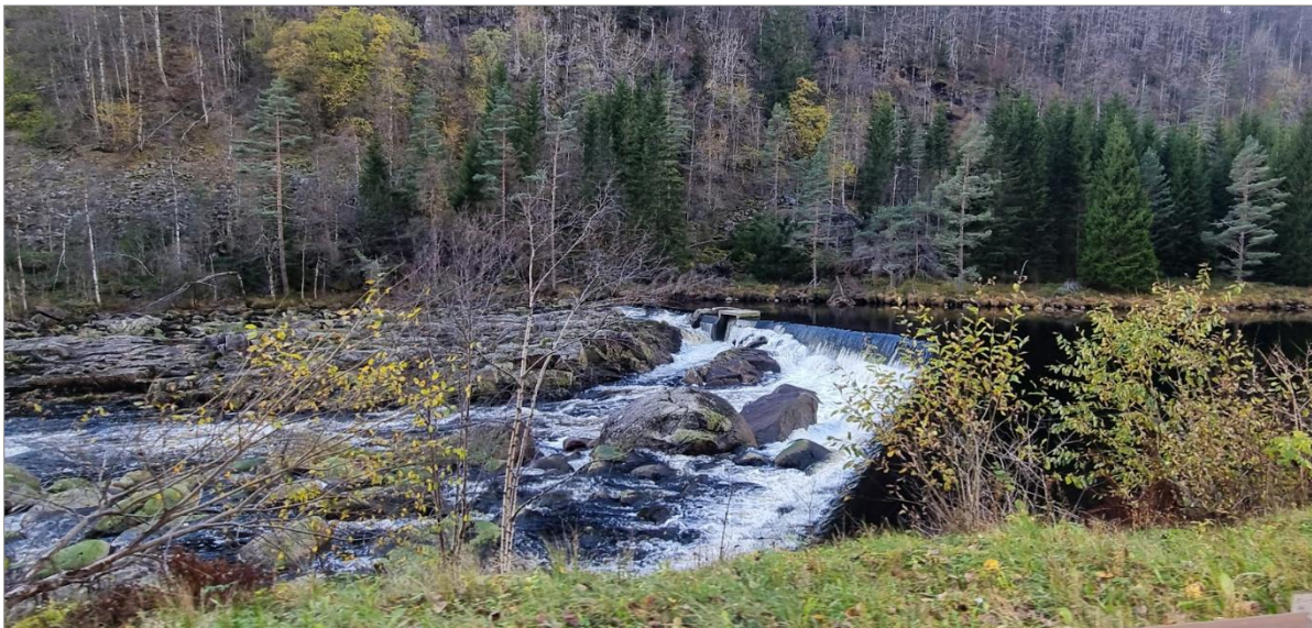
Figur 10.5 Vannføringsavhengig vandringshinder (markert i Figur 10.1 ) et stykke oppstrøms fra st.27 (Sinland). Terskelen fungerer trolig som et vandringshinder ved lave vannføringer, men kan trolig fint passeres av laks og ørret ved høyere vannføringer. Foto tatt 16. oktober 2025
