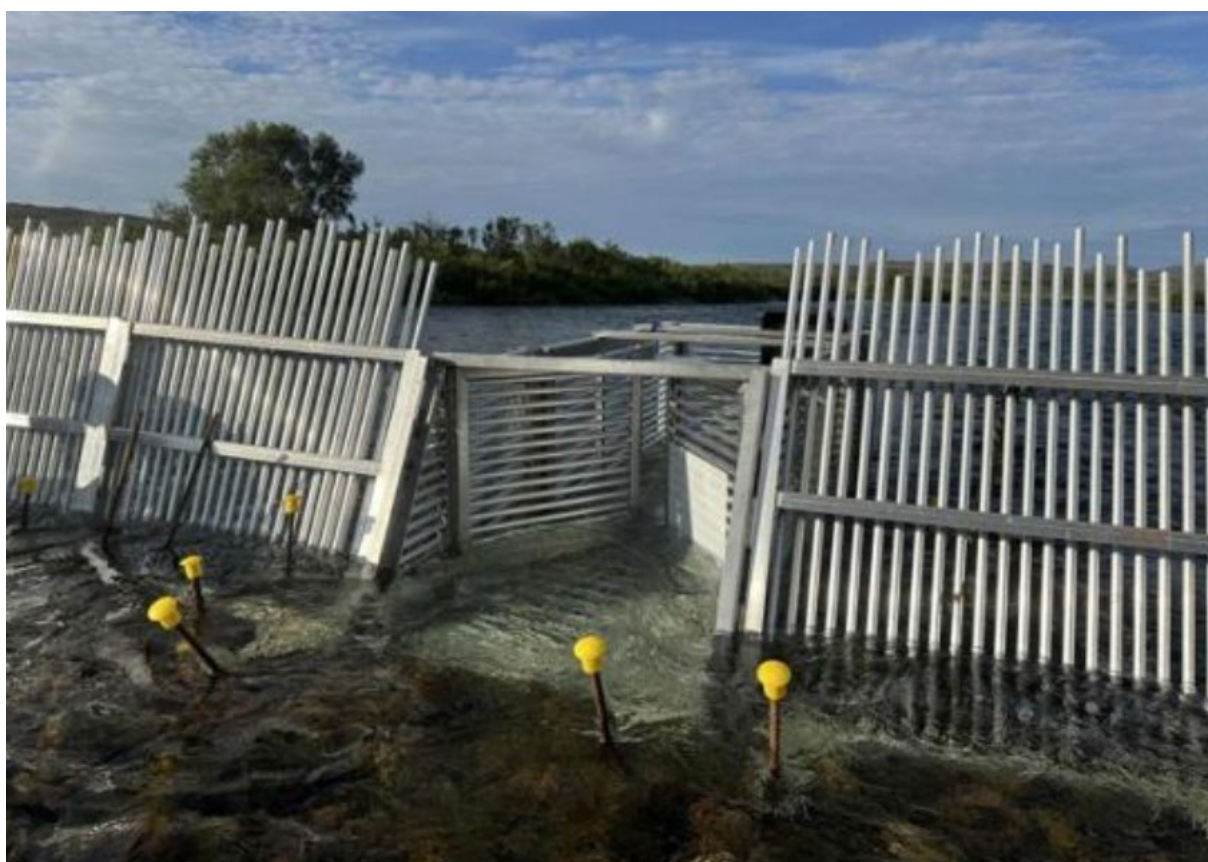
Figur 6.4. Nedvandringssluse integrert i ledegjerdet i Kongsfjordelva. Foto: Håvard Vistnes
