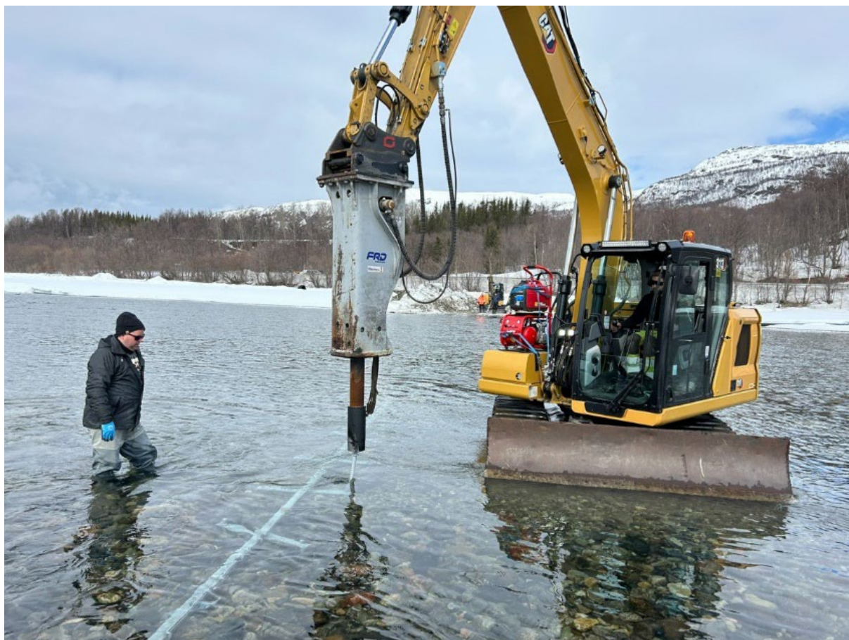
Figur 8.4. Forankring av bunnskinne ved hjelp av gravemaskin med pigghammer
