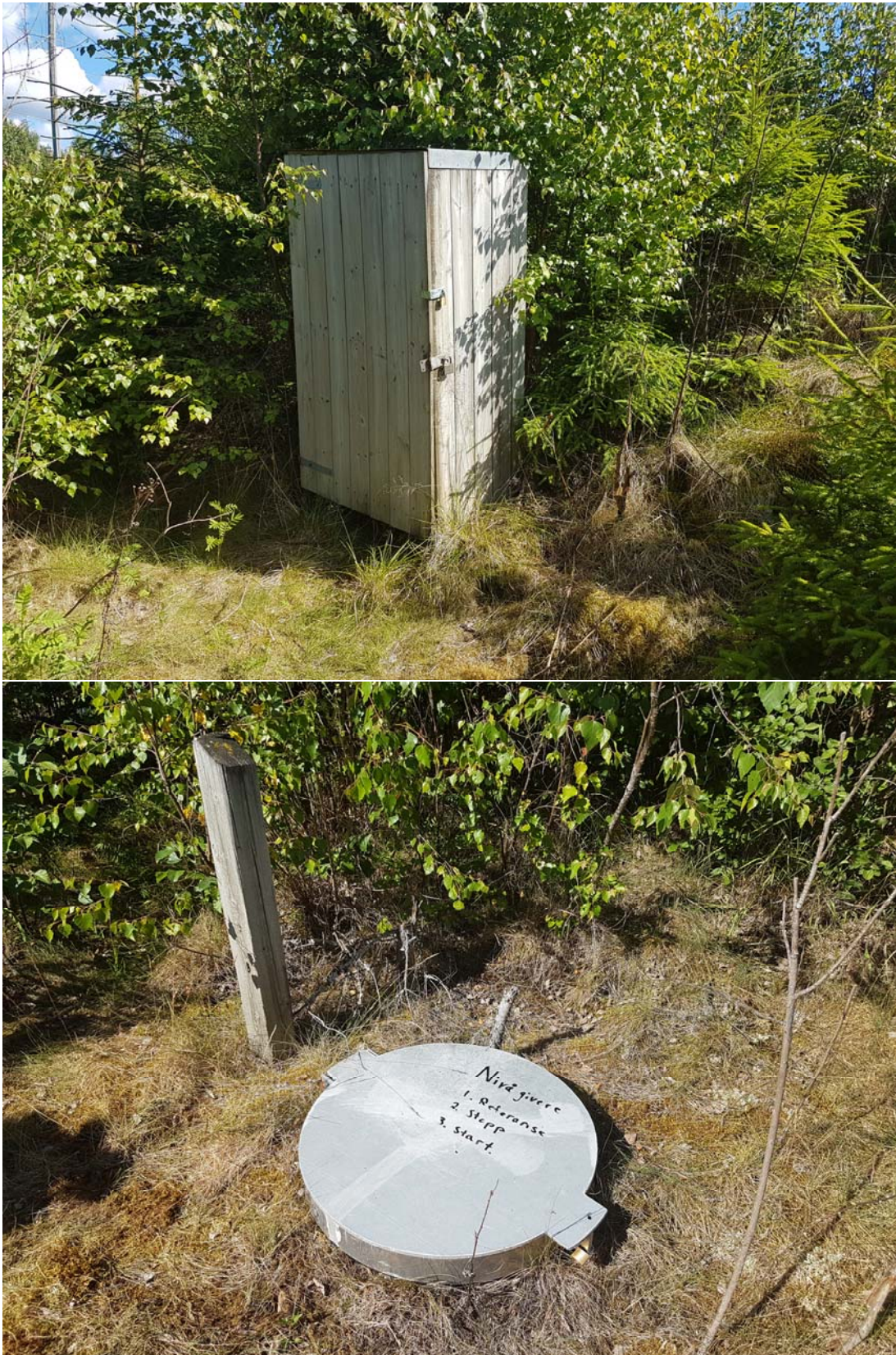
Figur 17- Pumpestasjon (Bilde: Multiconsult)
