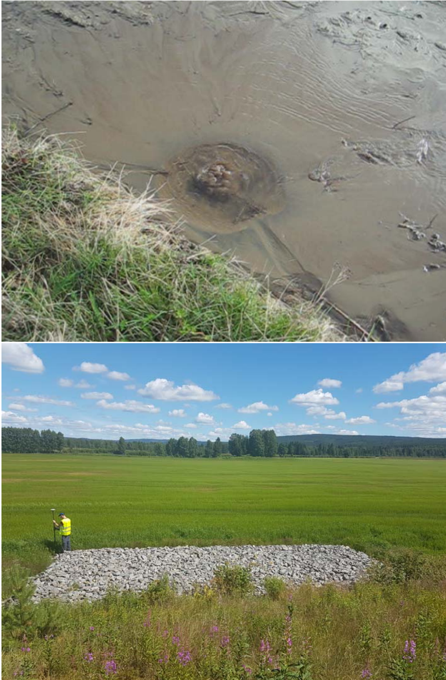
Figur 15- Sandkoking (bilde: klippet ut fra video fra Grue kommune) og reparasjon (Bilde: Multiconsult)
