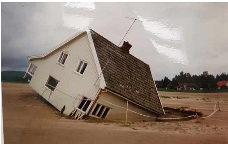
Figur 4 – Skader på arealet bak flomverket i 1995 (Bilde fra NVE arkivet)
