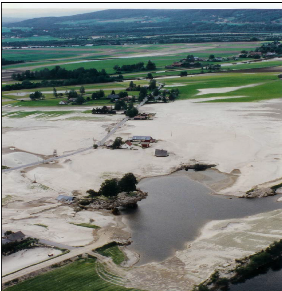
Figur 3 – Oversvømmelse av arealet bak flomverket i 1995 (Bilde fra NVE arkivet)
