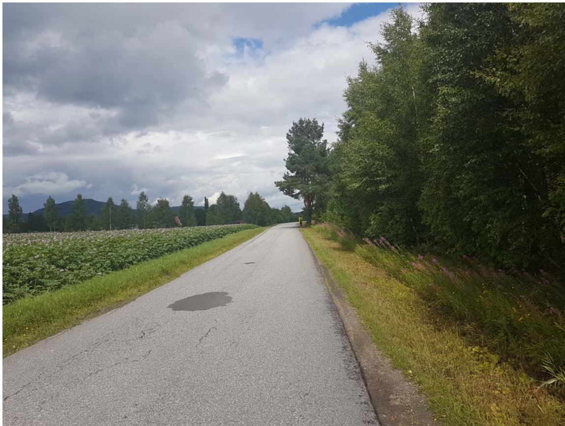
Figur 9 – Flomverket med asfaltvei på toppen, treet midt i bildet ligger på skillet mellom Lauta og Storenga (Bilde Multiconsult)
