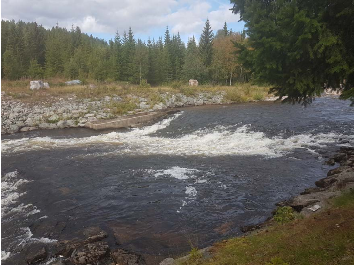
Figur 10- Terskel lengst oppstrøms (Bilde: Multiconsult)
