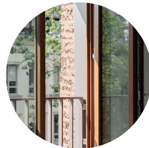
Fasade i stampede jordelementer med vindusinnsetning og innvendig ferdig lys leirepuss. Quatre cheminées, Dechelette Architectes. Foto: Salem Mostefaoui
