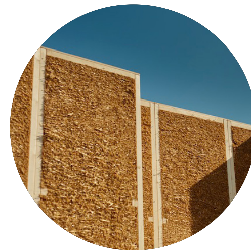
EcoCocons tre-halm-veggelementer skrues enkelt sammen og legger til rette for demonterbar design
