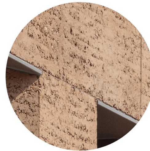
Stampet jord med ståldetaljer. Fra Quatre cheminées, Dechelette Architectes. Foto: Salem Mostefaoui
