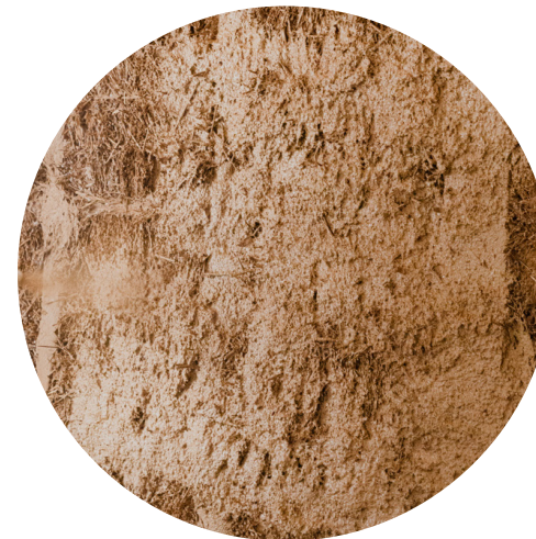
Leirepuss blåses på innvendige halmelementvegger. Overpuss og tekstur for hånd, med mulighet for personlig uttrykk. Foto: Luc Borho, for Dechelette Architectes
