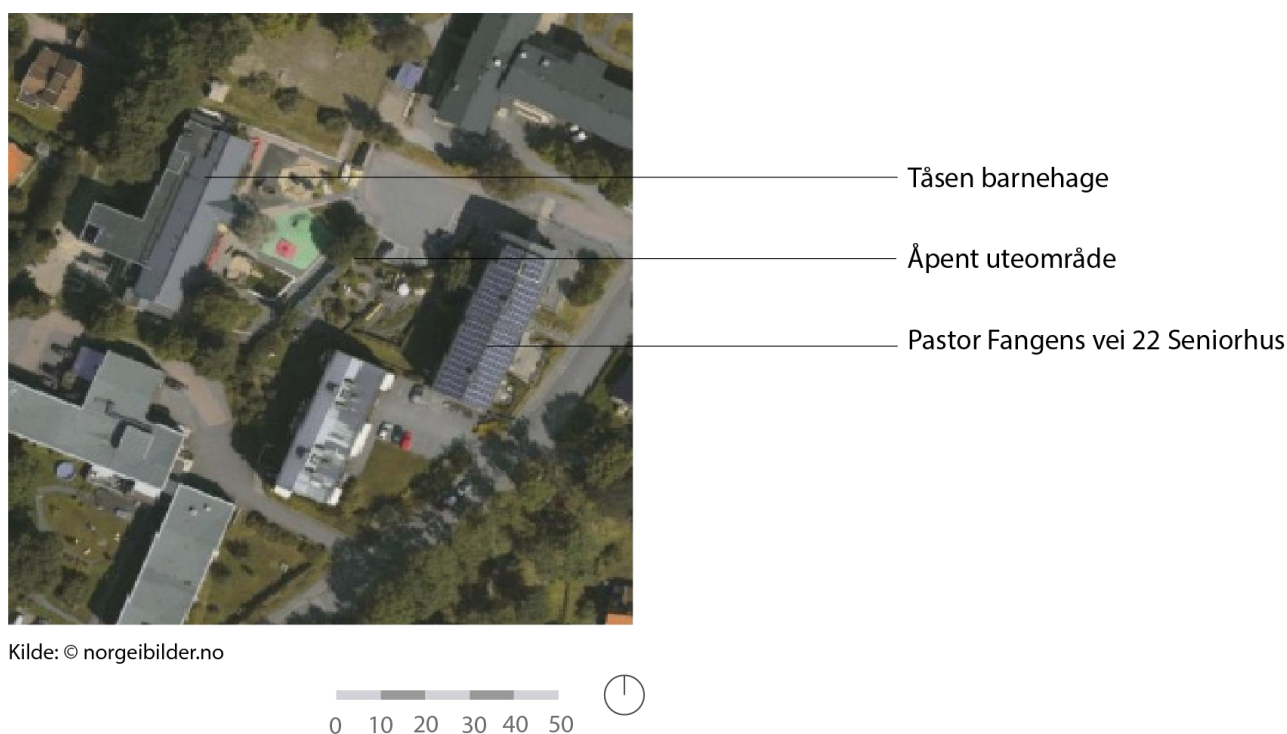
Figur 4.6: Tåsen barnehage til venstre i bilde og Pastor Fangens vei 22 Seniorhus til høyre (mot øst) i bildet, med åpent uteområde mellom byggene. (Kilde: © norgeibilder.no).
