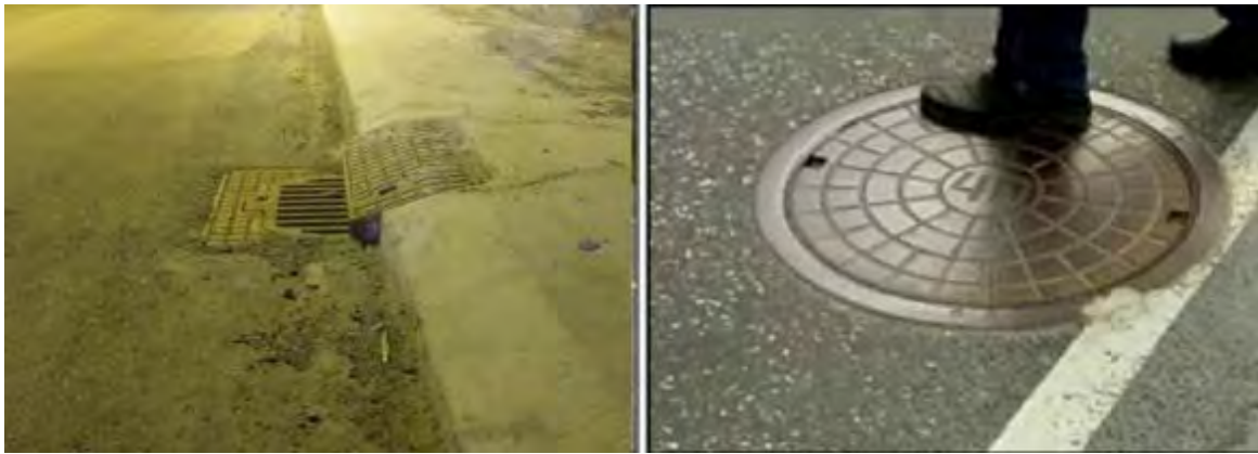
Figur 4-3 En bør stoppe opp og kontrollere sluk og kumlokk som ligger utsatt til, og registrere dem slik at tiltak kan utføres før snøen kommer (Foto: Statens vegvesen)
