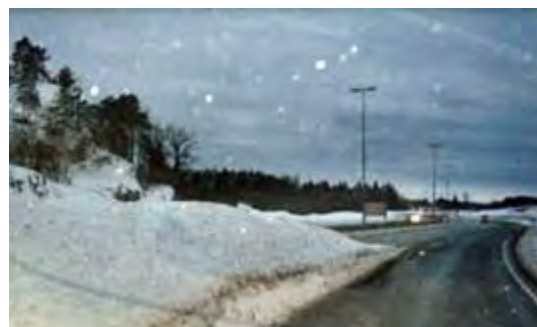
Figur 2-47 Ikke tilstrekkelig sikt fra påkjøringsrampe til motorveg (Foto: Arild Nærum)
