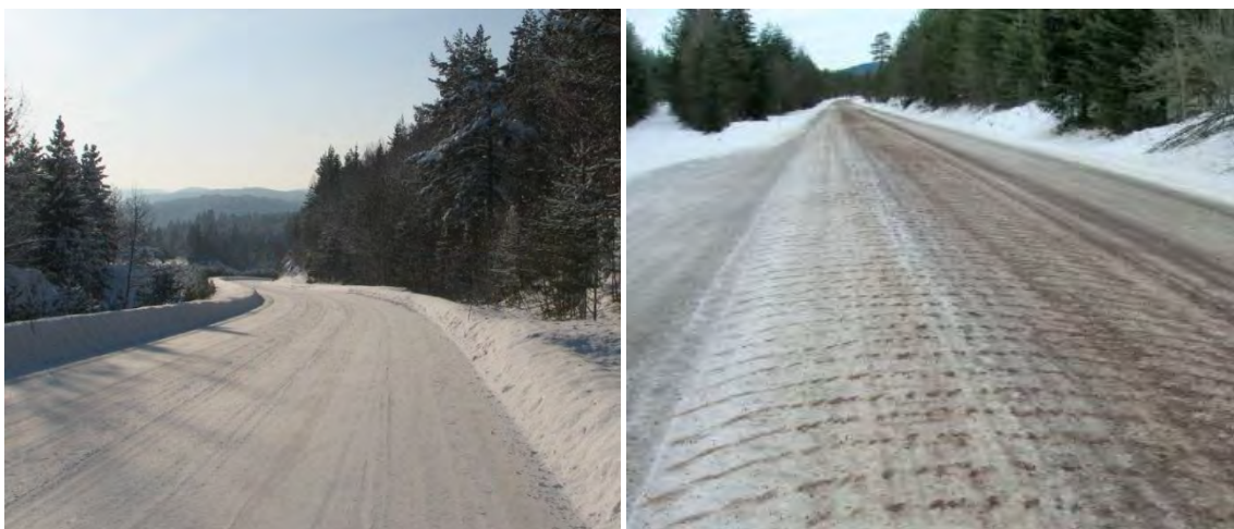
Figur 1-8 For vinterdriftsklasse DkD og DkE kan vegen ha snø- og isdekke. (Foto: Statens vegvesen)
