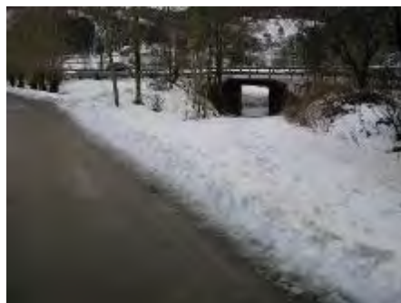
Figur 2-19 Forbindelsen mellom fylkesveg og kommunal veg (GS-veg) er ikke ryddet (foto: Arild Nærum)
