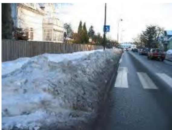
Figur 2-55 Manglende sikt og åpning i brøytekanten (Foto: Kjell Stangborli)
