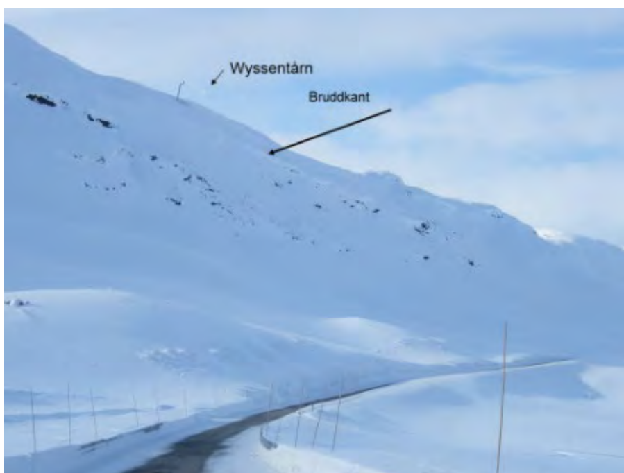
Figur 4-92 Wyssentårn brukt til nedsprenkning av snøskred på fv. 53 Årdal-Tyin. Tårnet har flere sprengladninger som kan avfyres trådløst etter behov (Foto: Statens vegvesen)
