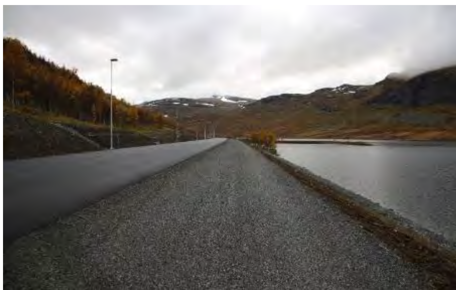
Figur 4-96 Opparbeidet fresegate på fylling på E16 Filefjell (Foto: Statens vegvesen)
