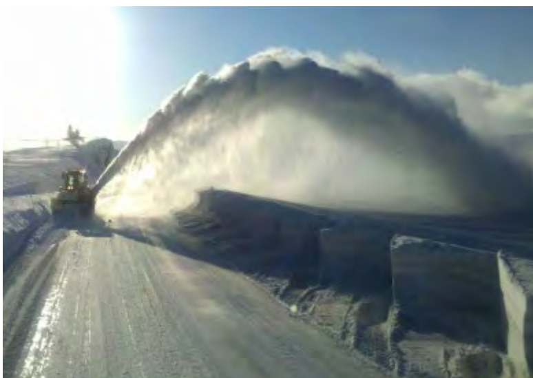
Figur 4-76 Fresing av brøytekanter, E6 Gratangsfjellet 2013 (Foto: Statens vegvesen)
