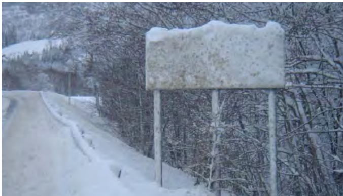
Figur 4-80 Nedsprutet trafikkskilt. Brøytefart over 40 km/t øker problemet med snø- og slapsesprut som dekker til skilt, og skader skilt, kantstolper, brøytestikk og andre installasjoner langs vegen (Foto: SINTEF)
