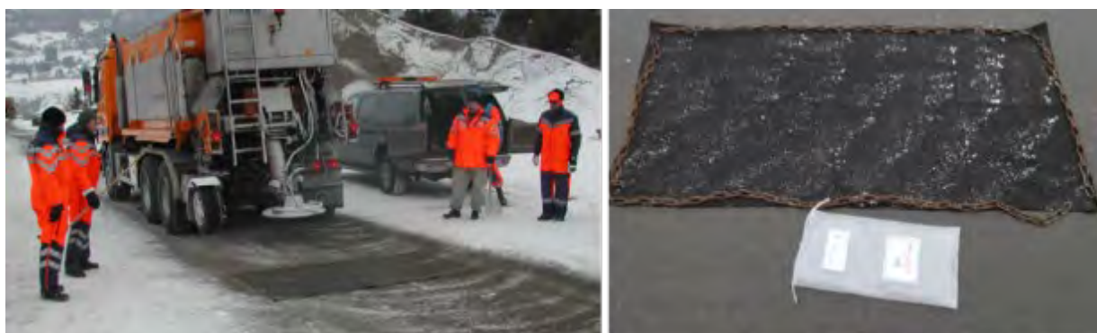
Figur 6-20: Kontroll av utstrødd mengde strømateriale med utlagte duker (Foto: Torgeir Vaa og Stein Hoseth)
