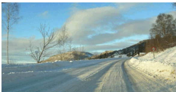
Figur 2-11 Sporete vegbane (Foto: Statens vegvesen)
