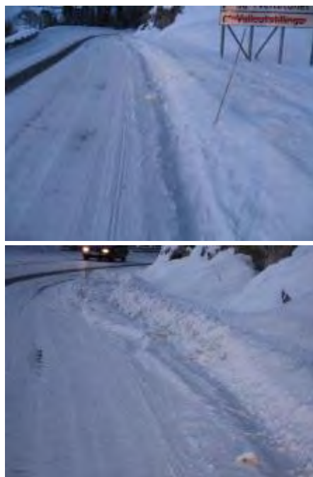
Figur 2-20 Feilplassert stikk («Sparklet vegskulder») og resultat (Begge foto: Pål A. Haugen)
