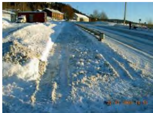
Figur 2-61 Brøyting av kjørebanen etter GS-vegen (Foto: Statens vegvesen)
