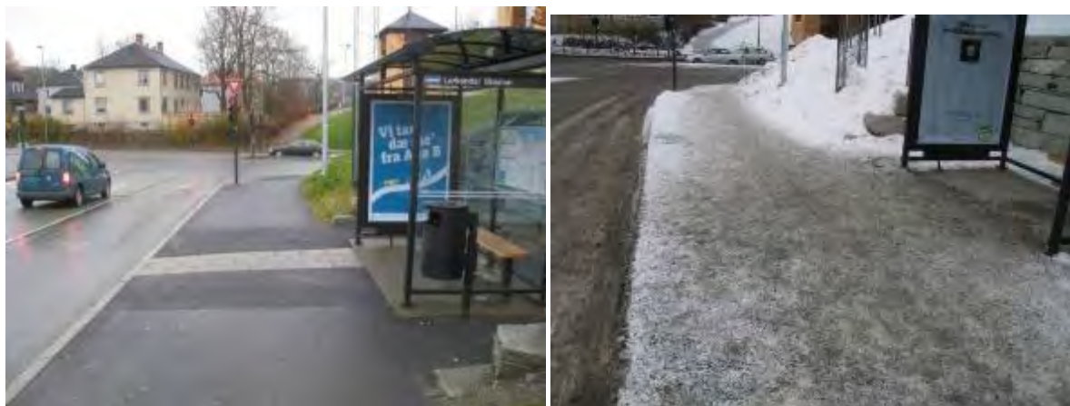
Figur 9-27 Taktile heller sommer og vinter (Foto: Statens vegvesen)
