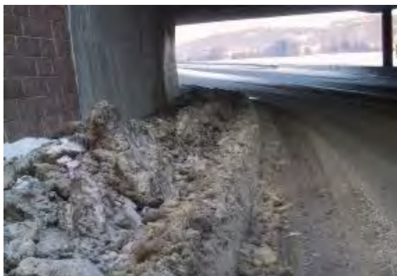
Figur 2-60 Ubrøytet fortau i undergang (Foto: Statens vegvesen)
