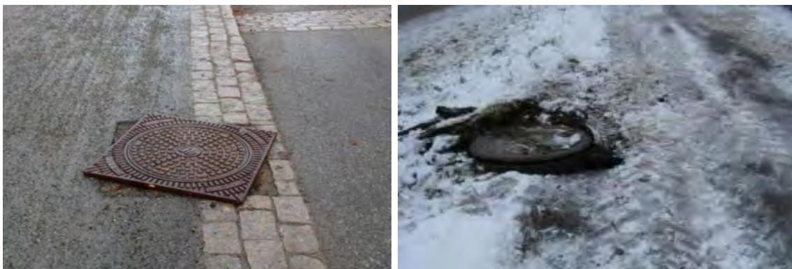
Figur 4-4 Fare for hekting: Kumlokkramme ute av stilling (t.v.), kum med overhøyde (t.h.). (Foto: Øystein Larsen)
