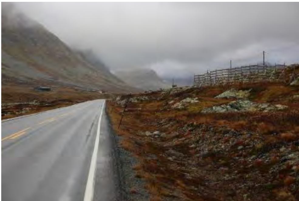
Figur 4-94 Eksempel på snøskjerm (Foto: Statens vegvesen)
