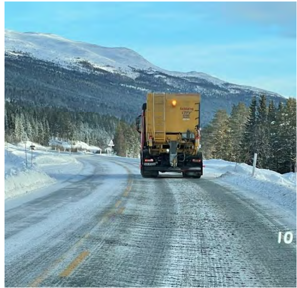
Figur 5-6 Fastsand på hardt snø- og isdekke, \mu=0,30-0,50 (Foto: Sigurd Stave Maskin)
