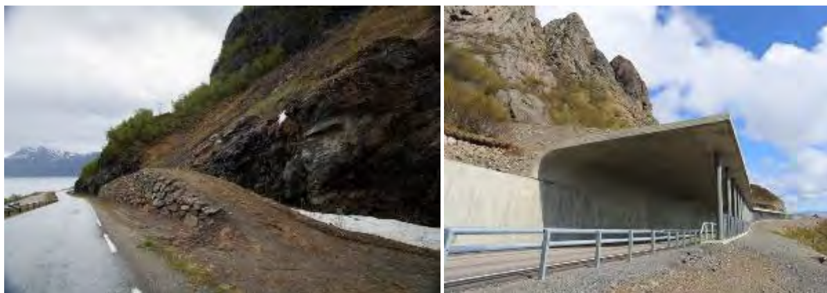
Figur 9-25 Eksempel på skredsikringsvoll og skredoverbygg (Foto: Statens vegvesen)
