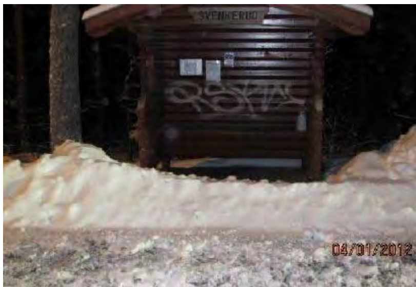
Figur 4-68 Mangelfull rydding foran leskur (Foto: Statens vegvesen)
