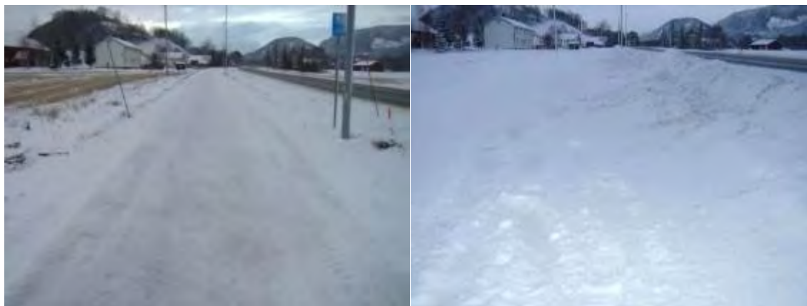
Figur 4-60 Eksempler på godt resultat (til venstre) og dårlig resultat (til høyre) etter brøyting av både hovedveg og g/s-veg (Foto: ukjent)
