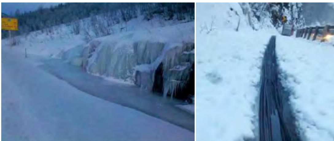
Figur 9-19 Is i grøfter kan tines med slanger med varmeledende væske fra aggregat (Foto: Mesta)
