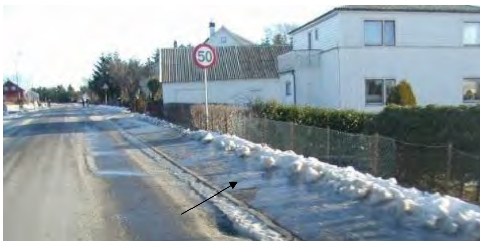
Figur 4-63 Eksempel på uheldig utførelse av brøyting av fortau (Foto: ukjent)
