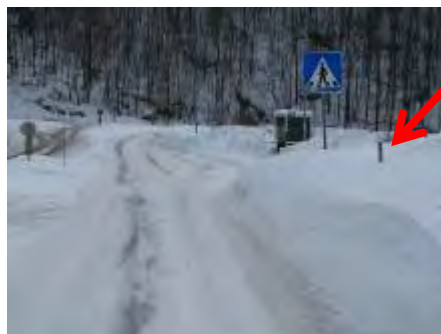
Figur 2-22 Manglende siktrydding mot krysningspunkt på grunn av koblingsskap i siktsonen (Foto: Arild Nærum)
