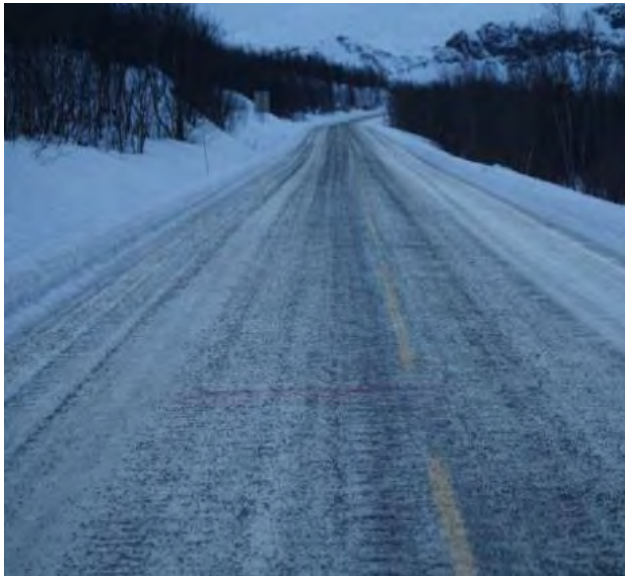
Figur 5-5 Friksjon på veg med isdekke strødd med sand, \mu=0,25-0,35 (Foto: Statens vegvesen)
