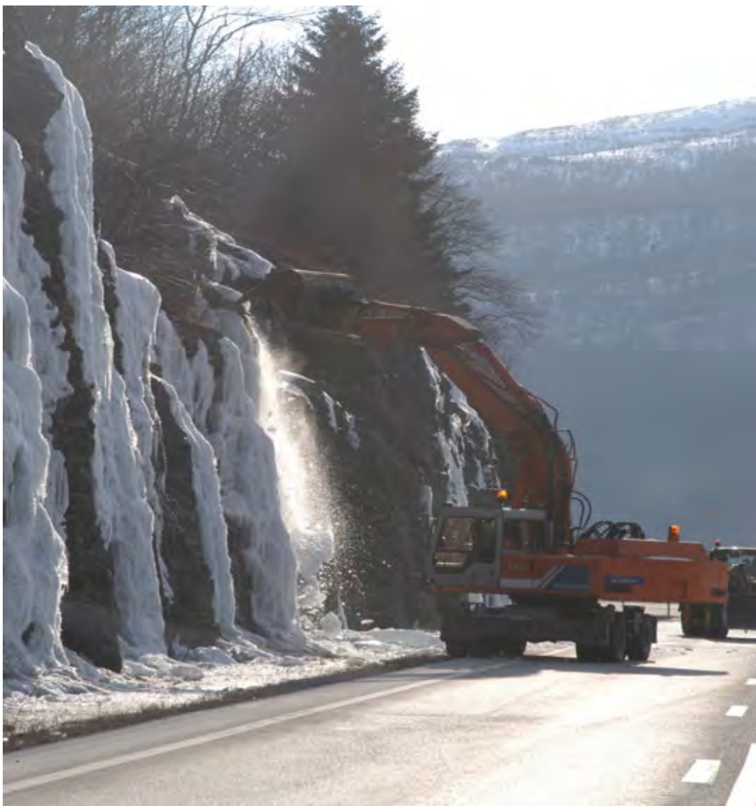
Figur 9-22 Rensk av is i skjæring (Foto: Statens vegvesen)
