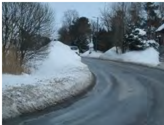
Figur 2-69 Manglende sikt rundt sving fra motsatt side av busslommen (Foto: Arild Nærum)
