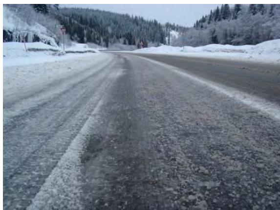
Figur 8-6 Dårlig brøyting vil gi dårlige kjøreforhold og høyt saltforbruk (Foto: Statens vegvesen)
