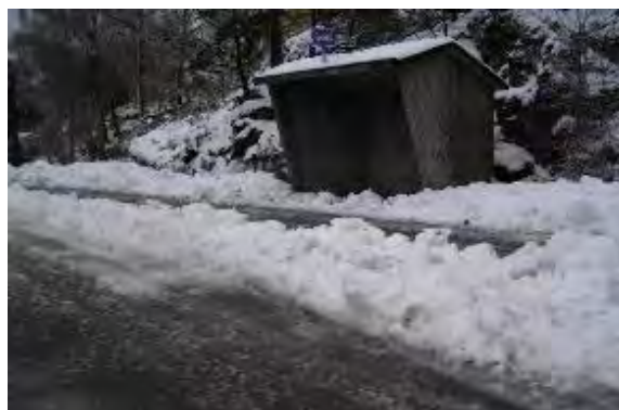
Figur 2-67 Snøranke mellom busslomme og fotgjengerareal samt foran leskur (Foto: Toralf Johansen)
