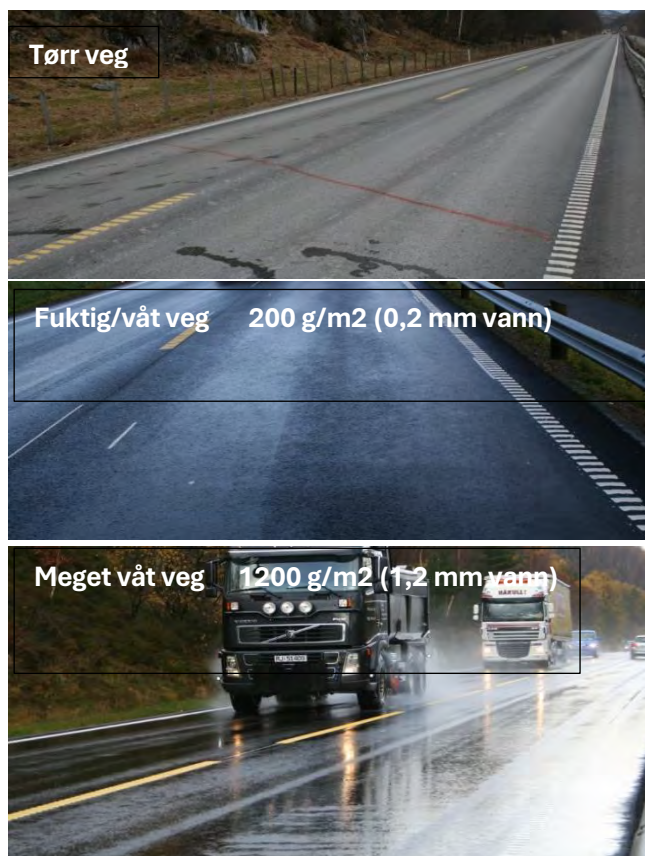
Figur 8-11 Ulike vannmengder på vegen (Foto: Statens vegvesen)
