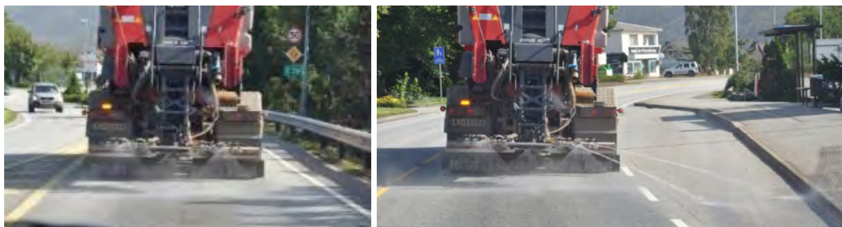
Figur 6-30: Varierende spredebredde styrt av GNSS-posisjon (Foto: Statens vegvesen)
