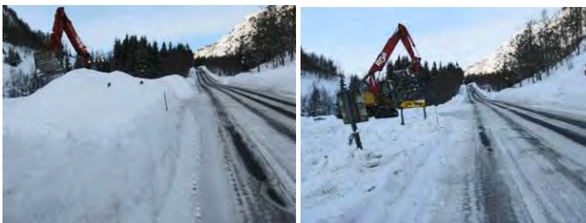
Figur 2-42 Siktrydding med hjulgående gravemaskin (Foto: Risa)
