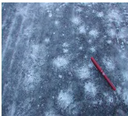
Figur 8-7 De-ising – Salting for å fjerne et is-/ eller snødekke (Foto: t.v. Torgeir Vaa, t.h. Håkon Aurlen)
