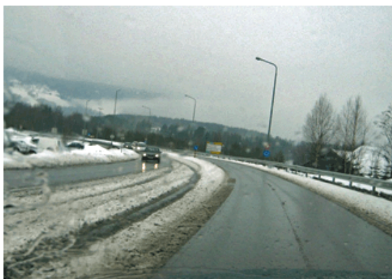
Figur 2-12 Dårlig brøytet forbikjøringsfelt (Foto: Statens vegvesen)
