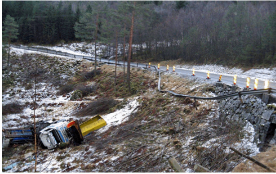
Figur 2-6 Uønsket hendelse med personskade (Foto: Statens Vegvesen)
