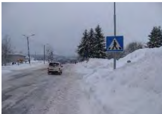
Figur 2-57 Manglende siktrydding til krysningspunkt over hovedveg (Foto: Pål H. Paulsen)
