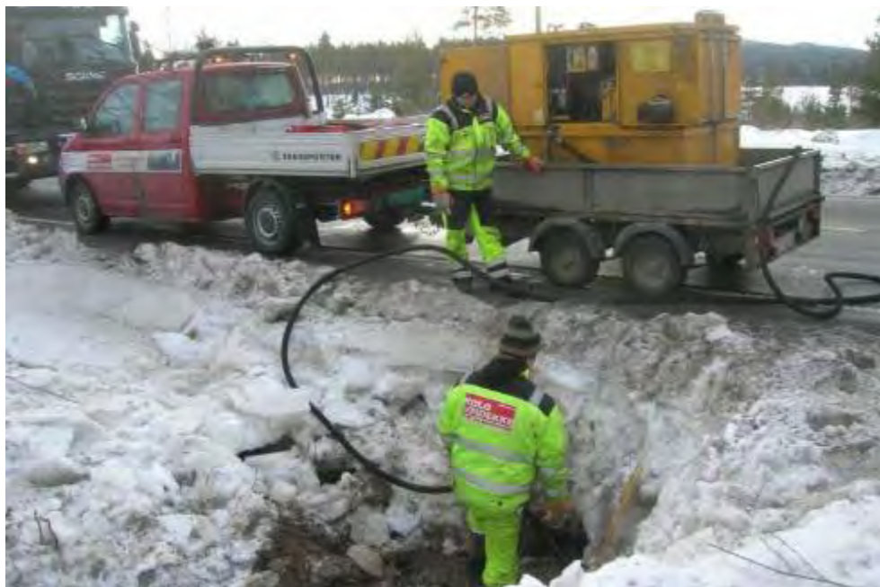
Figur 9-15 Tining av stikkrenne (Foto: Knut Magne Reitan)
