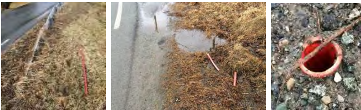
Figur 9-8 Rester av brøytestikk må samles inn etter vinteren (Foto: Statens vegvesen)
