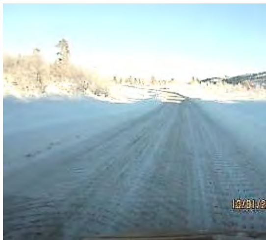
Figur 7-11 Varighet av fastsandmetoden på lavtrafikkert veg og under stabile værforhold. Bilde er tatt rett etter utlegging, friksjon 0,49 i gjennomsnitt (Foto: Statens vegvesen)
