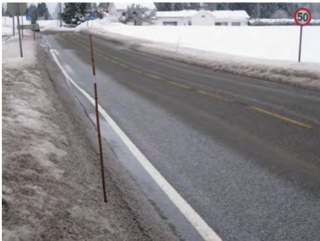
Figur 9-1 Riktig utsetting av brøytestikk er viktig for gjennomføring av vinterdrift (Foto: Statens vegvesen)
