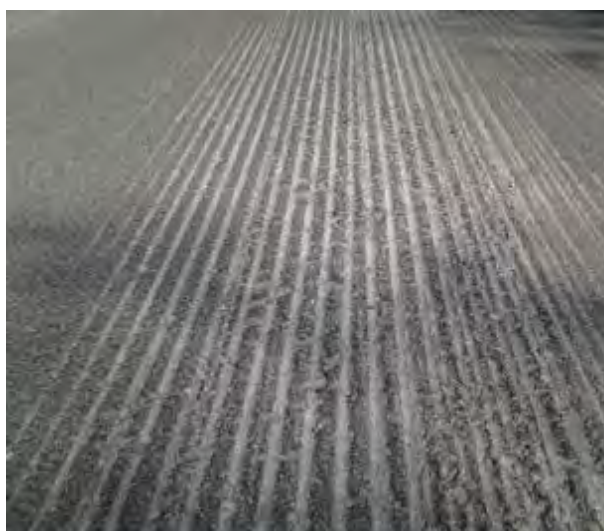
Figur 4-75 Dekkeskade grunnet uforsiktig høvling (Foto: Håkon Svendsen)
