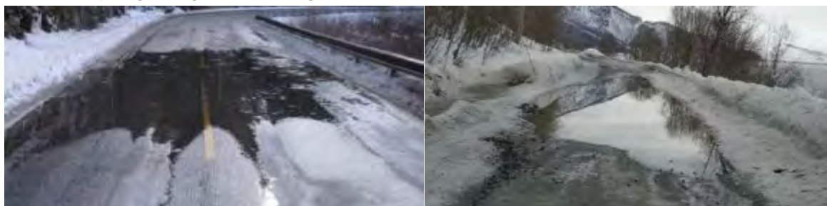
Figur 9-14 Snøkanter som hindrer avrenning (Foto: Statens vegvesen)
