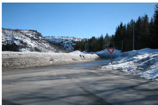
Figur 2-44 Manglende sikt i kryss (Foto: Risa)
