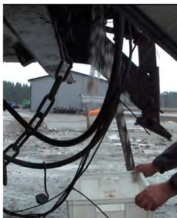
Figur 6-22: Kontroll/kalibrering av spreder med oppsamling og veiing (Foto: Statens vegvesen)
