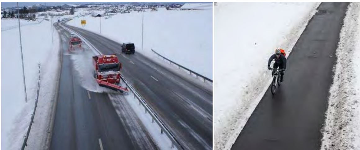
Figur 1-7 Vinterdriftsklasse DkA og GsA. Vegene brøytes og saltes slik at de blir bar kort tid etter snøfall. (Foto: Knut Opeide, Statens vegvesen og Risa AS)
