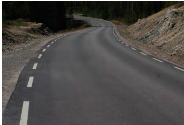
Figur 5-8 Friksjon på tørr, bar veg, \mu=0,90-1,00 (Foto: Statens vegvesen)
