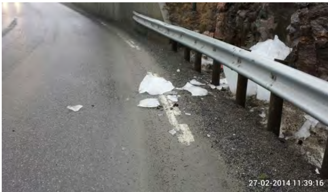
Figur 9-21 Is på vegen etter nedfall fra fjellskjæring (Foto: Rudi Thomassen)
