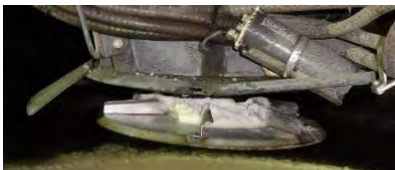
Figur 6-32: Spredetallerken må også sjekkes og evt. rengjøres (Foto: Statens vegvesen)
