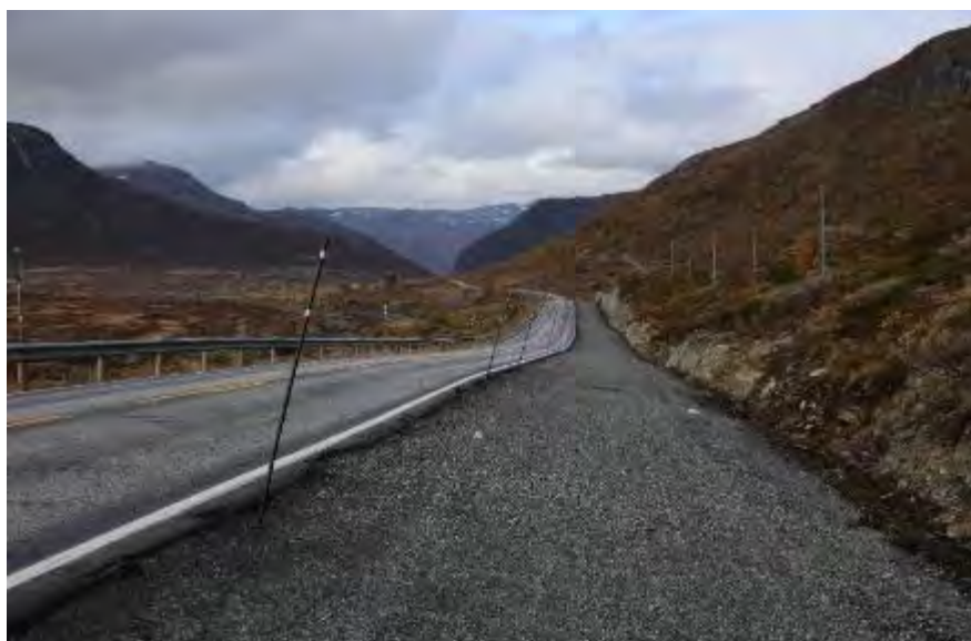
Figur 4-95 Opparbeidet fresegate i skjæring på rv. 52 Hemsedalsfjellet (Foto: Statens vegvesen)
