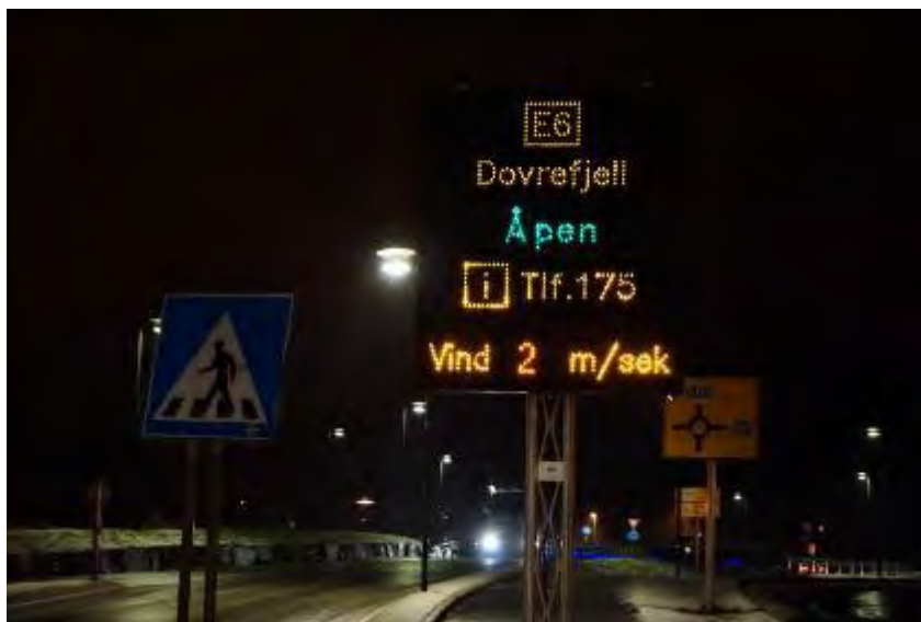
Figur 4-93 Vindvarslingsskilt plassert på E6 i Dombås før Dovrefjell (Foto: Statens vegvesen)
