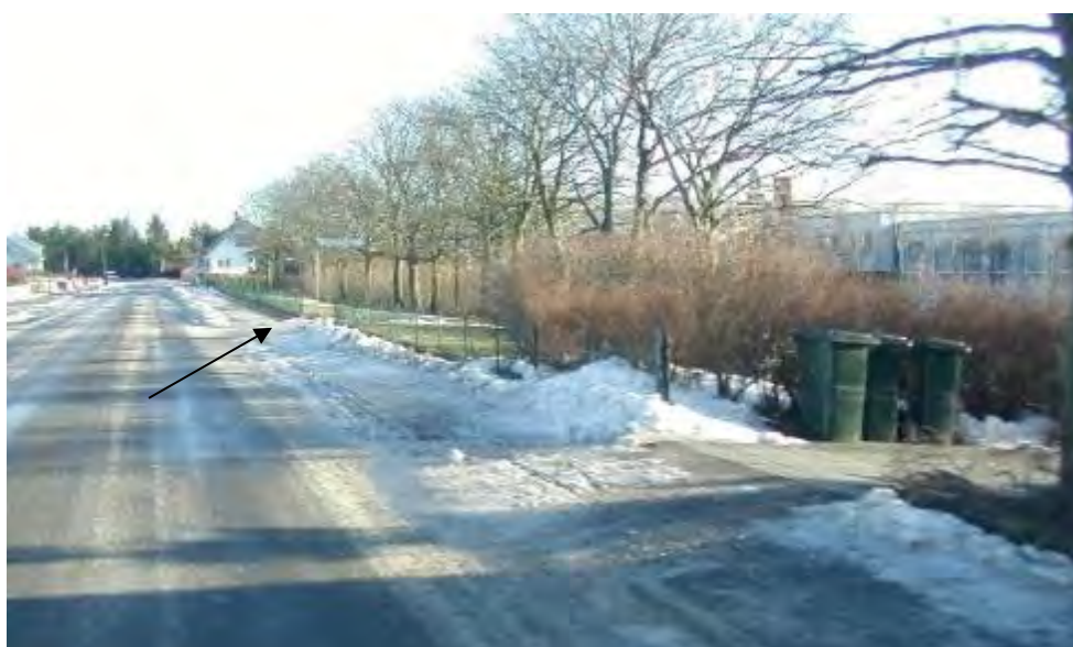
Figur 4-64 Lengst bort i bildet ser vi eksempel på riktig utførelse av brøyting av fortau (Foto: Ukjent)
