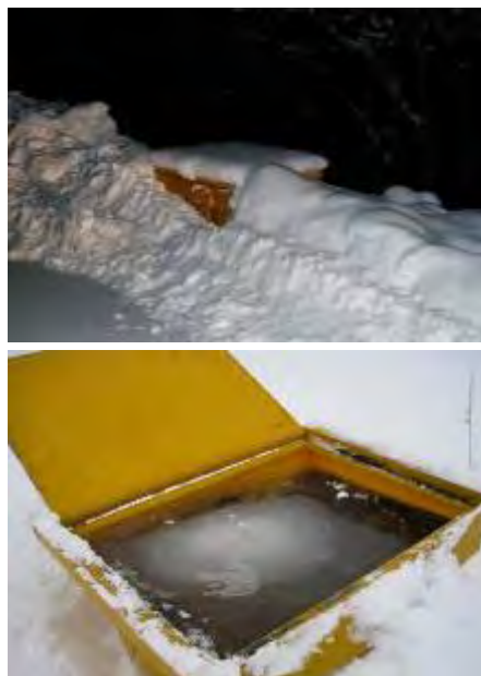
Figur 2-23 Utilgjengelig strøsandkasse og kasse der strøsand er utilgjengelig (Begge foto: Statens vegvesen)
