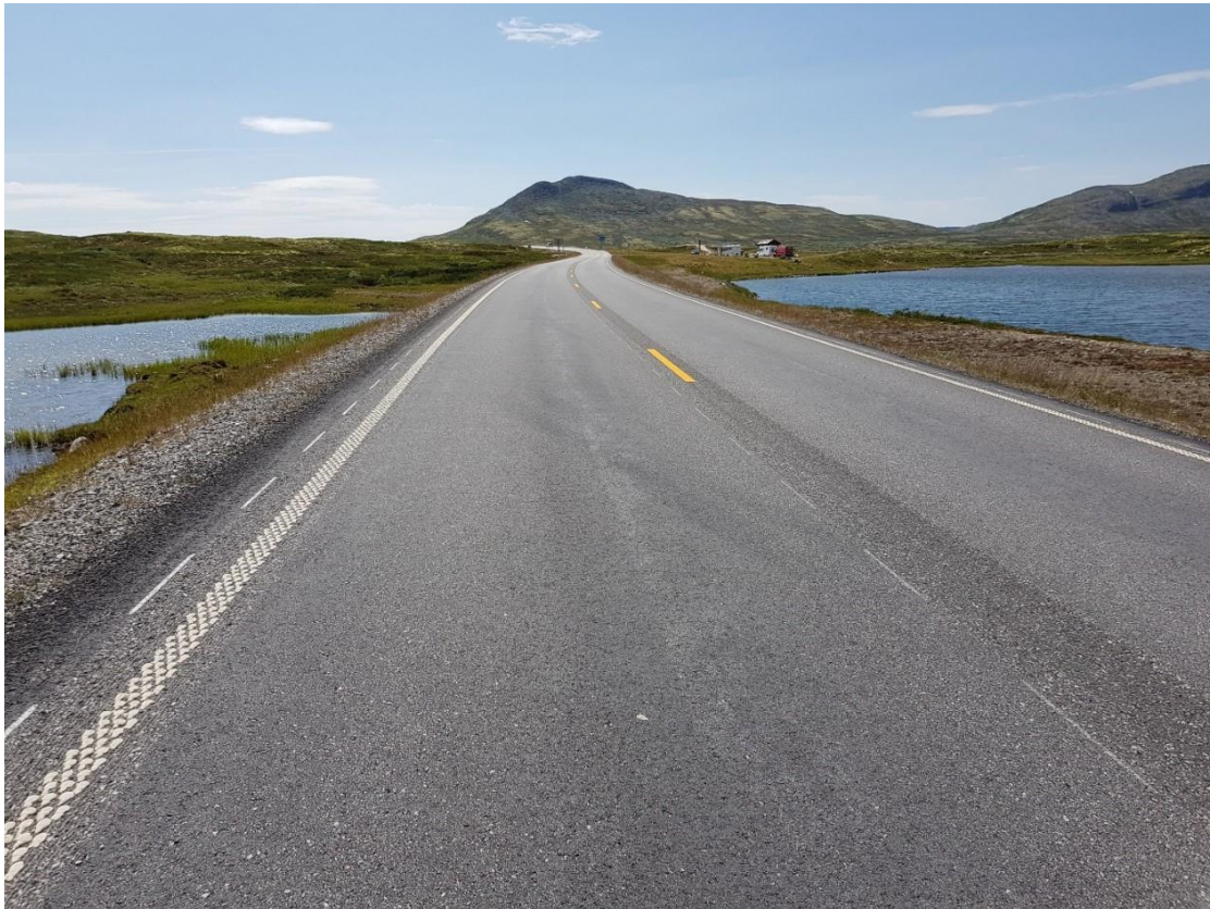
Figur 4: Plan nedfresing av midtlinje på Fv27 over Venabygdsfjellet (Foto: Terje Giæver)
