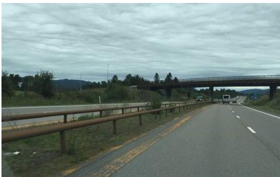
Figur 10: Rester med flak av gul vegoppmerking langs veg (Foto: Bjørn Skaar)
