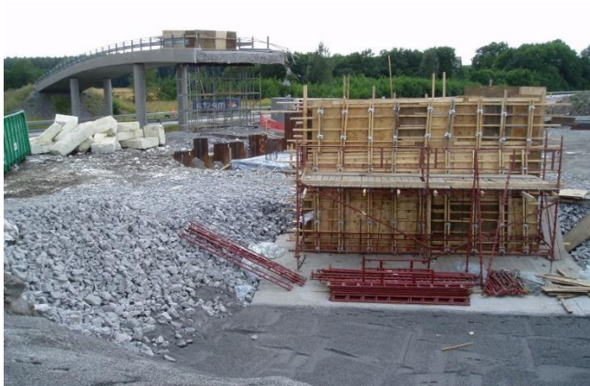
Figur 34. Hjelmungen bru. Utvidelse av E6/nytt fundament på EPS. Foto: T. H. Johansen
