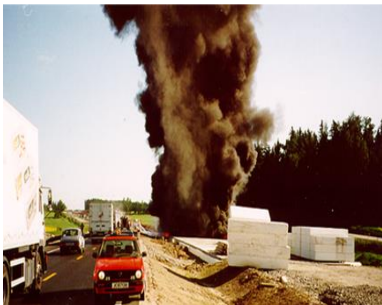
Figur 18. Brann i en EPS fylling under bygging, E6 ved Vestby. Foto Statens vegvesen
