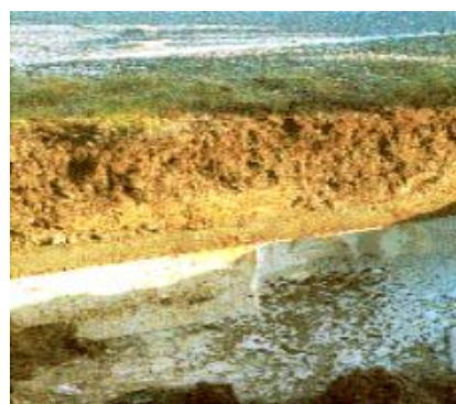
Figur 15. Vanninnholdsgradient gjennom en neddykket EPS fylling. Oppgraving av EPS fylling som har ligget neddykket i 9 år i Fv 610 ved Sande-Osen i Sunnfjord.
