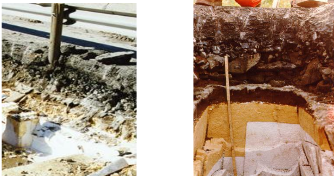
Figur 9. Utgraving av den første EPS fyllingen på Rv 159 Flom bruer. Foto Tor Helge Johansen
