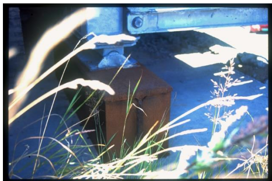
Figur 26. Landkaret ble hevet med 30 cm
