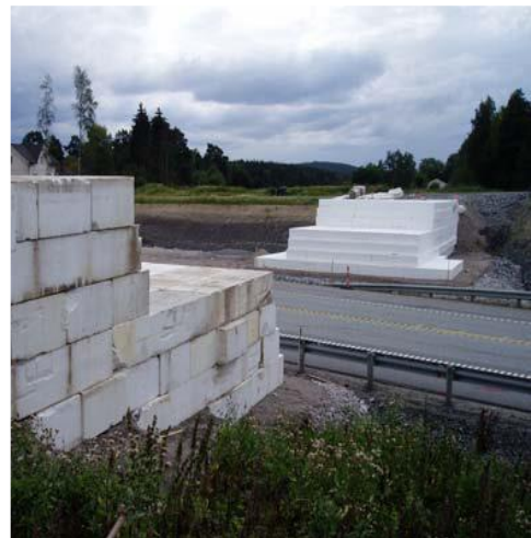
Figur 36. E6 Grimsøyvegen bru. Midlertidig bru fundamentert på EPS. Foto: Roald Aabøe
