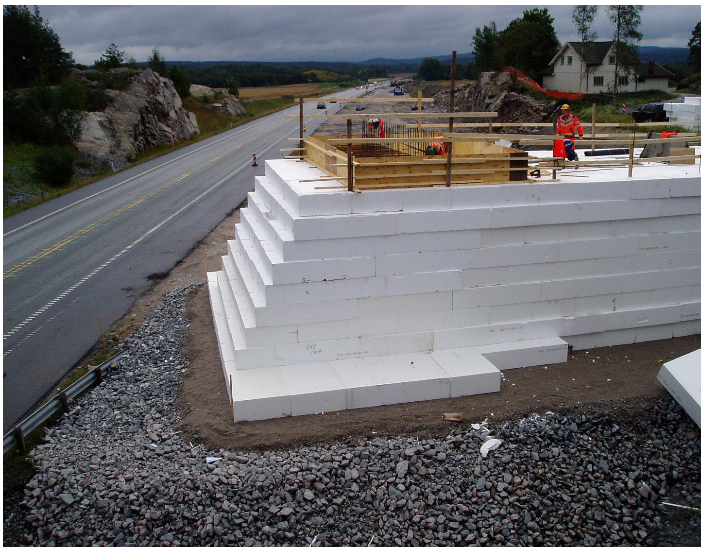
E6 Grimsoyveien bru. Fundamentering av bru på EPS fylling. Foto: Henriette Busterud, Statens vegvesen
