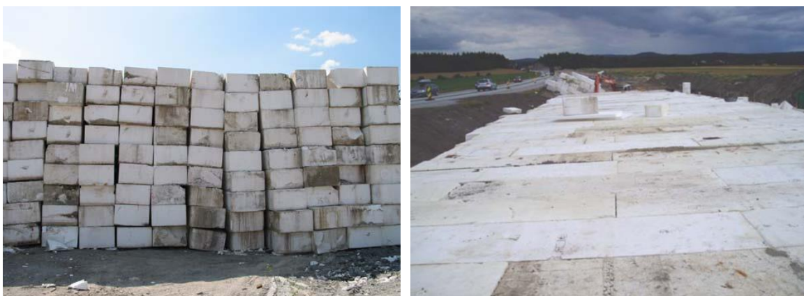
Figur 12. Gjenbruk av EPS blokker fra Løkkeberg bru
