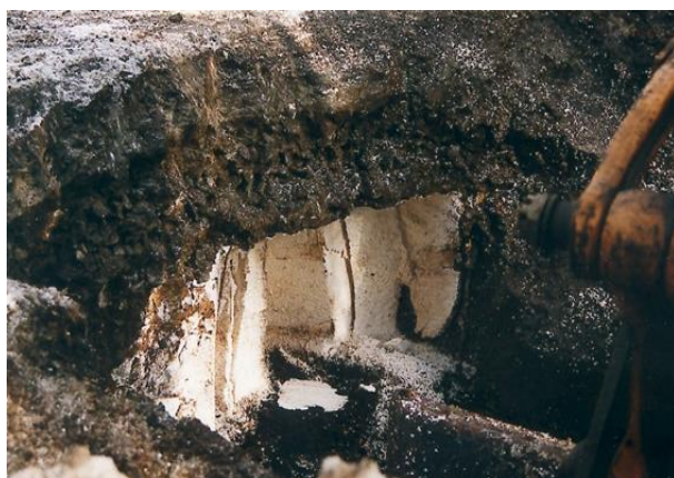
Figur 7. Utgraving for prøveprogrammet med gravemaskin og motorsag og med varmetråd.. Foto fra Vd rapport 33 og masteroppgave Brattensborg G.
