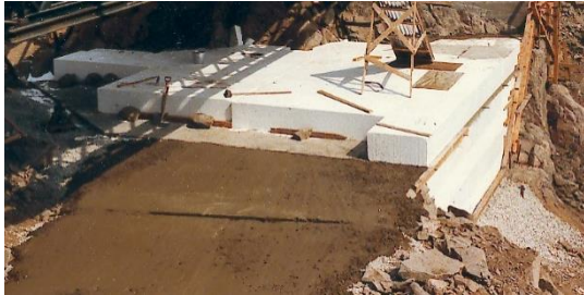
Figur 28. Støping av betongplate mellom EPS lag. Foto Statens vegvesen
