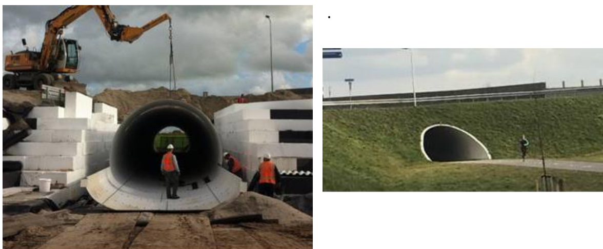
Figur 75. Korrugert stålrør hvor EPS optimaliserer konstruksjonen. N222 Haag. Foto: Infradelft
