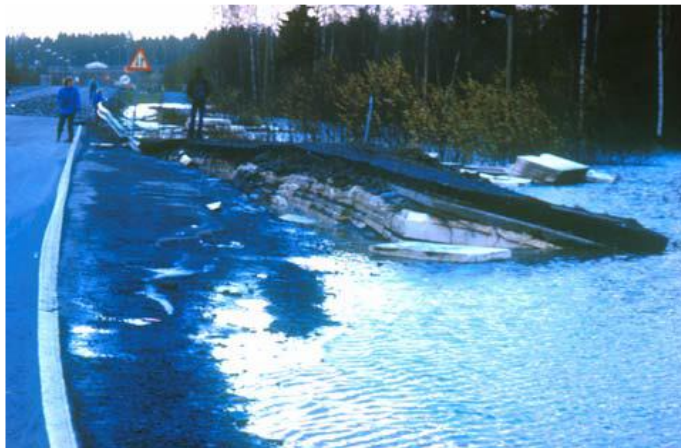
Figur 5. Oppdrift i EPS blokker. RV 159 . Foto: Arvid Sagbakken, Statens vegvesen
