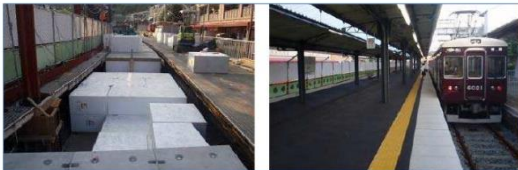
Figur 72. Jernbanepattform i Japan under bygging. Foto:EDO
