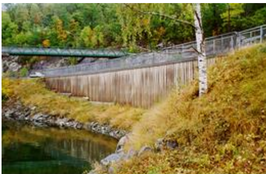
Figur 31. E6 (Daværende) ved Nesset. Enkle EPS utforminger med vertikale vegger. Foto:: Roald Aabøe, Statens vegvesen
