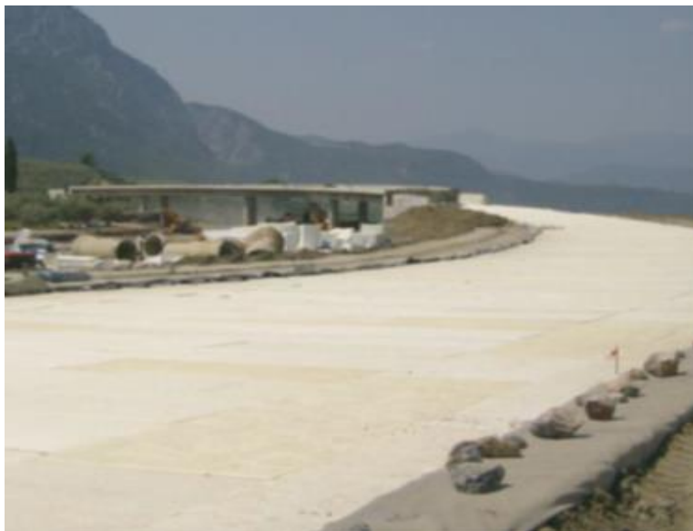
Figur 74. 65.000 m 3 EPS-blokker på E 75 ved Thermopylene, Hellas (Bilde: Sotiropoulos & Associates SA)
