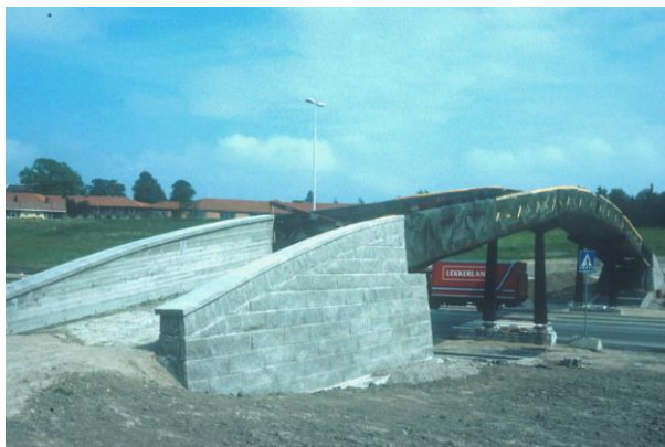
Figur 67. Rv 109 Rolvsøyvegen. Gangbruer fundamentert på EPS. Foto: Statens vegvesen
