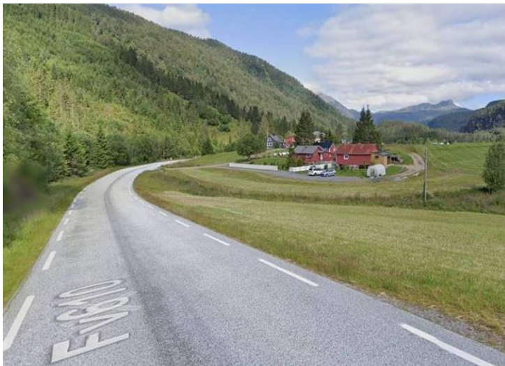
Figur 56. Myrbrua av EPS 30 år etter bygging. Foto Simen Hermansen.
