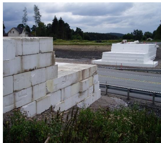
Figur 65 Fyllinger for interimsbru over E6 ved Grimsøyveien Foto: Tor Helge Johansen. Statens vegvesen
