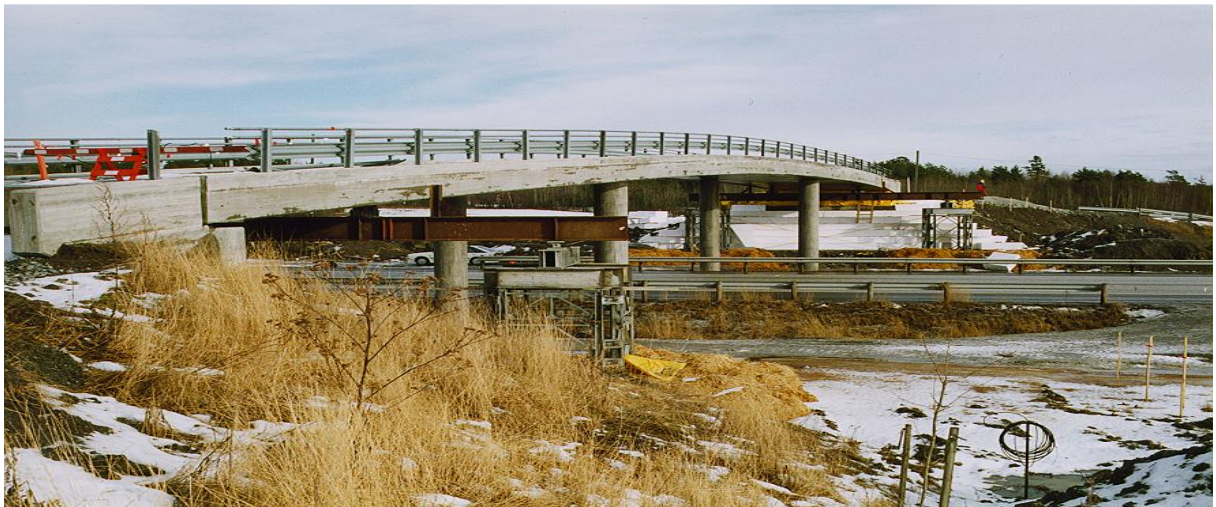
Figur 64. Oppbygging av EPS-fyllinger. Brua bæres av midlertidige understøttelser. Foto: Tor Helge Johansen. Statens vegvesen
