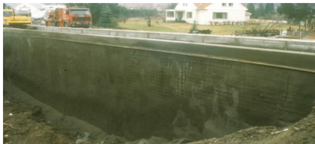
Figur 34. Ny trikkelinje ved kryssing av Gaustadbekkdalen, Oslo. Kledning med sprøytebetong. Foto: Statens vegvesen
