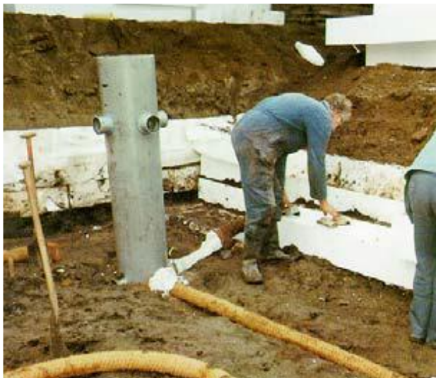
Figur 57. Drenering / infiltrering av vann i en neddykket konstruksjon i Nederland. Foto Roald Aabøe
