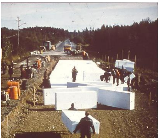
Figur 18. Rv 159 flom bruer. Verdens første EPS fylling under bygging og senere oversvømmet i en flomsituasjon. Foto: Geir Refsdal og Arvid Sagbakken, Statens vegvesen
