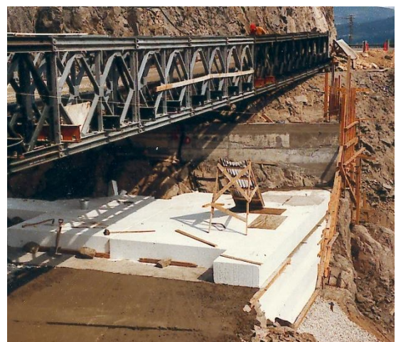
Figur 29. Eksempler på vertikale fyllinger med EPS. (Rv 5 Stedjeberg, Norge (Foto og illustrasjon: Statens vegvesen
