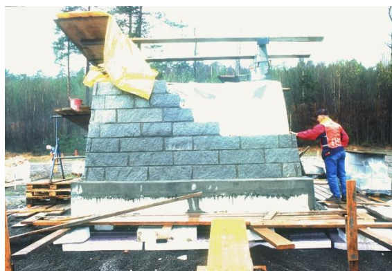
Figur 67. Rv 109 Rolvsøyvegen. Gangbruer fundamentert på EPS. Foto: Statens vegvesen
