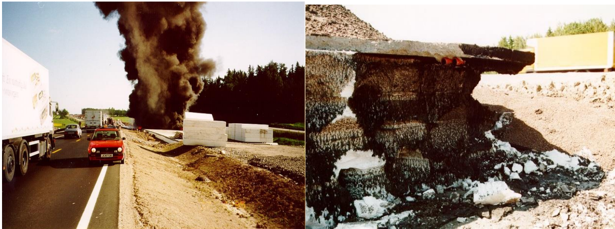
Figur 11. Antenning av EPS fyllinger. E6 Vestby 1995. Foto: Statens vegvesen
