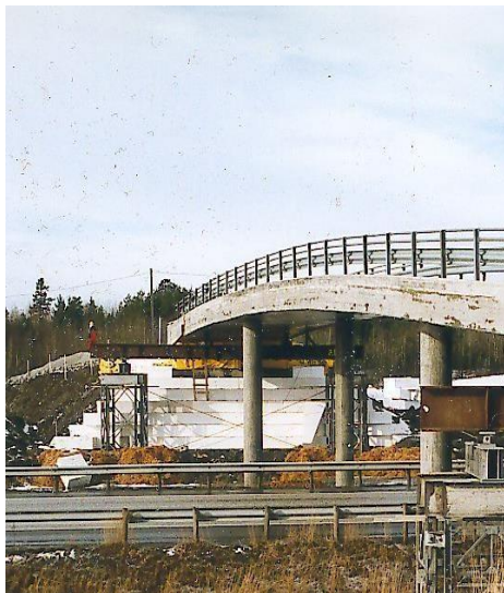
Figur 2. Innovativ løsning for fundamentering direkte i en EPS fylling. E6 Hjelmungen. Foto: T. H. Johansen, Statens vegvesen
