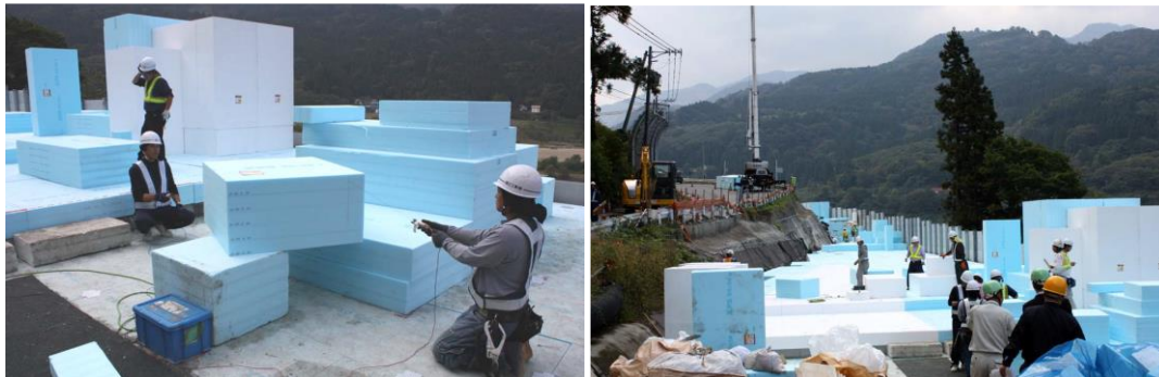
Figur 42. Otario road (Japan). Bygging av 17 meter høy EPS fylling. Bruk av varmetråd til kutting av blokker. Foto K. Aunaas/ A.Slobodinski
