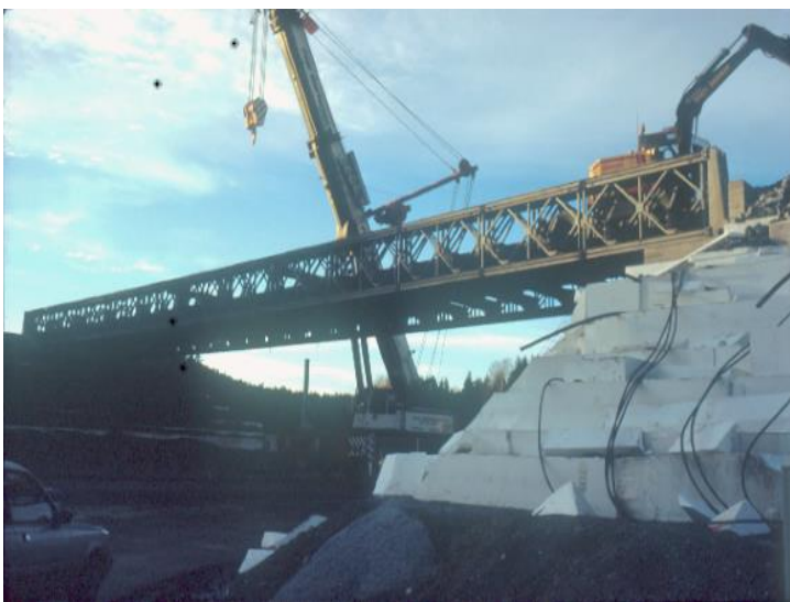
Figur 62. Fundamentering av Løkkeberg bru direkte på fyllinger av EPS-blokker, 1989 (Statens vegvesen)
