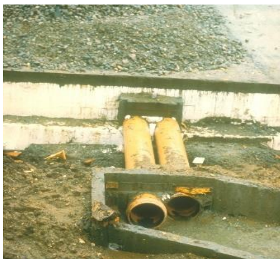
Figur 55. Rv 610. Regulering slik at vannstanden holdes konstant. Foto: Skildbrei.
