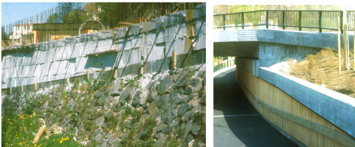
Figur 35. Arendal Øst– vest. EPS fylling. Foto: Statens vegvesen
