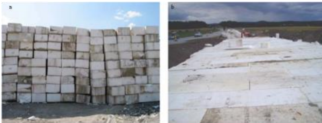
Figur 15. a) Lager av EPS blokker fra Løkkeberg bru, b) Gjenbruk av EPS blokker fra Løkkeberg bru (Foto: Statens vegvesen)
