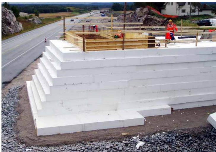
Figur 65 Fyllinger for interimsbru over E6 ved Grimsøyveien Foto: Tor Helge Johansen. Statens vegvesen
