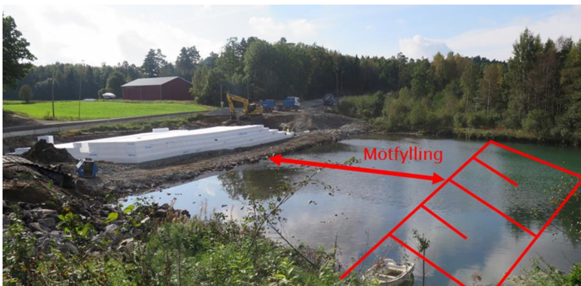
Figur 24. EPS fylling på FV 420 Sangereid Foto: Veslemøy Gardå, Statens vegvesen
