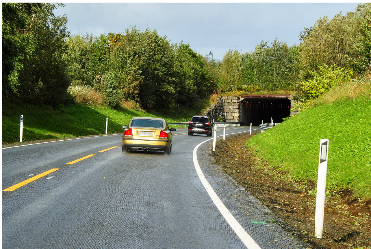
Kantstikker fremhever veiens forløp om natta. Langs E39 ved Vestnes i Møre og Romsdal. Foto: Knut Opeide, Statens vegvesen.
