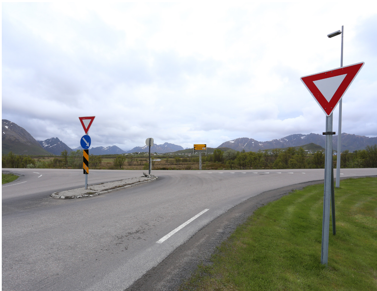
Kryss som det ikke er krav til lys i. Foto: Tomas Rolland, Statens vegvesen.
