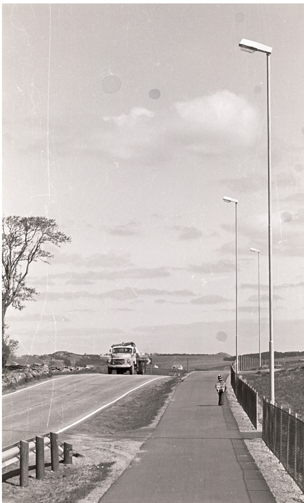
Innfartsårene var de første veiene som ble belyst utenfor tettsteder. Rv 44 Storhaug–Klepp i Stavanger i 1976. Fotografi: Arne G. Vasbø.
