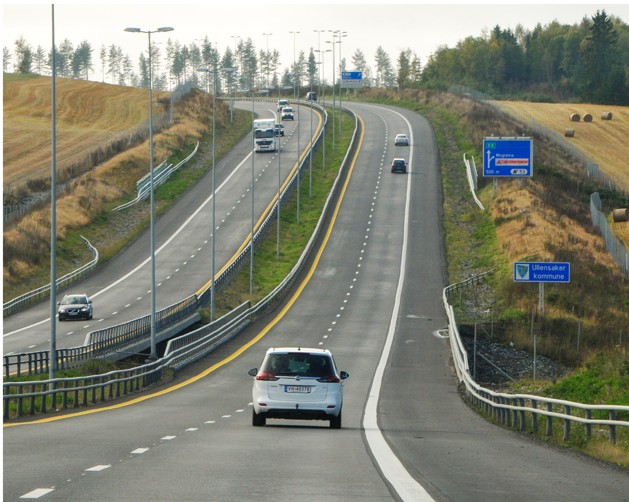
Motorvei med veilys, bred skulder, rekkverk, utbedret sideterreng, viltgjerde og slak kurvatur. E6 ved Mogreina nord for Gardermoen. Foto: Knut Opeide, Statens vegvesen.
