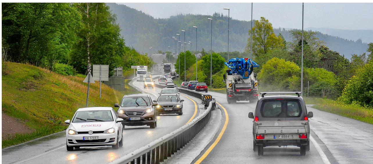
Det er krav om veilys på veier bygd med dimensjoneringsklasse H2, såkalte motortrafikkveier. Foto: Knut Opeide, Statens vegvesen.
