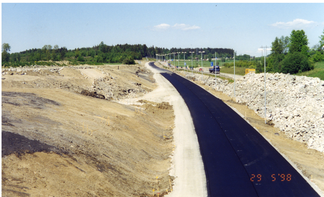
På 90-tallet ble det bygd mye veilys, her fra bygging av motorvei med veilys på E6 i Vestby i 1998. Foto: Statens vegvesen
