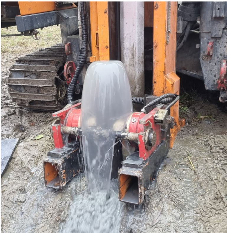
Figur 11 Bilde av vannstrøm inni og på utsiden av foringsrøret under nedpressing av foringsrør. Foto: Daniel Jergling.
