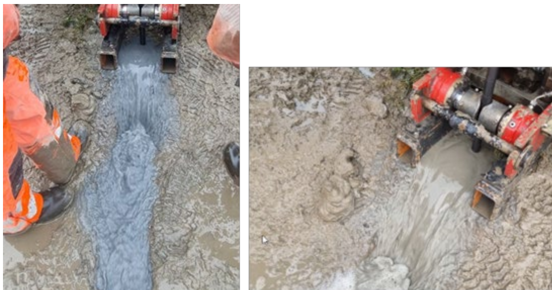
Figur 9 Bilde fra 4. tetteforsøk utført den 16.10.2024 med modifisert utstyr. Til venstre: vannstrøm opp før injisering. Til høyre: vannstrøm opp etter injisering med AUV mørtel, vannet har tydelig endret farge og viser at AUV mørtelen blir vasket opp. Foto: Daniel Jergling
