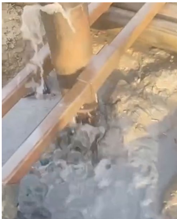
Figur 13 Til venstre: bilde av lekkasje med 2 m ekstra foringsrør over terreng, dvs. stighøyde på ca. 2,3 over terreng. Til høyre: Etter 15 minutter strømmer vannet på utsiden av røret. Foto: Bjørn Wold.
