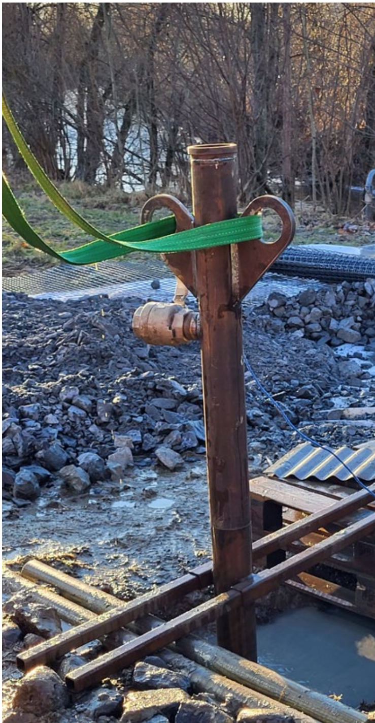
Figur 25 Bilde av vannstrøm som er etablert på utsiden av foringsrøret, og pumperøret er satt på. Foto: Knut Arne Tho.
