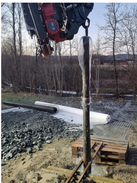
Figur 24 Bilde av gravemaskinen som heiste røret ca 10 cm og senket det rolig ned igjen. Foto: Daniel Jergling
