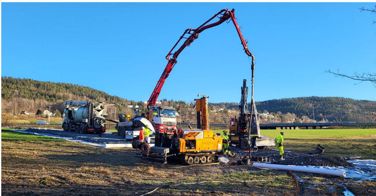
Figur 27 Bilde av pumpebilen som pumper mørtel ned, her hadde bil 1 kjørt opp, bil 2 leverer mørtel mens bil 3 var på vei ned. Foto: Knut Arne Tho
