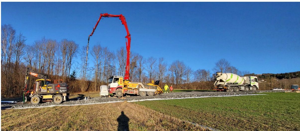
Figur 26 første pumpebil rygger ned mot pumpa. Gravemaskin står på siden av foringrøret, pumpebil står ovenfor røret, og det var plass til to betongbiler bak pumpa. Foto: Knut Arne Tho.
