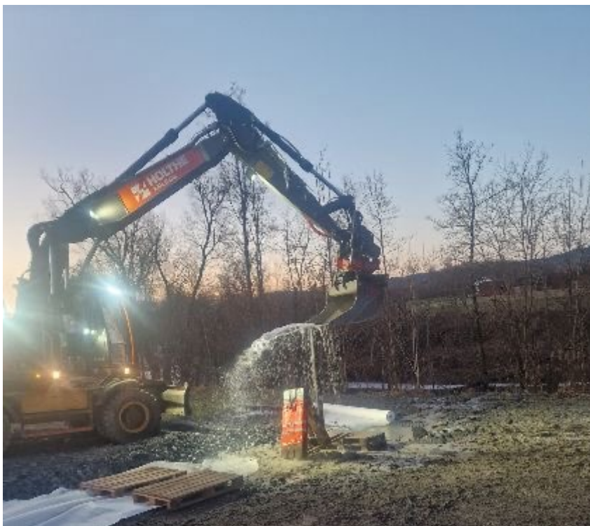
Figur 23 her legger graveskuffen på litt trykk, det ble etter hvert skrudd på et lokk som var delvis tett. Foto: Martin Møller
