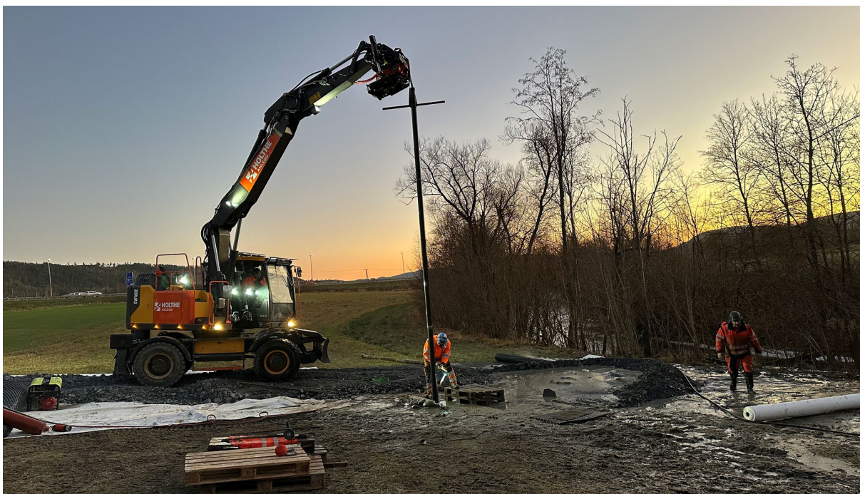
Figur 31 Bilde som viser heising og kapping av røret. Foto: Heidi Kjennbakken
