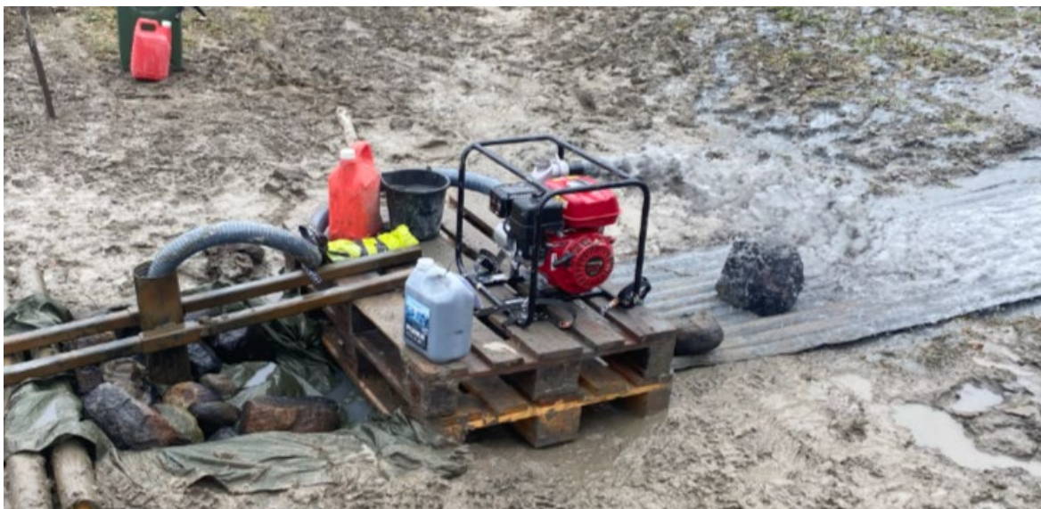
Figur 12 bilde av foringsrør som blir pumpet for å få vannstrømmen inn i foringsrøret. Foto: Bjørn Wold.
