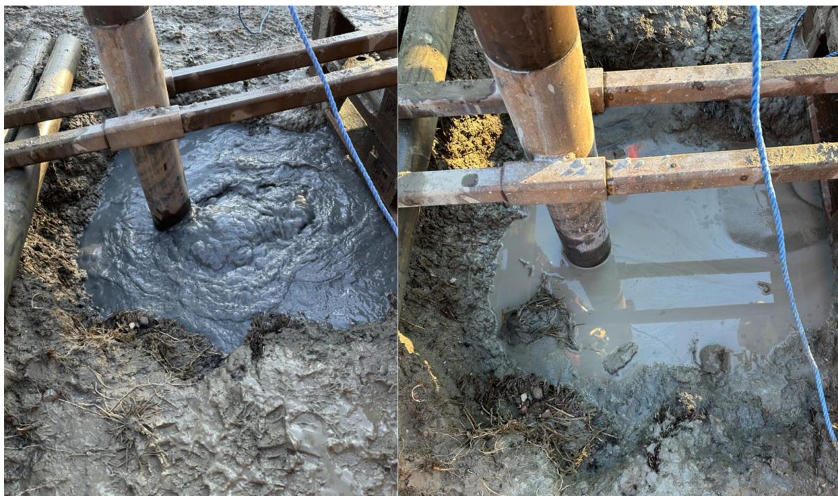
Figur 29 Bildet til venstre viser hvordan vannet strømmet opp i starten, mens bildet til høyre viser hvordan vannet endret farge og seighet da vi hadde fylt ca 40 m 3 . Foto: Heidi Kjennbakken
