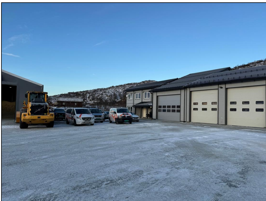
Figur 7. Leiro brøytestasjon. Foto: Kjell Grønsberg, Statens vegvesen
