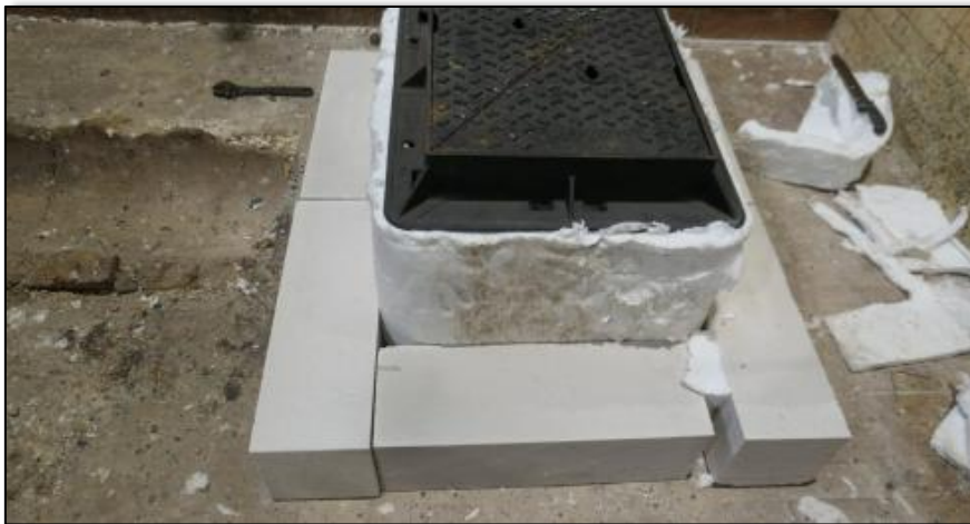
Figur 7 Fotografiet viser hvordan kummen er dekket med fiberisolasjon (fire master) og lettbetong (Siporex). Foto: RISE Fire Research.
