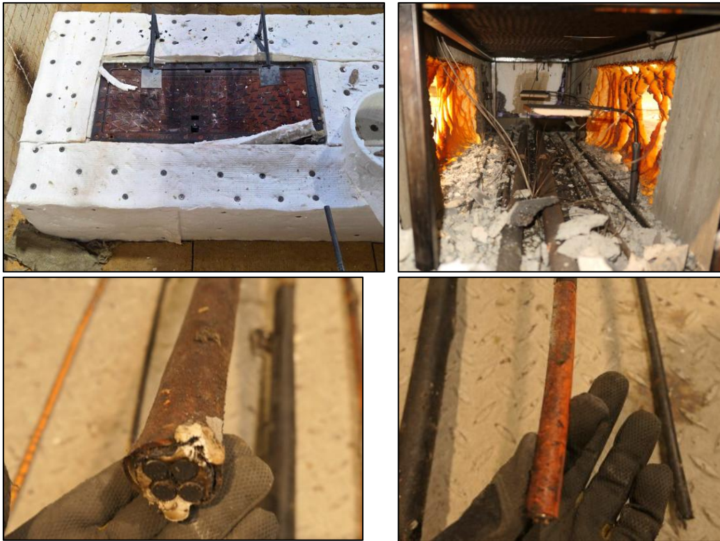
Figur 31 Bildene over viser tilstanden på kummer og kabler etter gjennomført test. Foto: RISE Fire Research.
