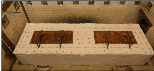
Figur 9 Bildet viser trekkekummene isolert med Siporex på kort- og langside. Foto: RISE Fire Research.
