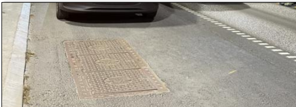
Figur 34 Bildet viser hvordan kumlokk og bakken ligger i flukt i en havarinisje. Foto: Ole Pedro Myklebostad, Statens vegvesen.
