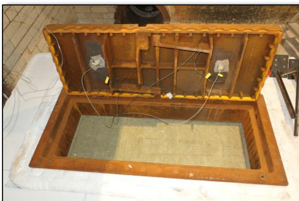
Figur 24 Bildet viser hvordan trekkekum TK2 Tunnel er isolert med 3 cm steinullisolasjon. Foto: RISE Fire Research.
