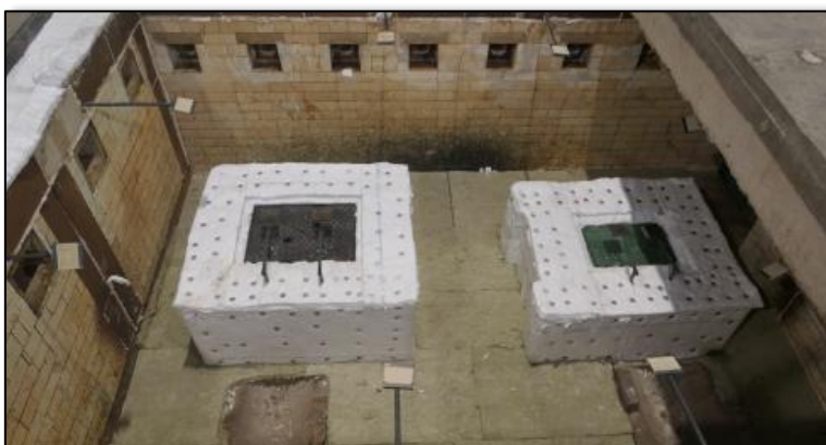
Figur 12 Bildene viser trekkekummer i HDPE-materiale plassert i brannmotstandsovn for testene ble igangsatt. Foto: RISE Fire Research.
