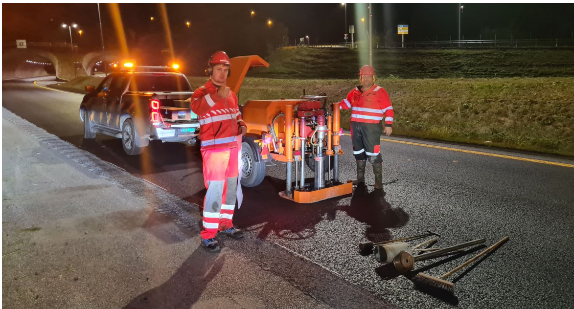
Figur 1: Utboring av asfaltkjerner. Foto: Kim Rune Grannes, Statens vegvesen
